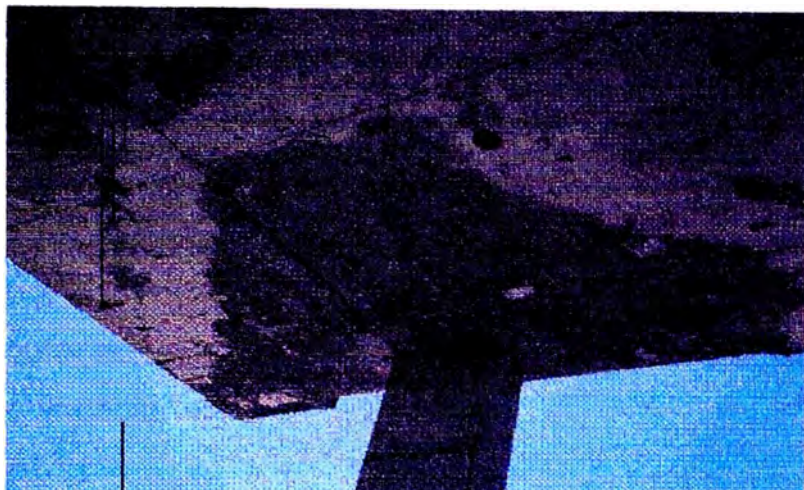
Fig. III-2 Ejemplo del “efecto hongo”. Nótese la zona más oscura alrededor de las columnas que corresponde a un concreto de 60 MPa. (Ref. 20)
