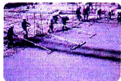
Fig. I-1 Acabado de una losa pasada y sin espera del CAR con microsílce (Ref. 21)
