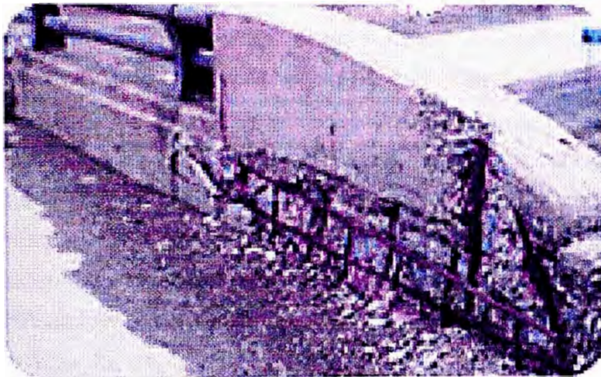
Fig. III-1 Ingreso de agentes agresivos por medio de los circuitos de aire incluido (Ref. 21)
