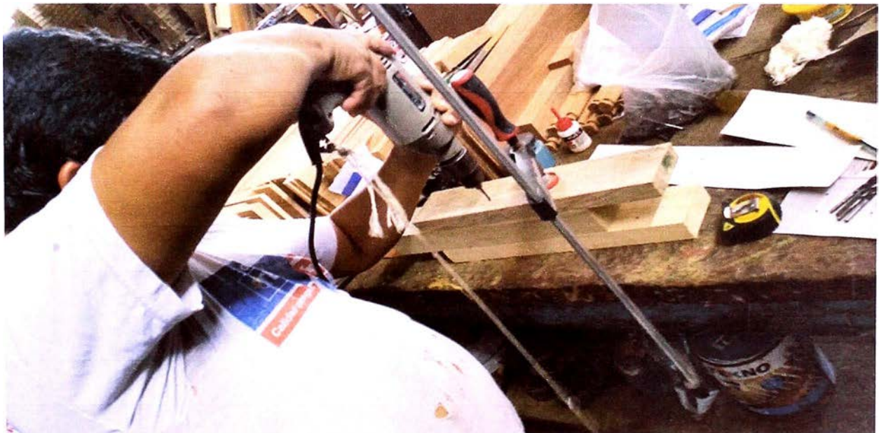
Figura 32: Pretaladrado con broca de diámetro 0.8d. Fuente: Propia.
