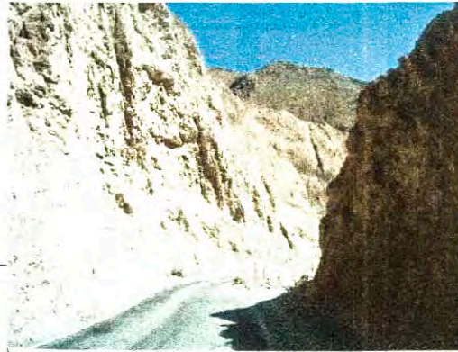
FOTO N°01 Vista de la Zona de Derrumbes (Sector Crítico)
