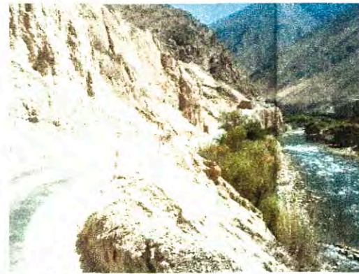
FOTO N°02 Vista del Sector Crítico por Derrmbes y Erosión del Talud
