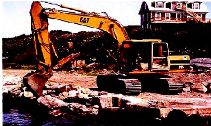
Figura 11 Foto: Colocación de enrocado con maquinaria
