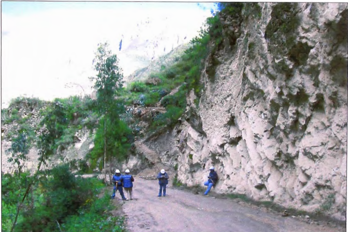
Foto N° 03: Toma de datos de la sección a evaluar; para la ampliación de la vía será necesario realizar actividades de corte.
