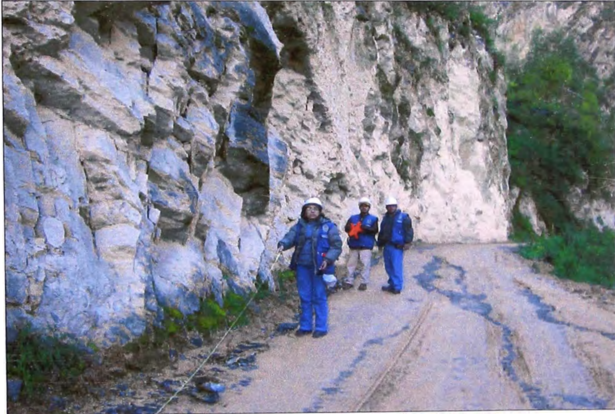
Foto N° 01: Ubicación de secciones del tramo en evaluación.
