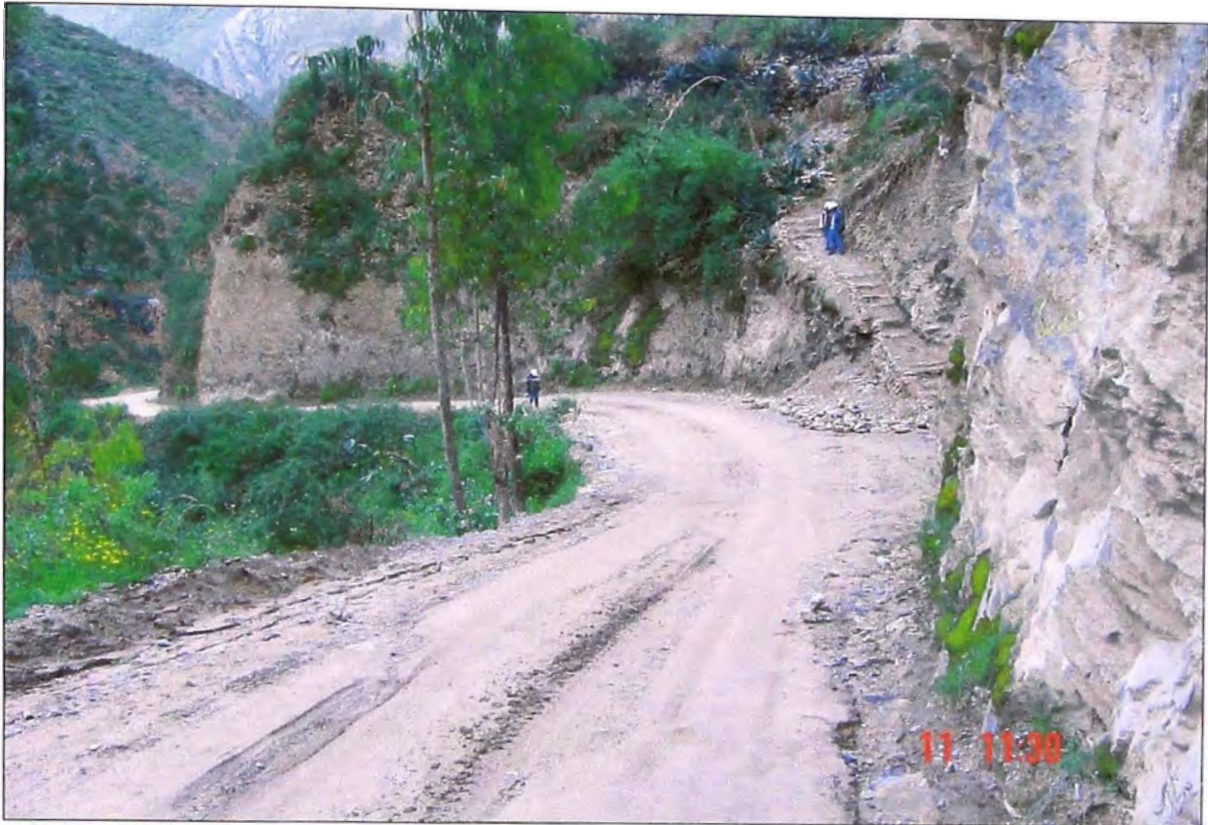
Foto N° 02: Exploración de la parte alta del talud izquierdo de la vía.
