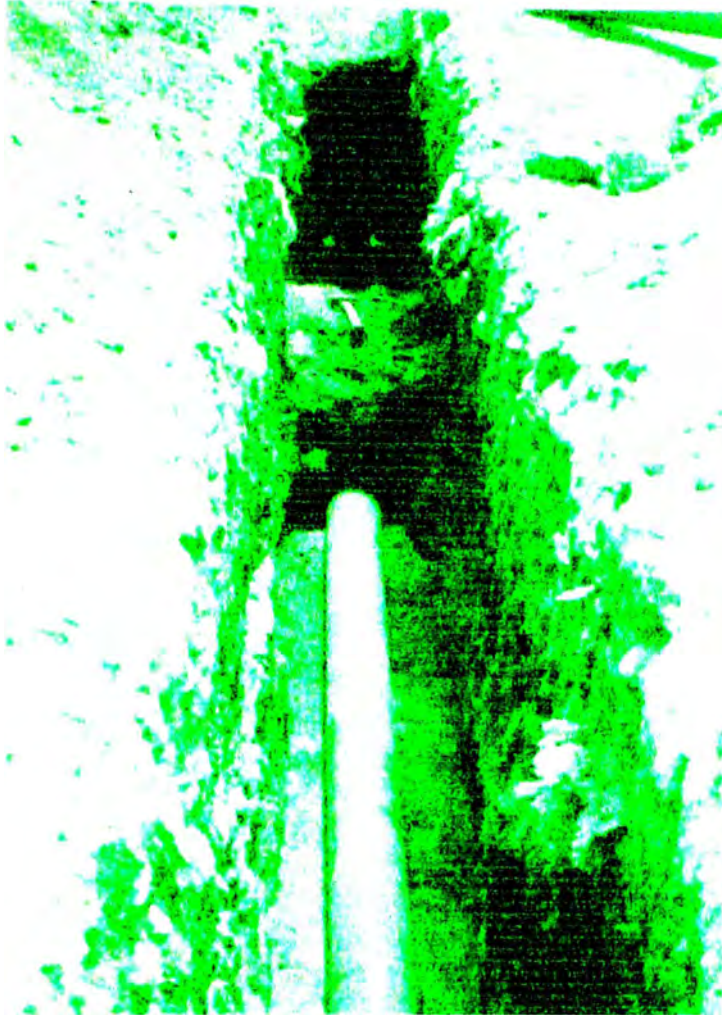
NIVELACION Y ALINEAMIENTO DE TUBERÍA PVC 8"
