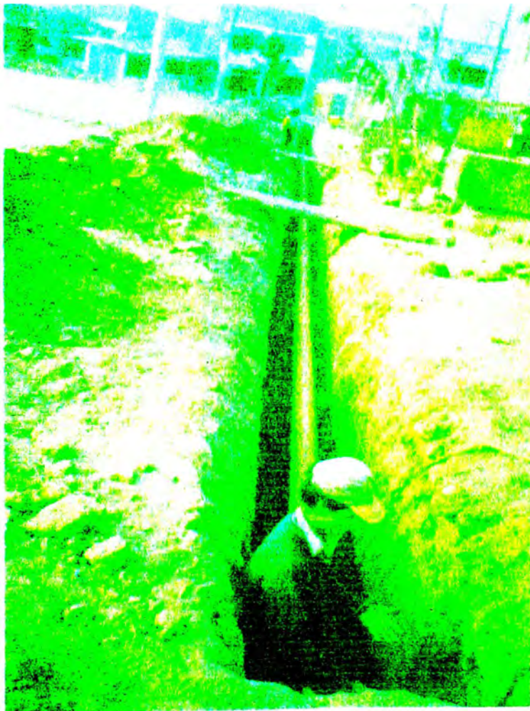
TUBERÍA INSTALADA EN ZANJA ( NIVELADA Y ALINEADA )
