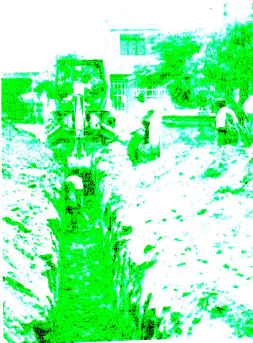
EXCAVACIÓN DE ZANJA A MAQUINA
