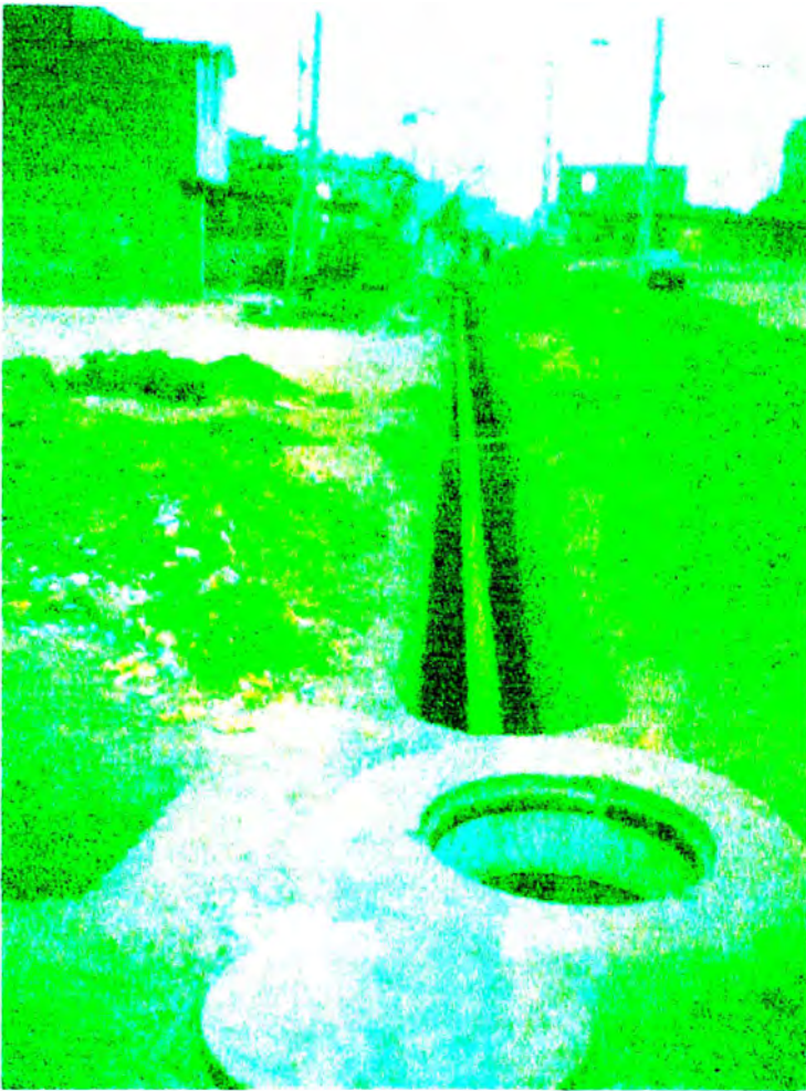
TUBERÍA INSTALADA EN ZANJA ( NIVELADA Y ALINEADA )
