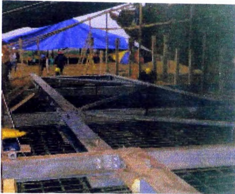
Fotografía N° 11. “Template” o Plantilla metálica usada para fijar los principales pernos de anclaje de las turbinas, este sistema fue proporcionado por el fabricante de Turbinas. No esta apoyado sobre el fierro ni el encofrado, tiene sus propios apoyos externos al encofrado.
