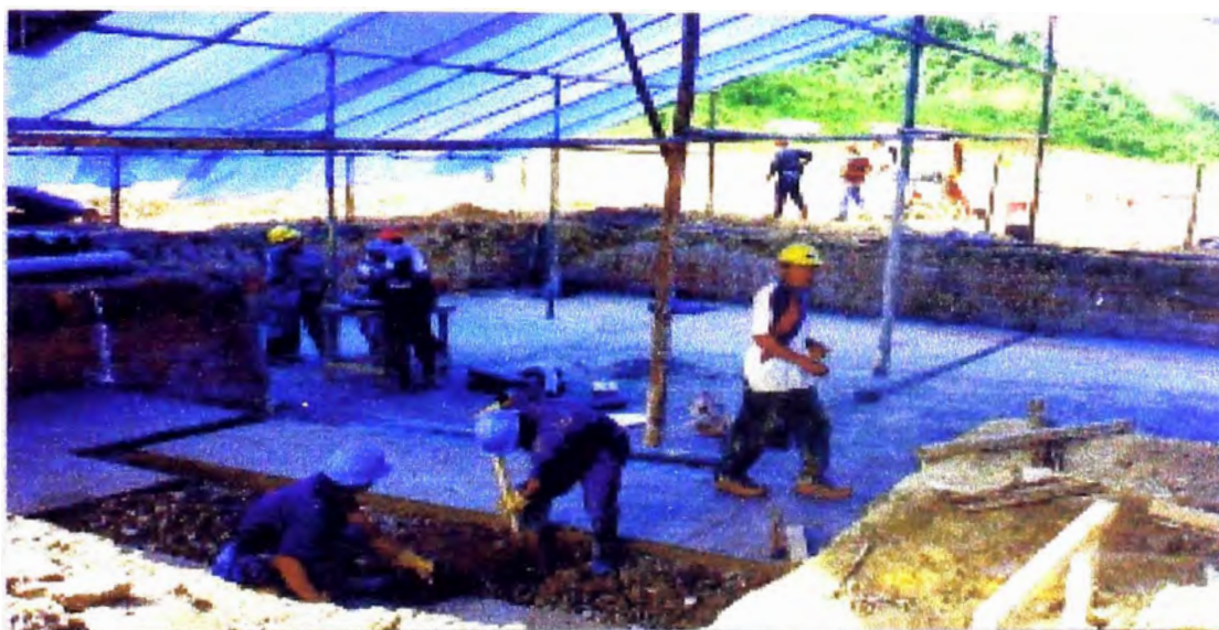
Fotografía N° 6. Trazado sobre el solado antes de la instalación del fierro corrugado y tuberías en zona de cimentación del transformador del GT 12. Se puede notar el corte de la excavación localizada y la protección con toldos de lona plastificada.
