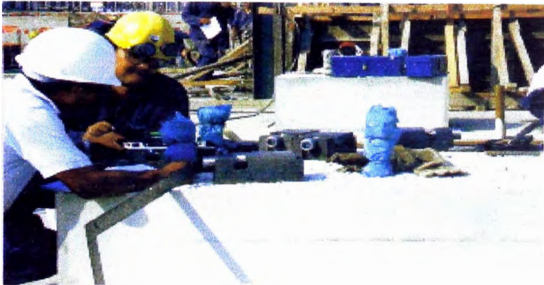
Fotografía N° 16. Proceso de ubicación de las “cuñas gatas”. Se puede observar el acabado rugoso de la superficie del concreto con la finalidad de buscar adherencia del grout que irá entre los equipos y el concreto armado.
