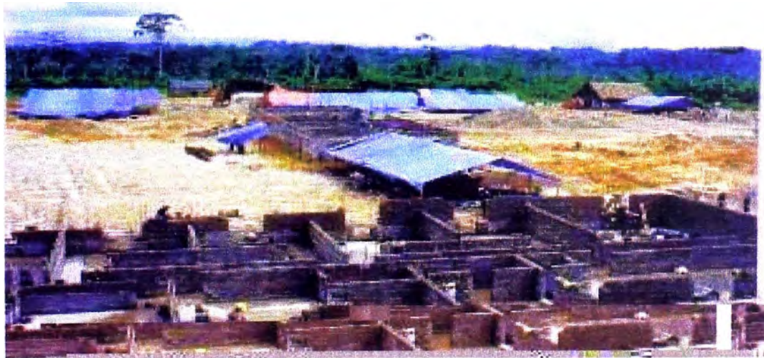
Fotografía N° 18. Central térmica Aguaytía en etapa de construcción, al fondo se tiene la zona de zapatas de turbinas, al centro el edificio de Control y mantenimiento y en la parte inferior el edificio Staff.
