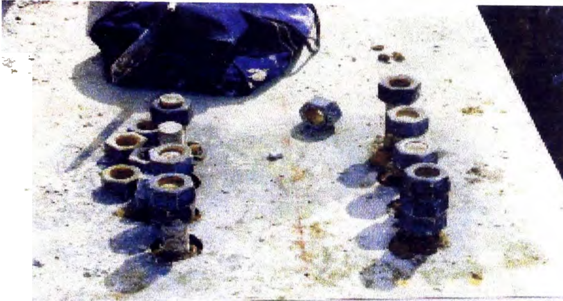
Fotografía N° 9. Limpieza de pernos de anclaje luego del vaciado de concreto, en este caso los pernos tienen una “camisa” que permite movimiento lateral inclinado, el vacío de la “camisa” será rellenado con Grout luego de la presentación de la estructura metálica en la zapata.
