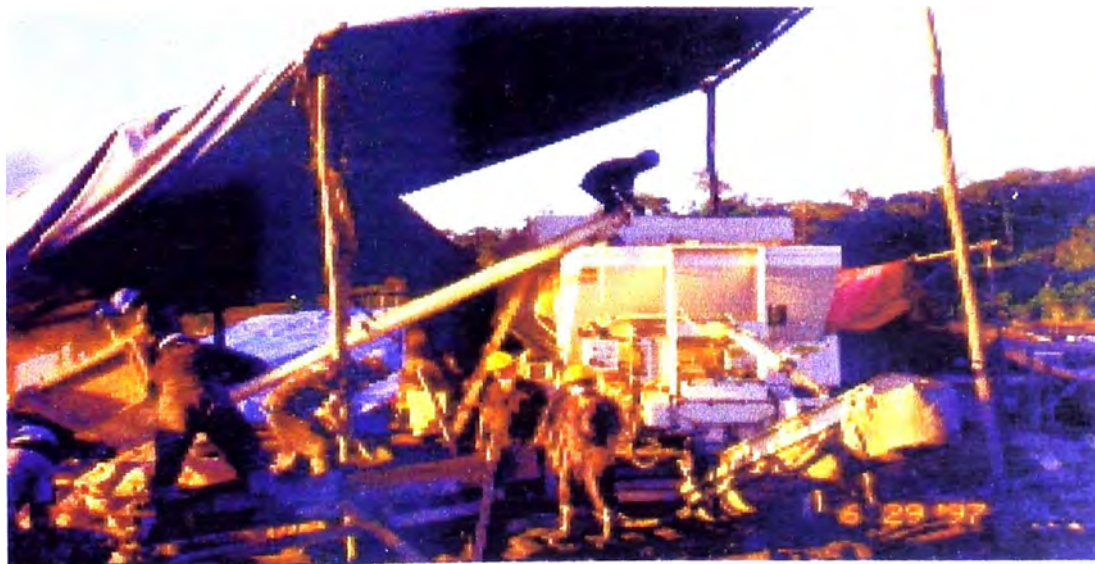
Fotografía N° 14. El vaciado de concreto algunas se facilitó ubicando la planta de concreto en posición adyacente al elemento vaciado.
