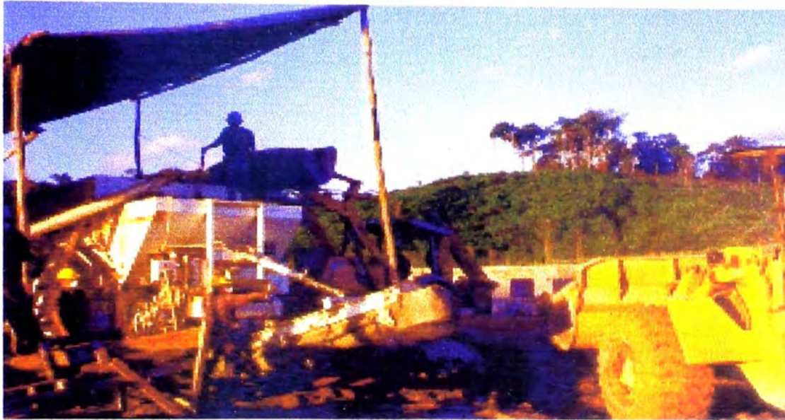
Fotografía N° 13. Planta de concreto durante un vaciado. Nótese la alimentación de hormigón con la retroexcavadora y la cercanía de un cargador frontal al extremo de la faja transportadora para cargar de concreto el cucharón de la máquina.
