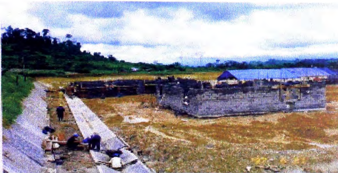
Fotografía N° 4. Trabajos de albañilería armada en los Edificios del departamento de Gerencia y Staff. También se puede notar la labor de sellado de juntas en las canaletas de drenaje, el acabado de la protección de taludes y la saturación del terreno luego de una lluvia.
