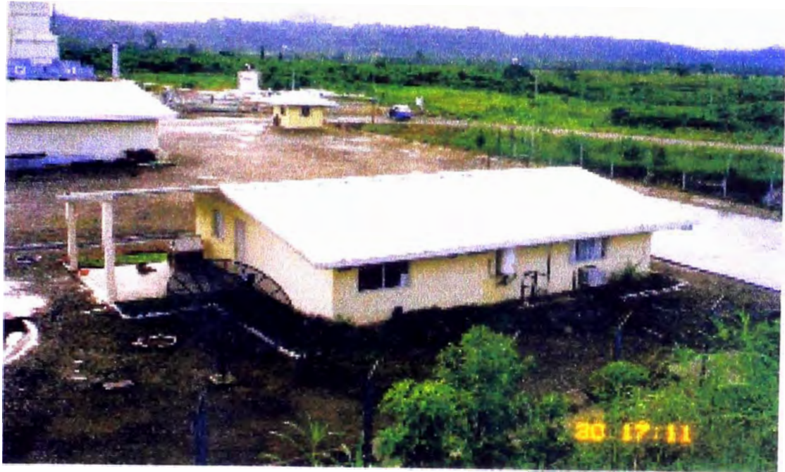
Fotografía N° 19. En primer plano el Edificio del departamento de Gerencia a tres años de culminada su construcción.
