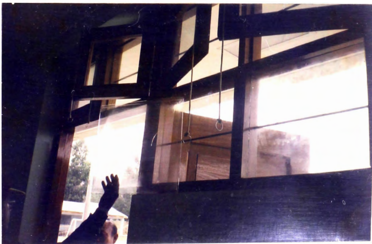
Foto N° 44: En esta vista se aprecia la ventana y puerta, terminadas y colocadas a su vez se aprecia las portafueltas de las ventanas con la soguilla y los aros.
