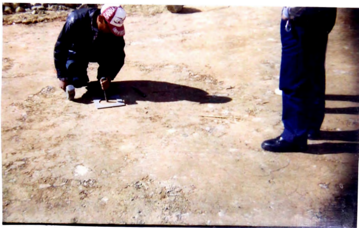
Foto N° 16: En esta toma el técnico comienza a sacar sus muestras para la determinación de la densidad de campo mediante la medida del volumen de la tierra extraída. Estas pruebas se realizaron donde iba a construirse la Losa Deportiva.
