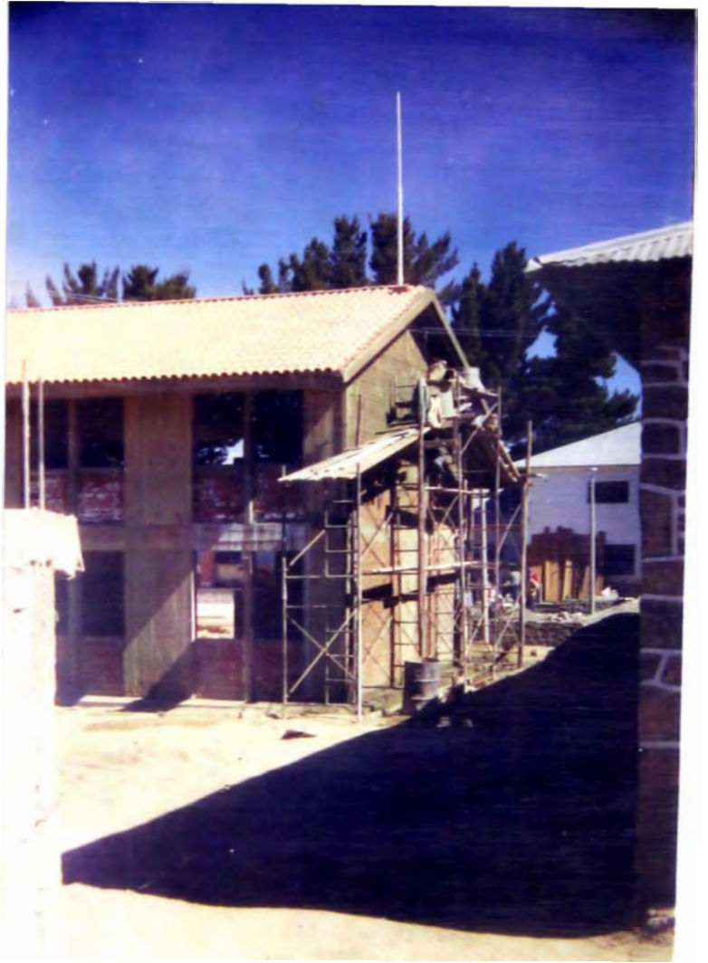
Foto N° 35: En esta foto se aprecia que han terminado de tarrajar el alero del modulo de aulas y van a comenzar con el tarrajeo del muro en ese lado.
