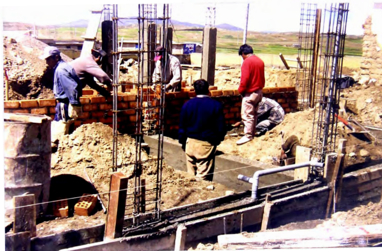
Foto N° 12: En esta toma se ve que se encuentran levantando los muros del módulo de los SS.HH., también se aprecia que se han dejado los pases de las Instalaciones sanitarias.
