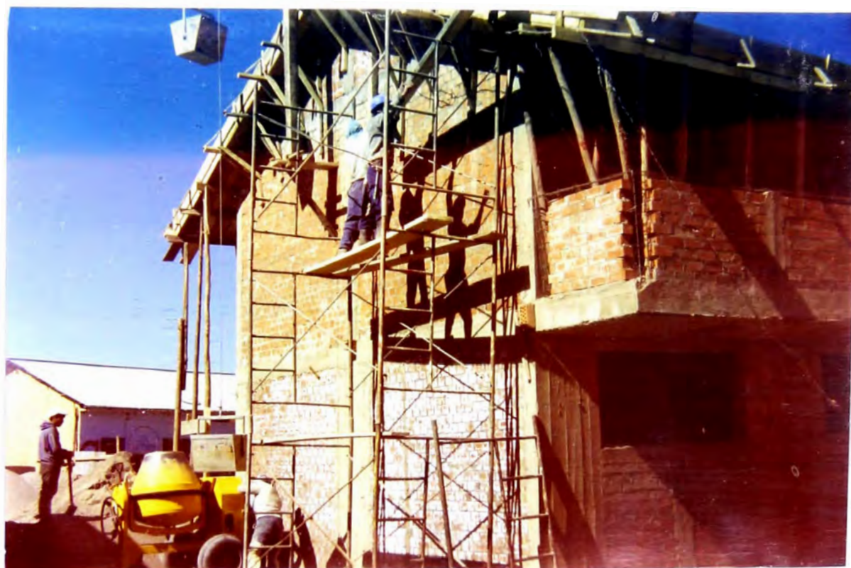
Foto N° 30: En esta vista se puede ver que los winches se encuentran listos para empezar con el vaciado de la losa del segundo nivel del módulo de aulas.
