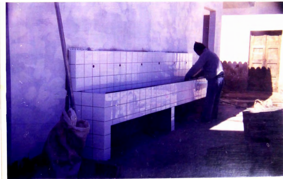
Foto N° 42: Se puede apreciar en esta toma al operario terminando con el enchape de mayólica del lavadero exterior correspondiente al modulo de SS.HH.
