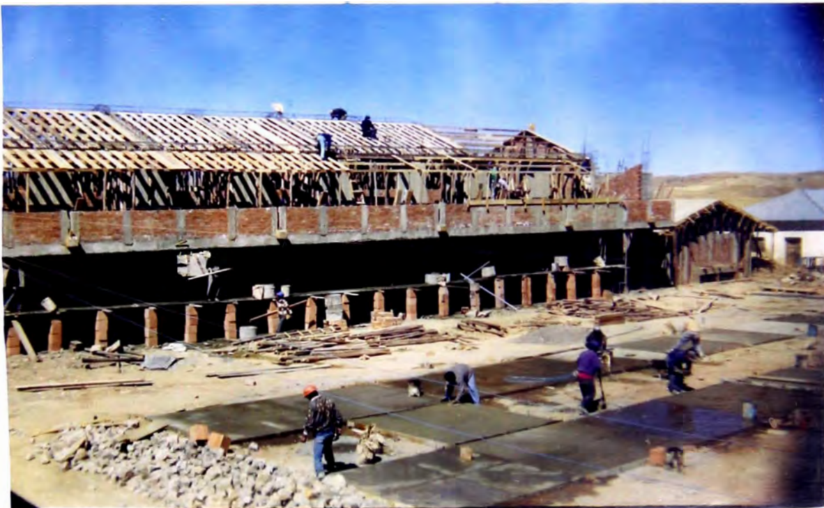
Foto N° 26: En el módulo de aulas se aprecia que el primer nivel se encuentran tarrajando el cielo raso del pasadizo y en el segundo nivel se ve que se encuentran avanzando con el encofrado de la losa aligerada, abajo se puede apreciar que siguen avanzando con la construcción de los paños de la losa deportiva.
