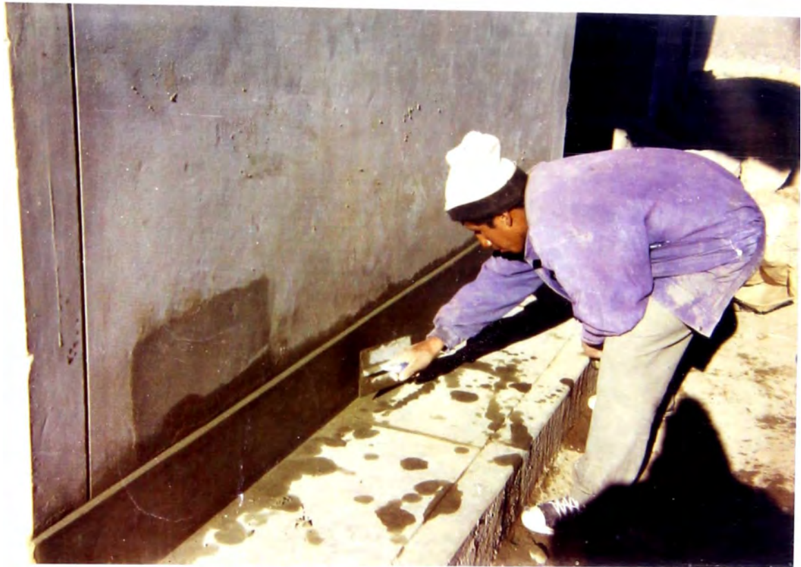
Foto N° 37: Aquí se muestra a un operario dando los acabados al contrazocalo exterior en el módulo de SS.HH.
