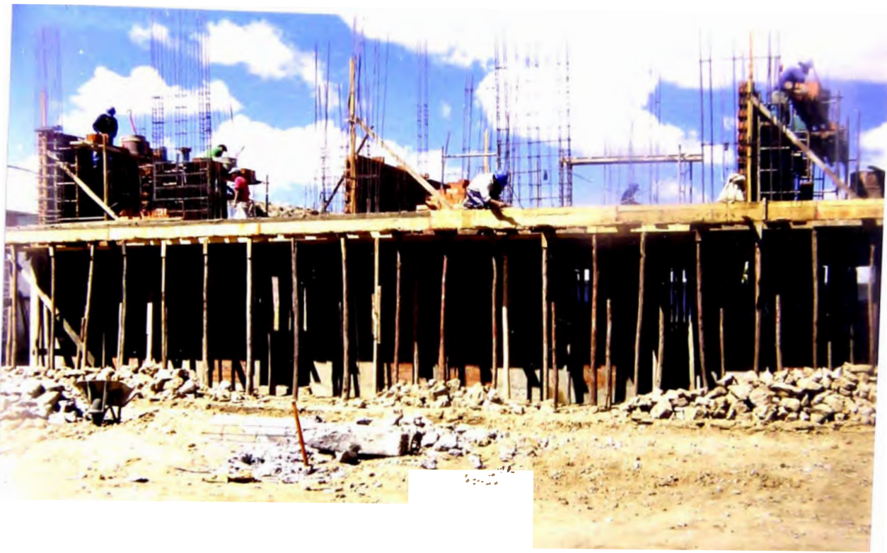
Foto N° 17: En esta toma se aprecia que se encuentran levantando los muros del segundo nivel del modulo de aulas.
