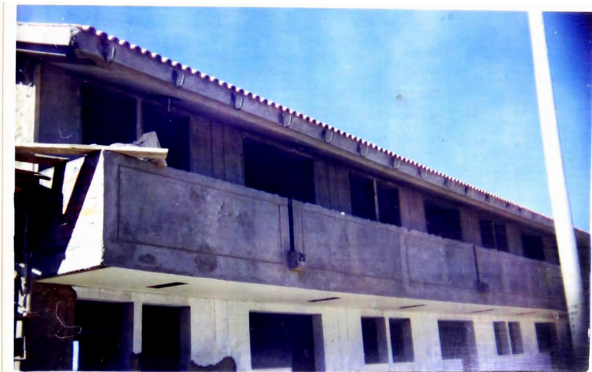
Foto N° 34: Aquí se ve los ganchos que van a soportar las canaletas de zinc, también se puede ver que el tarrajeo se encuentra bien avanzado.
