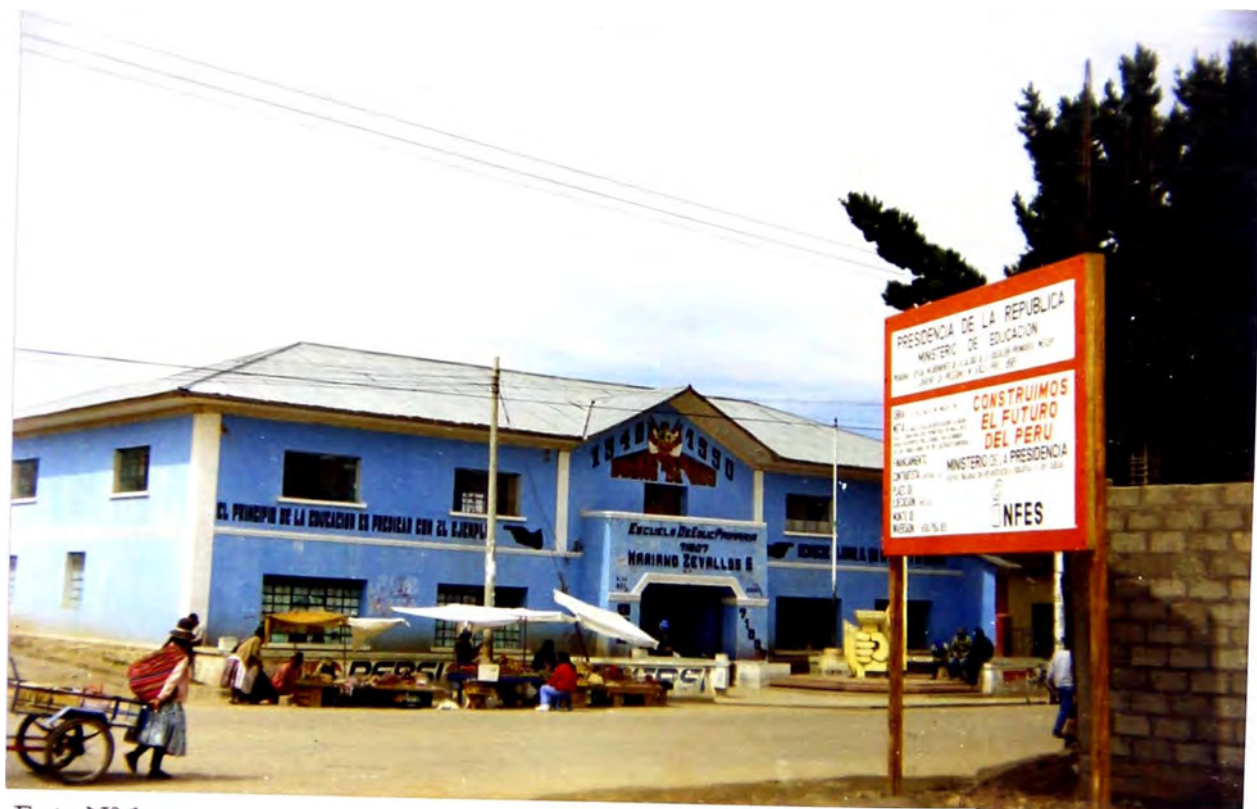
Foto N° 1: Vista de la Entrada principal del Centro Educativo N° 71007.
