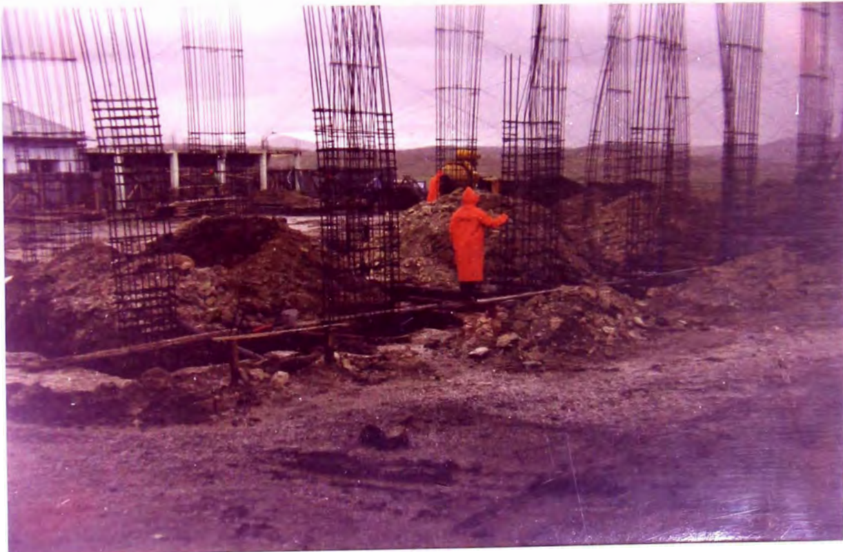
Foto N° 10: En esta toma podemos apreciar que esta comenzando a granizar y no nos permite avanzar con la obra.
