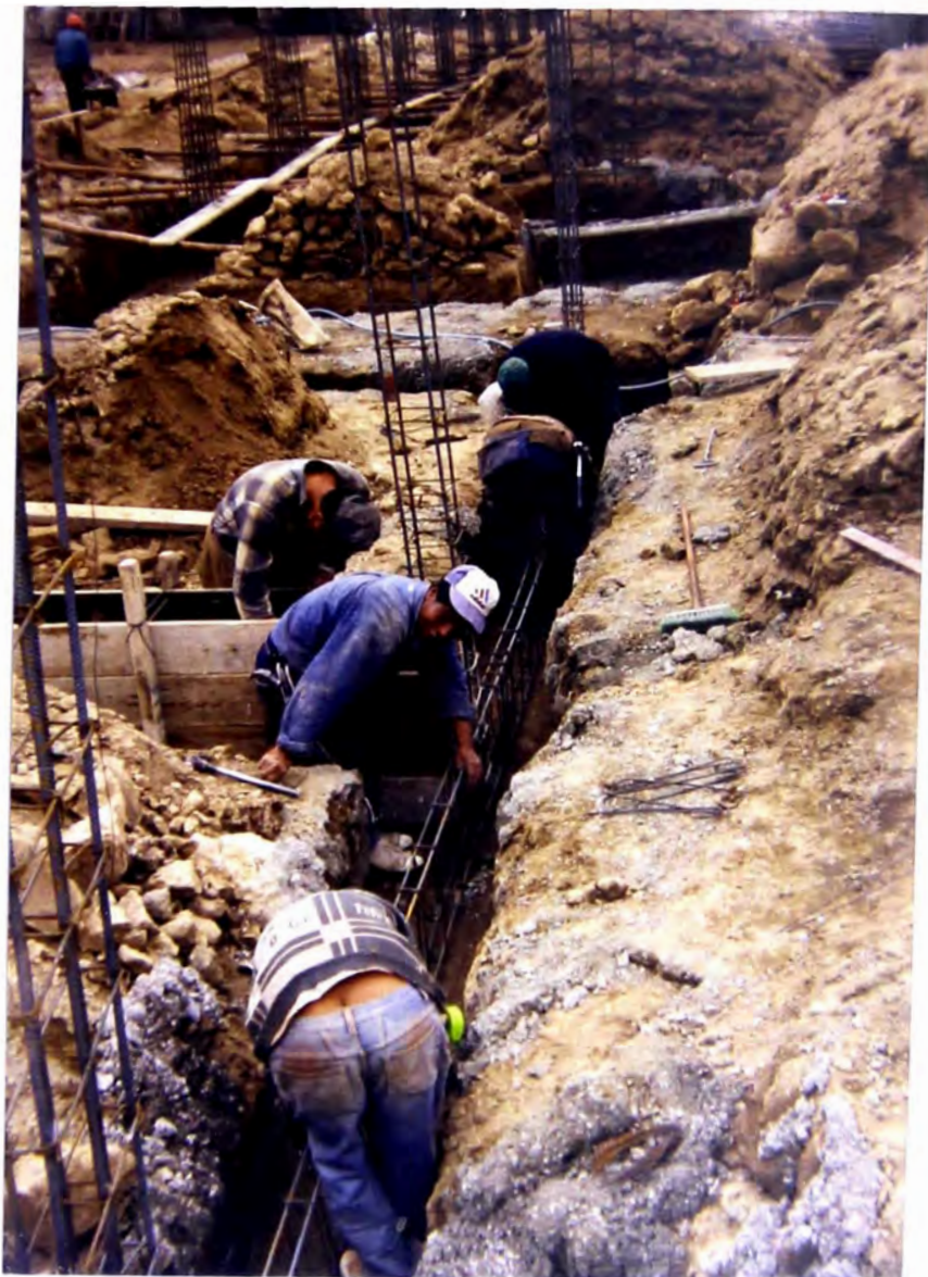
Foto N° 11: En esta imagen se aprecia el encofrado de la viga de cimentación del módulo de los SS.HH.
