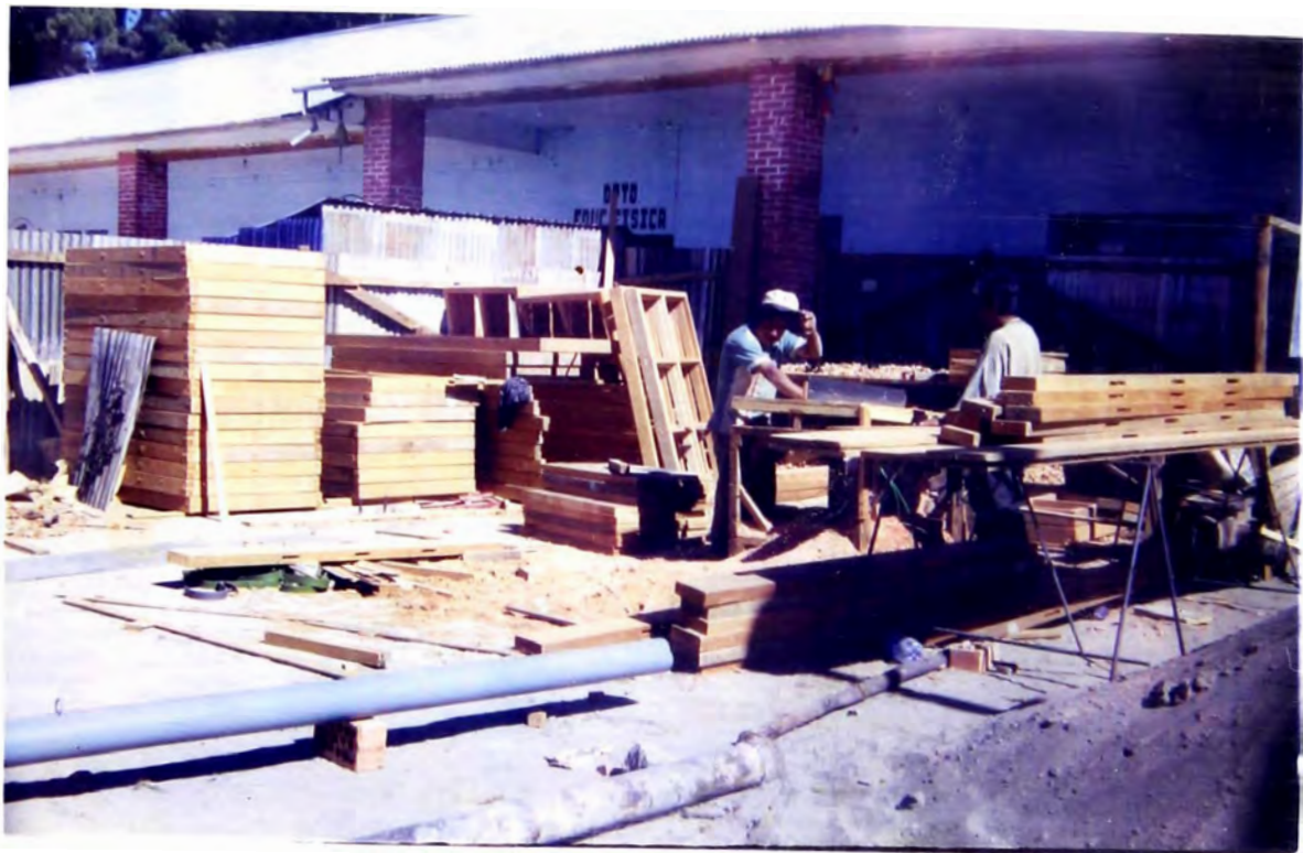
Foto N° 39: Acá se aprecia a los maestros carpinteros fabricando las ventanas de madera.
