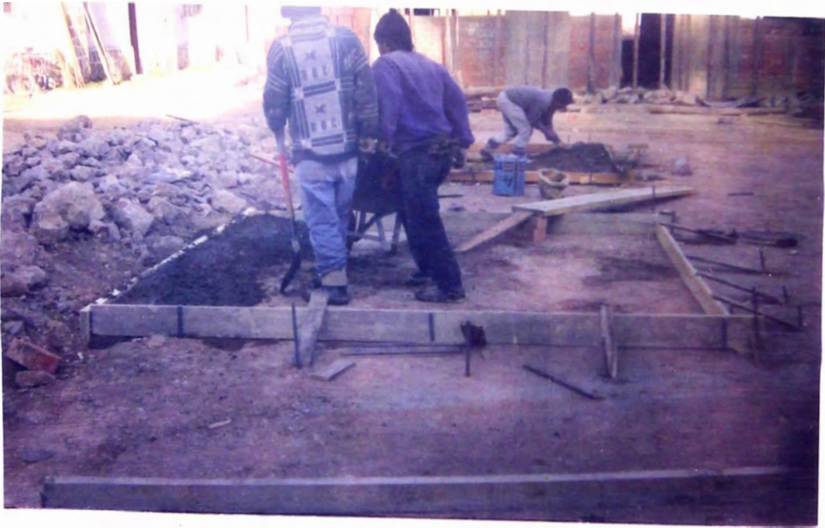
Foto N° 25: Aquí se aprecia el vaciado de concreto de uno de los paños de la losa deportiva.
