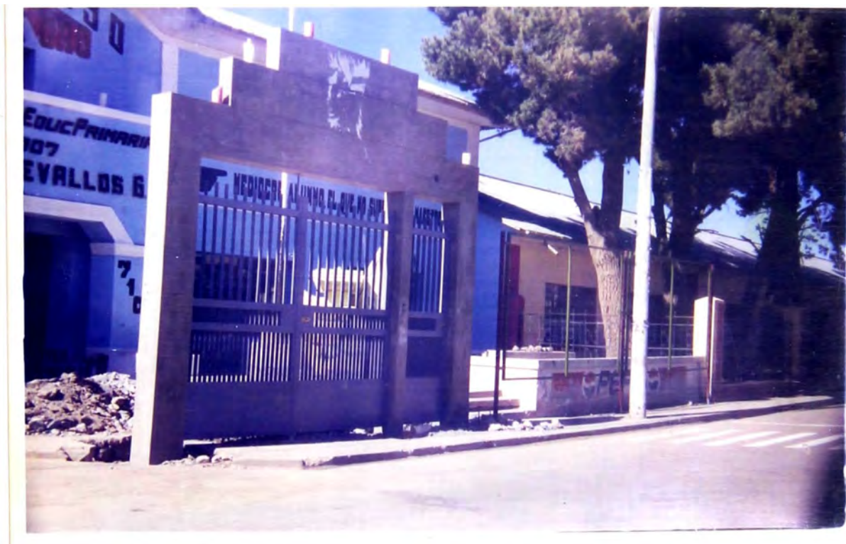
Foto N° 38: En esta toma se aprecia la portada de ingreso (tipo primario) ya tarajada y con sus respectivas puertas de ingreso, en esta parte de la obra recién se comenzaba a construir el cerco perimétrico (tipo malla).
