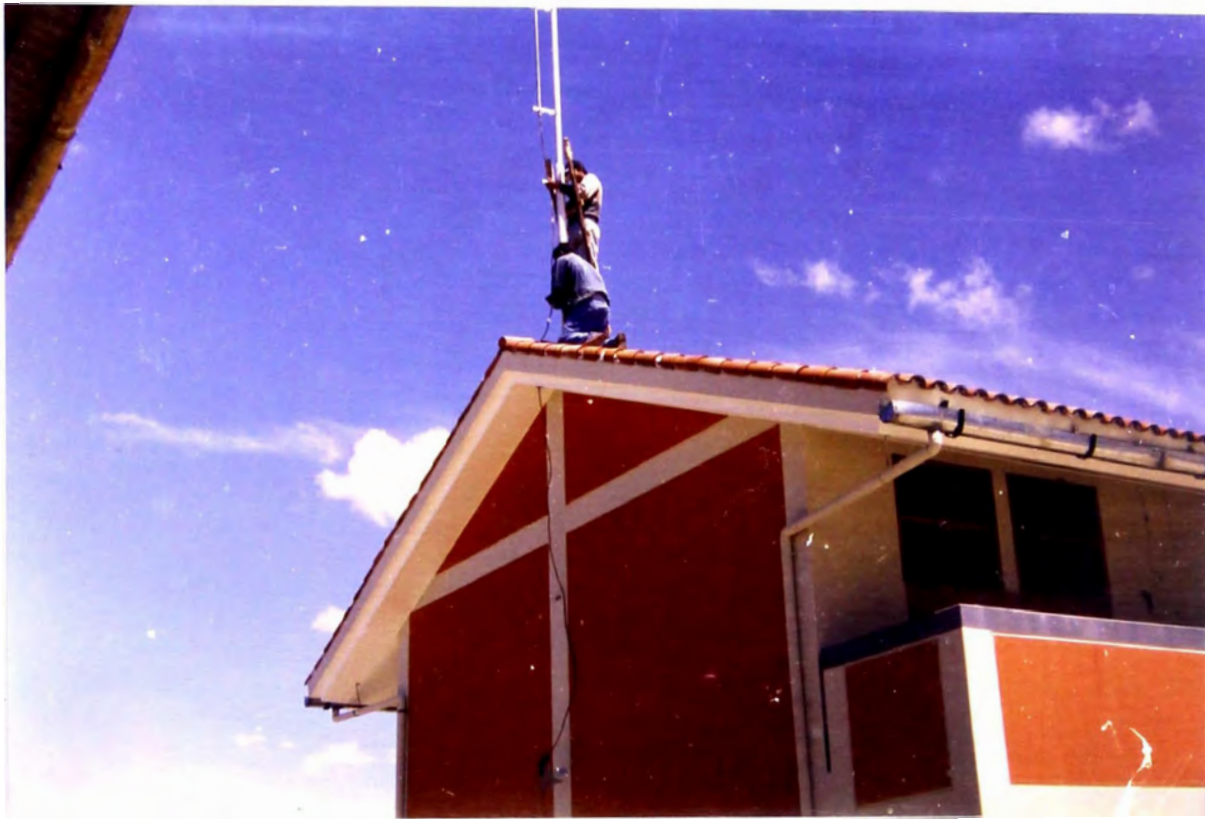
Foto N° 41: Acá se puede ver como los técnicos eléctricos están trabajando con la instalación del pararrayos que se encuentra ubicado en uno de los extremos del modulo de aulas
