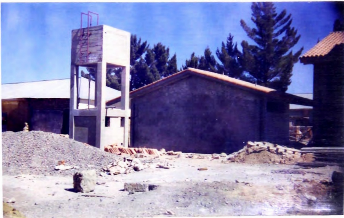
Foto N° 36: En esta toma se aprecia el modulo de SS.HH. esta completamente tarrajado y que al aunque Elevado le falta tarrajar la cara por donde se colocó la escalera gato.
