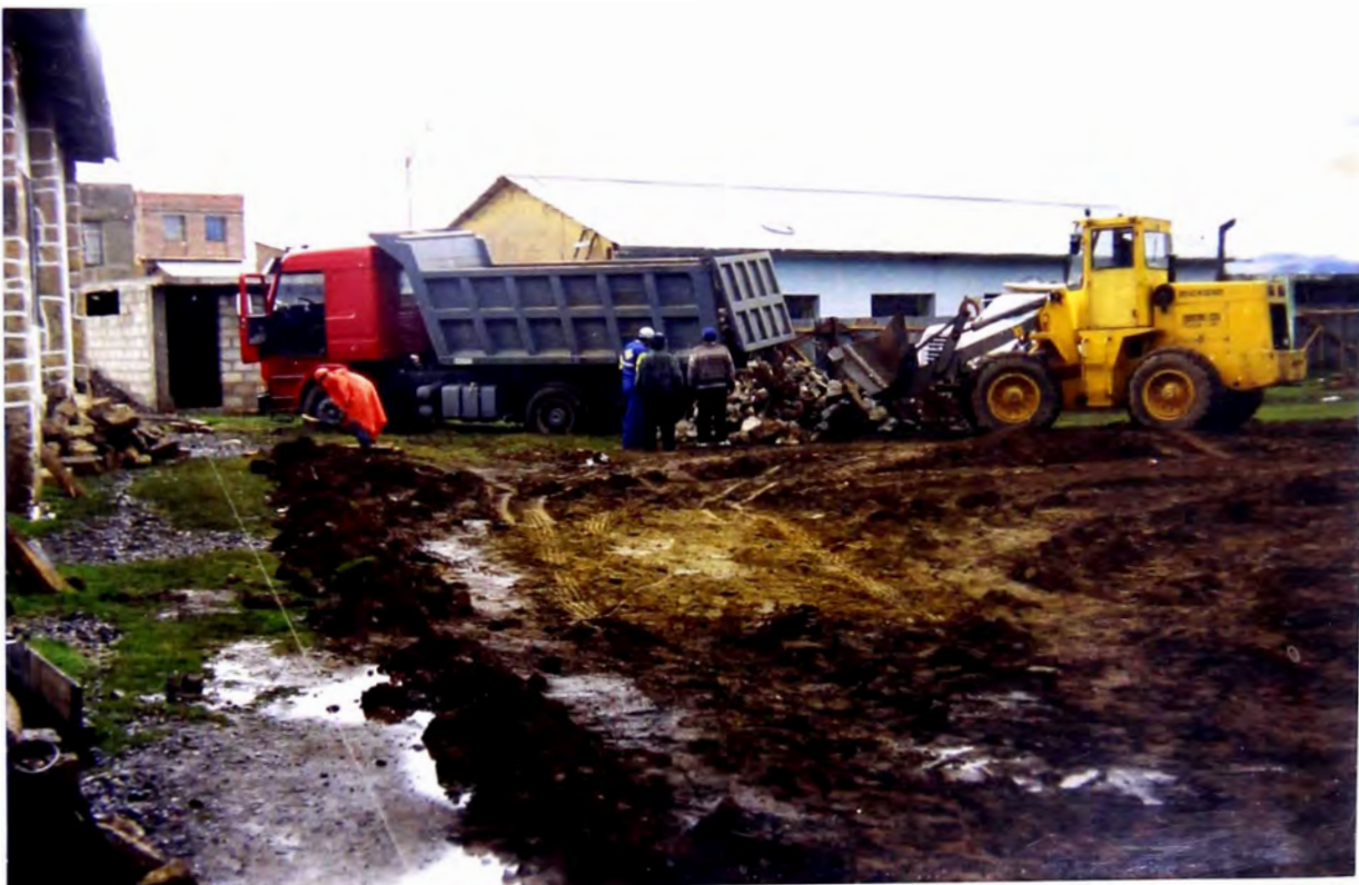
Foto N° 4: En esta imagen se puede apreciar la eliminación del desmonte producto de la demolición de las estructuras antiguas.
