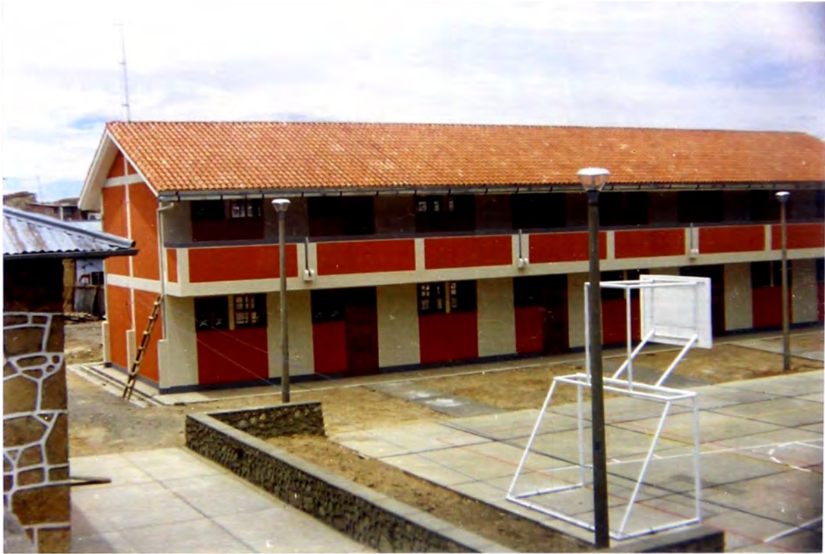
Foto N° 45: Vista del modulo de Aulas c completamente terminada.
