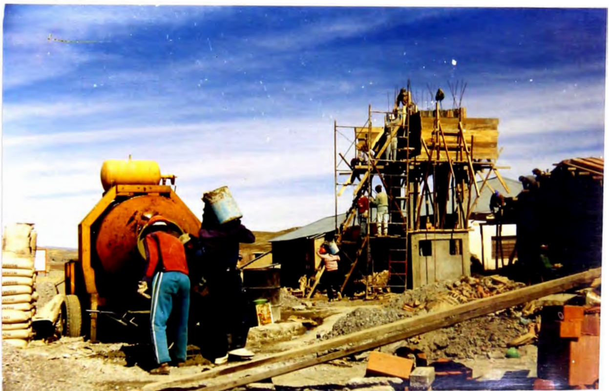
Foto N° 22: Aquí se encuentran vaciando con concreto el piso y las paredes del Tanque Elevado.
