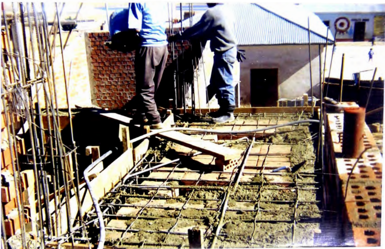
Foto N° 20: En esta imagen se aprecia que se esta vaciando con concreto la losa aligerada del segundo descanso de la escalera.
