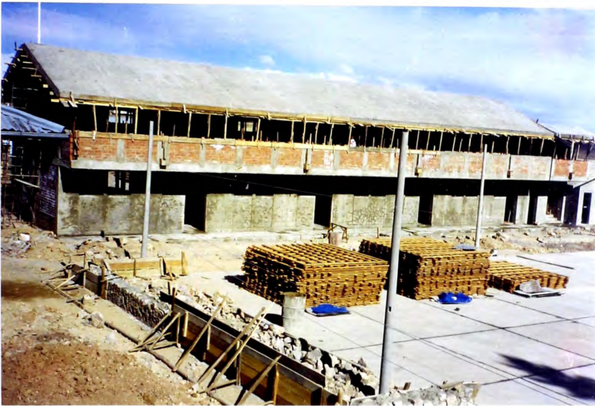
Foto N° 31: En esta vista se puede apreciar la losa aligerada del segundo nivel, el machihembrado secándose con el sol, la construcción de la pirca y los postes de luz ya colocados.
