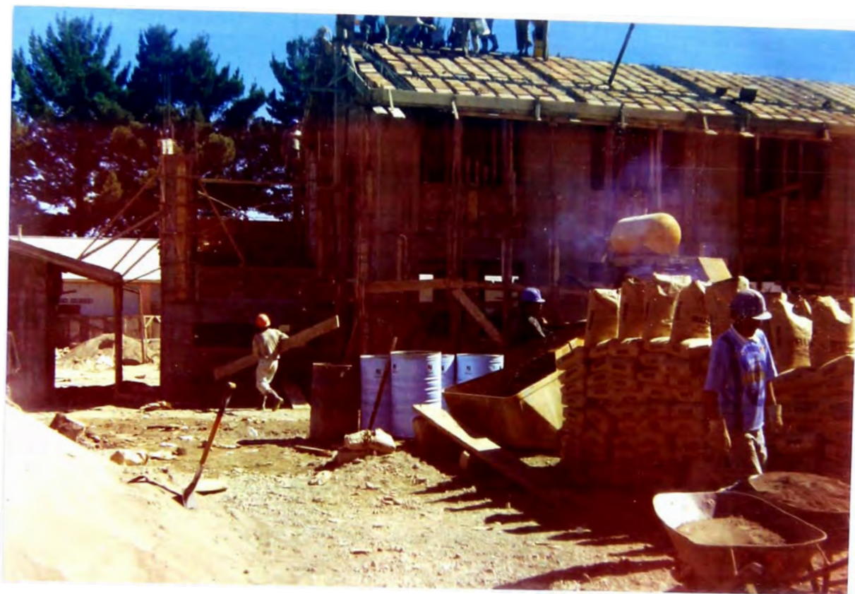
Foto N° 29: Aquí el personal se está alistando para empezar con el vaciado de la losa aligerada del segundo nivel del módulo de aulas.
