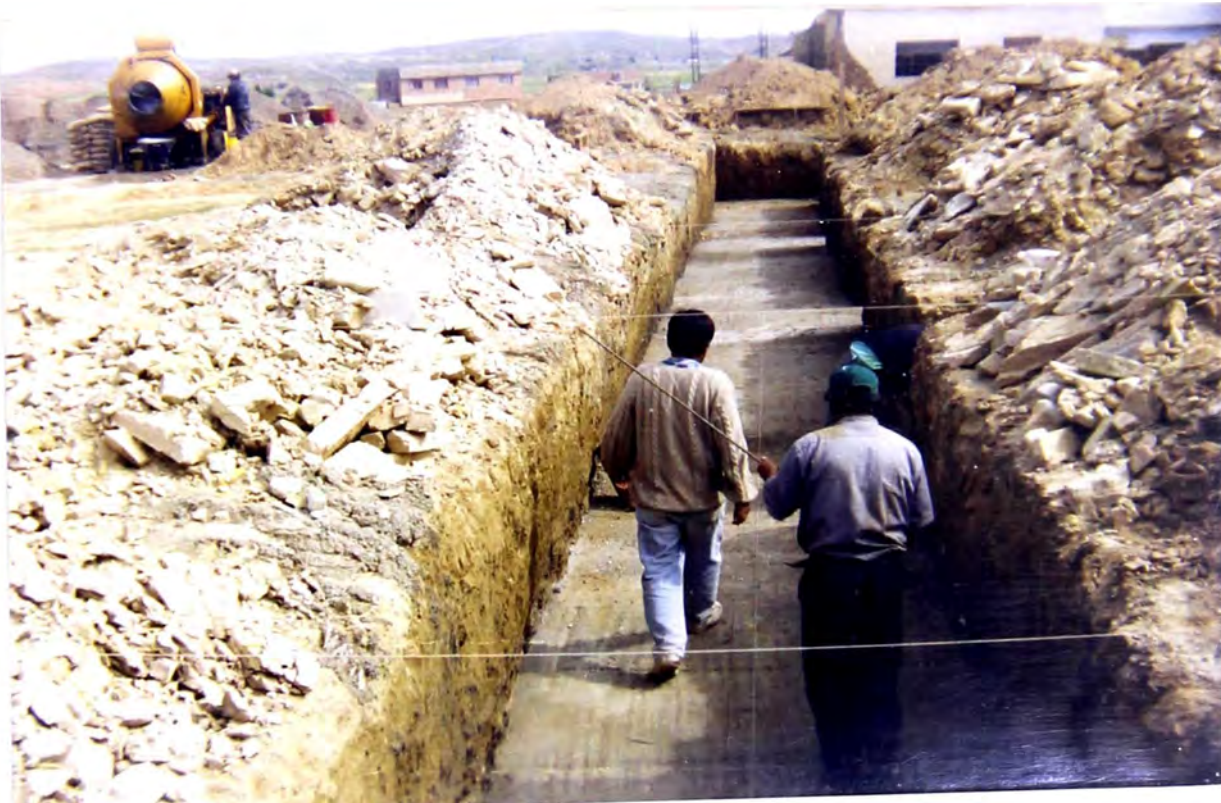
Foto N° 6: Aquí se puede apreciar que ya se encuentra vaciado todo el solado de la zapata y se va a proceder a ser los trazos de las columnas y placas.
