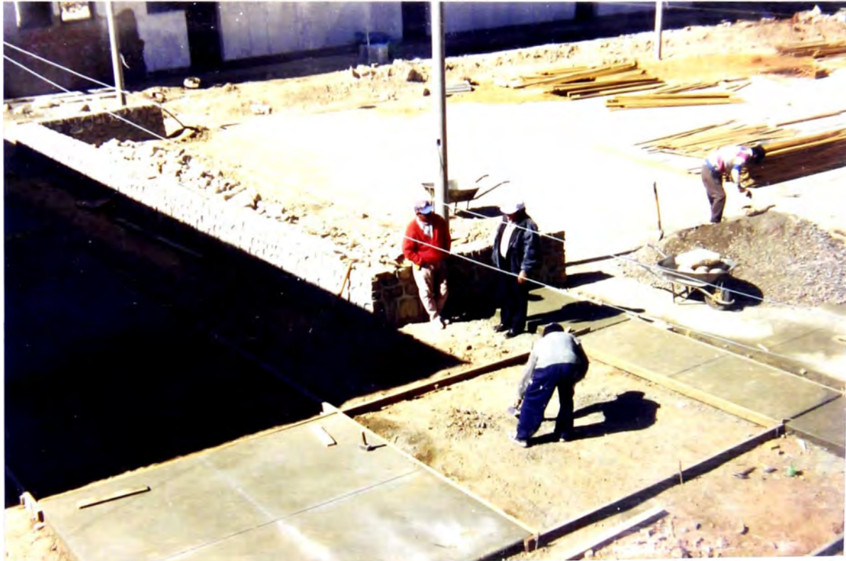
Foto N° 32: En esta toma se aprecia la pirca terminada y también que se está avanzando con la construcción de los paños del patio.
