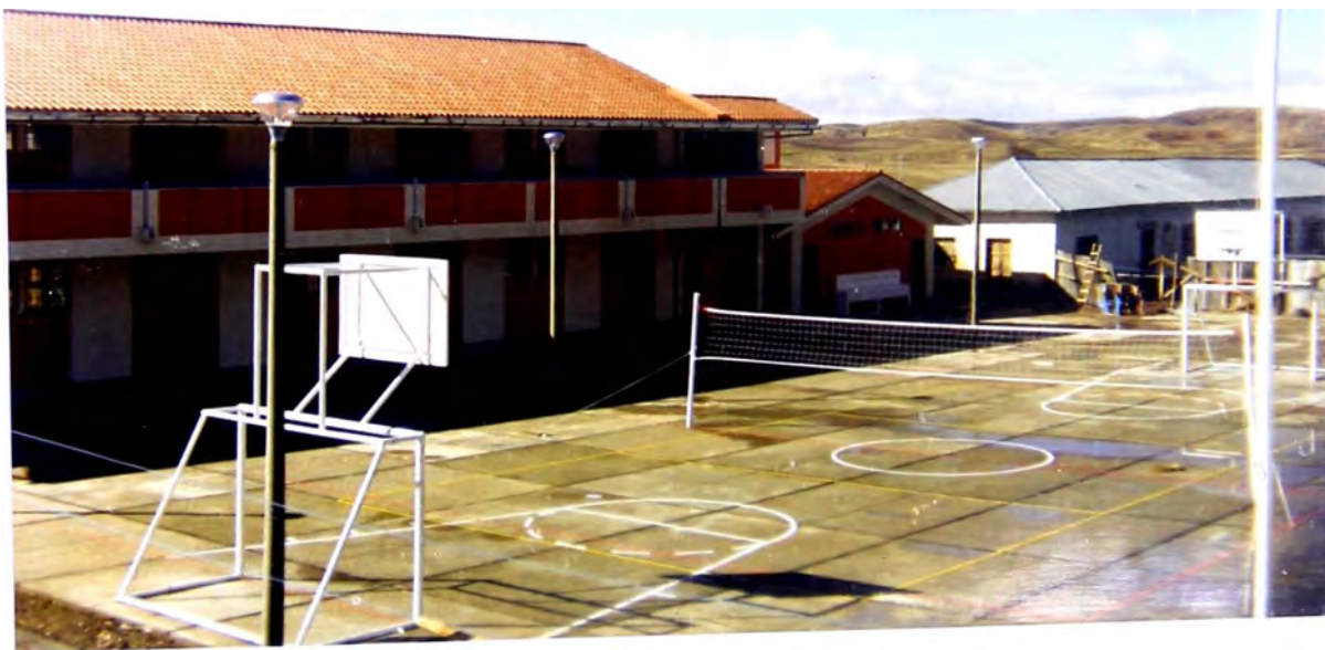
Foto N° 46: Vista de la Losa Deportiva completamente terminada, a su vez también se puede apreciar los módulos de Escalera y SS.HH. completamente terminados.
