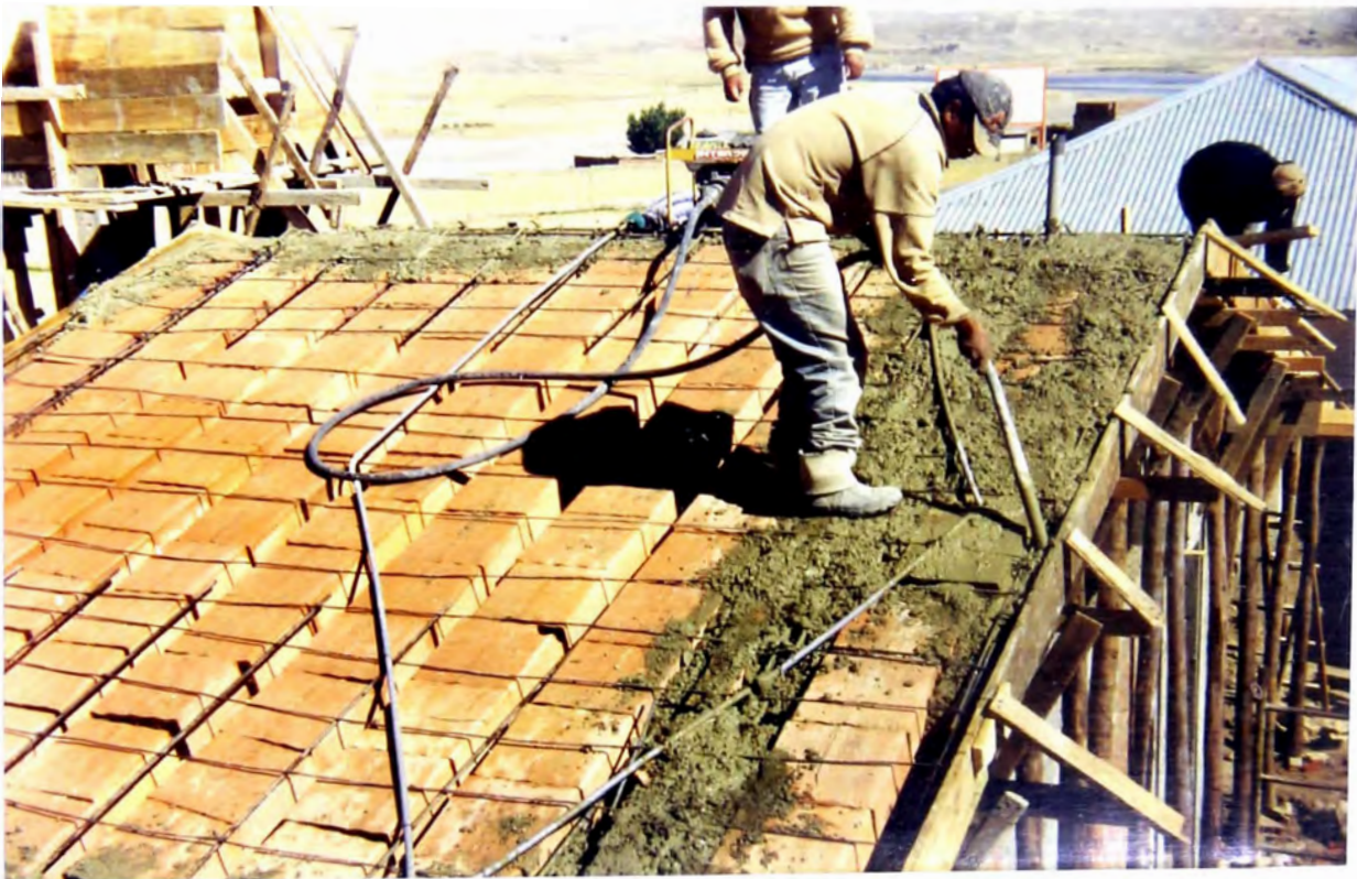
Foto N° 24: Aquí se encuentran vaciando con concreto la losa aligerada del modulo de SS.HH. y se puede apreciar el vibrado del concreto en la viga de la losa aligerada.
