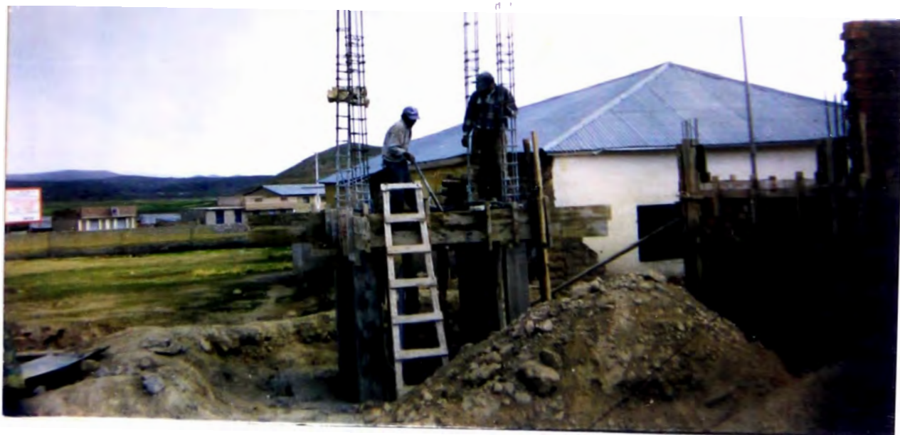
Foto N° 15: Aquí se encuentran vibrando la viga de la losa maciza de la caseta de bombeo.
