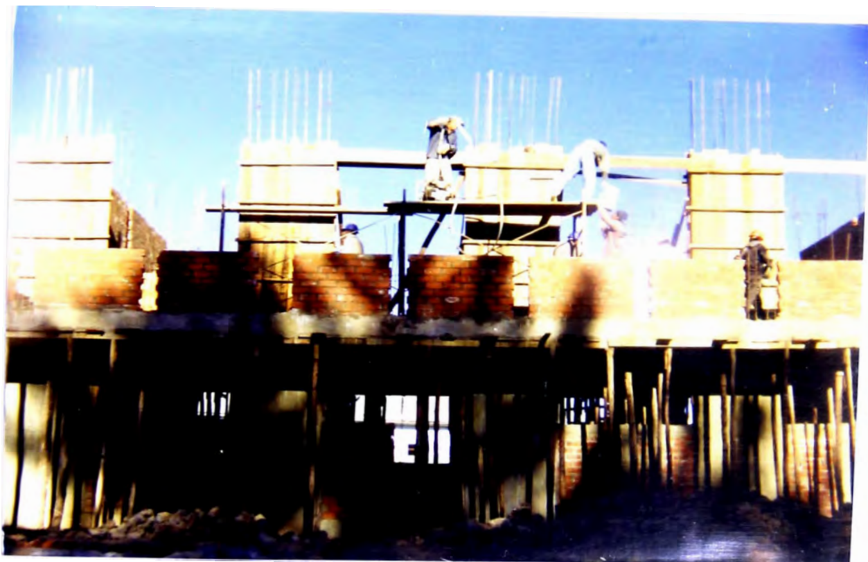
Foto N° 18: Se puede apreciar como están vaciando con concreto las placas del segundo nivel del modulo de aulas y también se puede apreciar como un trabajador se dedica exclusivamente con el vibrado de las placas.
