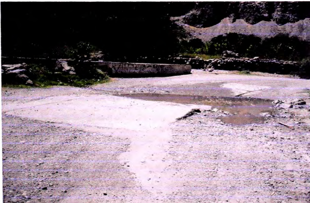
Figura N° 3.05: Badén existente en el Km 83+045
