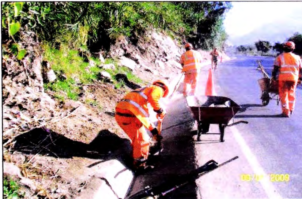
Figura N° 2.07: Limpieza de Cunetas Revestidas. Fuente: Reporte de Supervisión Julio 2009 – Consorcio de Gestión de Carreteras
