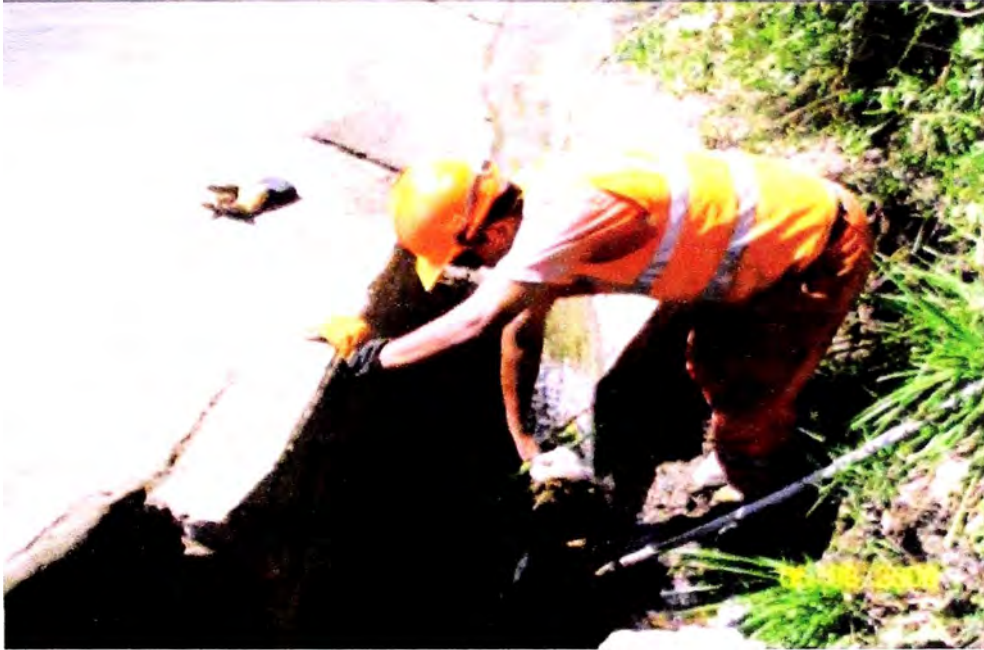
Figura N° 2.08: Limpieza de Cunetas Revestidas. Fuente: Reporte de Supervisión Agosto 2009 – Consorcio de Gestión de Carreteras
