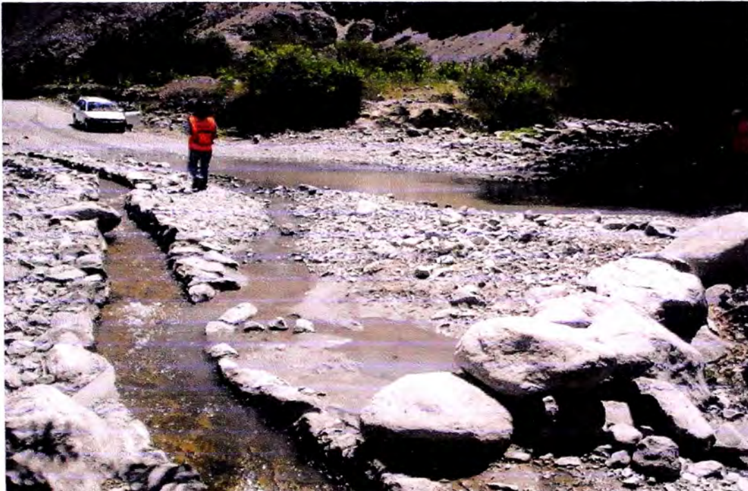
Figura N° 3.04: Badén existente en el Km 82+960
