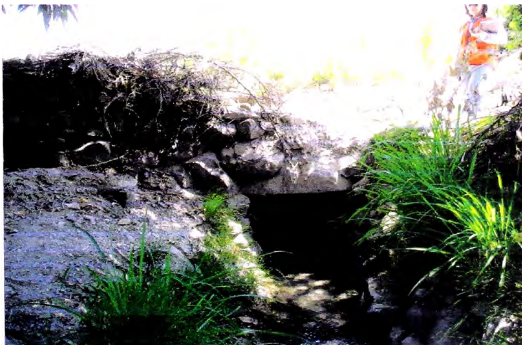
Figura N° 3.03: Salida de Alcantarilla Artesanal Mampostería de Piedra
