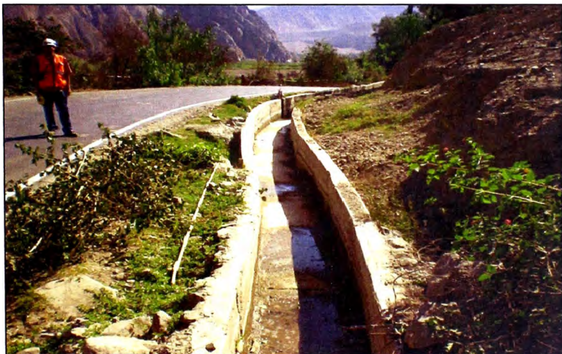
Foto N° 04. Km 63 + 900 Se observa canal de regadío de concreto adyacente a la vía.
