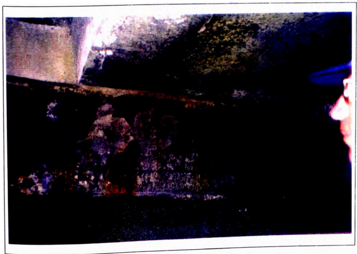
FOTOGRAFIA N° 38 PUNTOS DE CORROSION EN CARA INTERNA DE VIGA MANDIL DEL MUELLE 2
