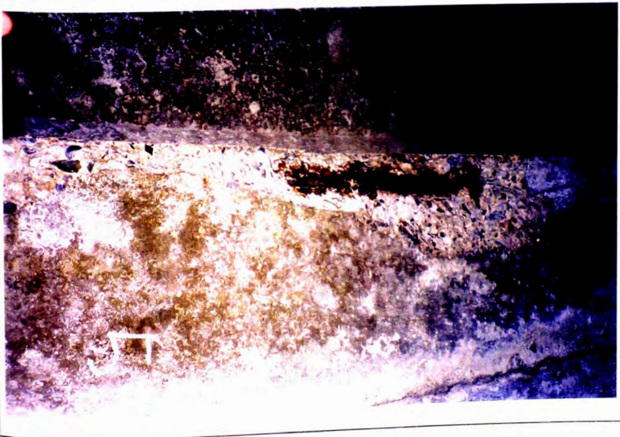
FOTOGRAFIA N° 18 DETALLE DEL ESTADO DE LAS ARMADURAS EN ARISTAS DE VIGAS LONGITUDINALES
