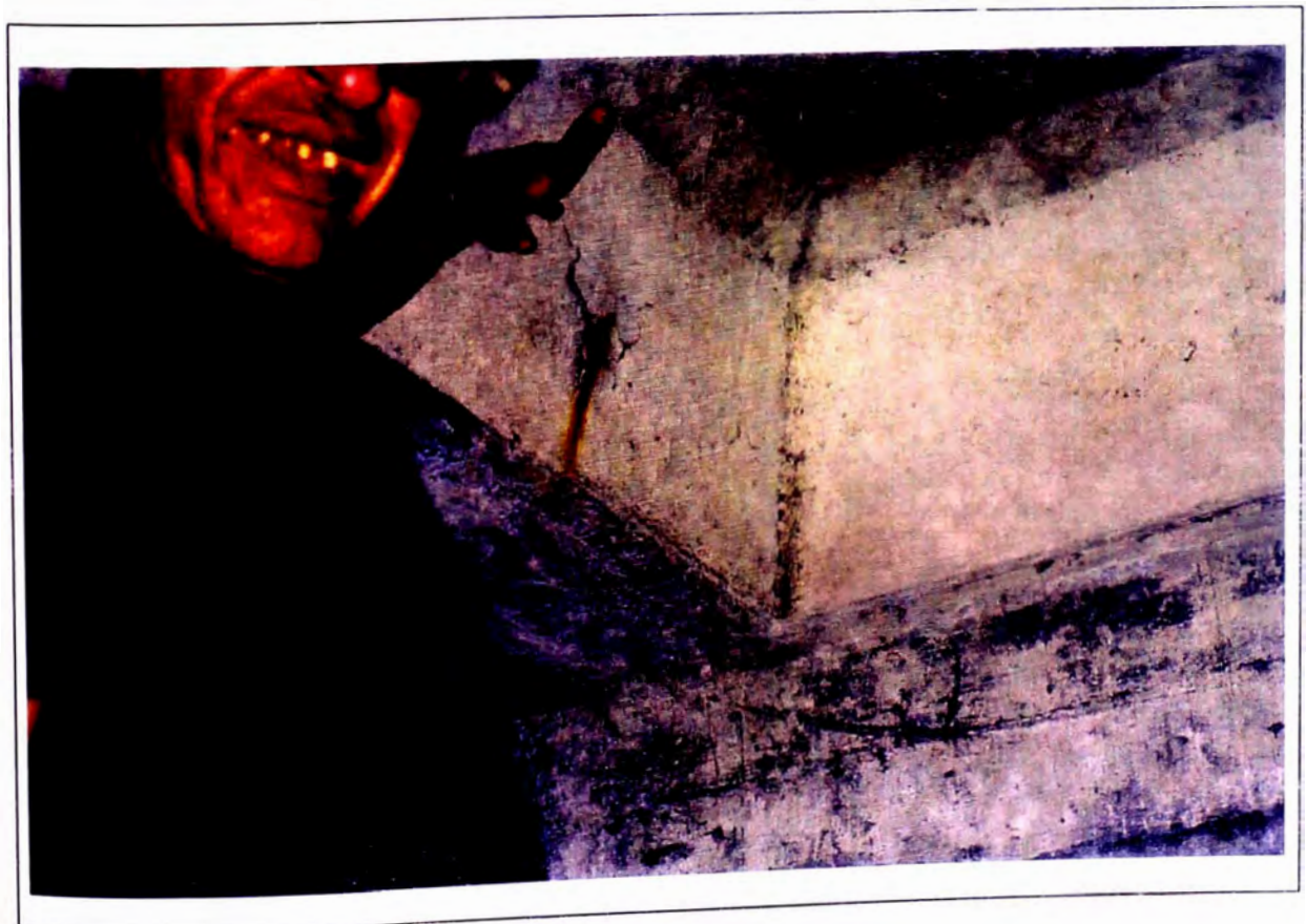
FOTOGRAFIA N° 28 PUNTO DE CORROSION EN VIGAS LONGITUDINALES, NOTESE FRACTURA EN EL CONCRETO
