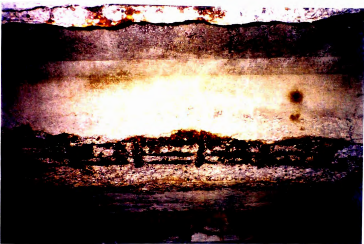
FOTOGRAFIA N° 26 DETALLE DEL ESTADO DE LAS ARMADURAS EN FONDOS DE VIGAS LONGITUDINALES
