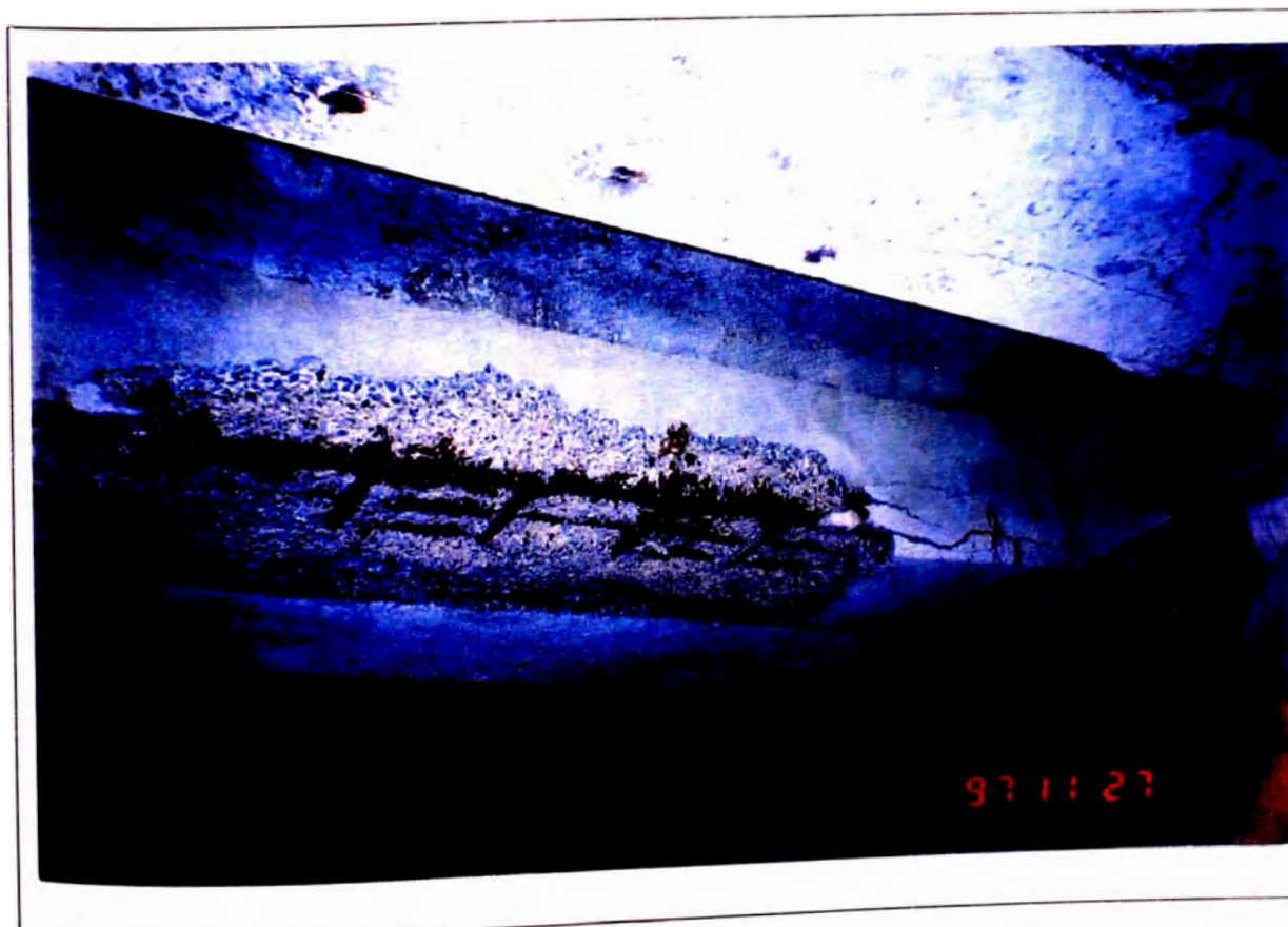
FOTOGRAFIA N° 20 DAÑO TIPICO EN FONDOS DE VIGAS LONGITUDINALES POR CORRISION INTERNA DE ARMADURAS
