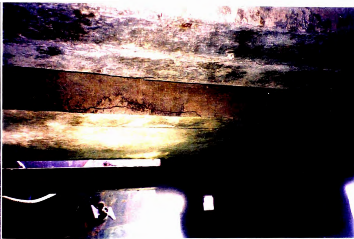
FOTOGRAFIA N° 12 CORRISION INTERNA EN ARMADURA DE VIGA LONGITUDINAL, FRACTURA DEL CONCRETO EN LA ARISTA EN PERIODO INTERMEDIO
