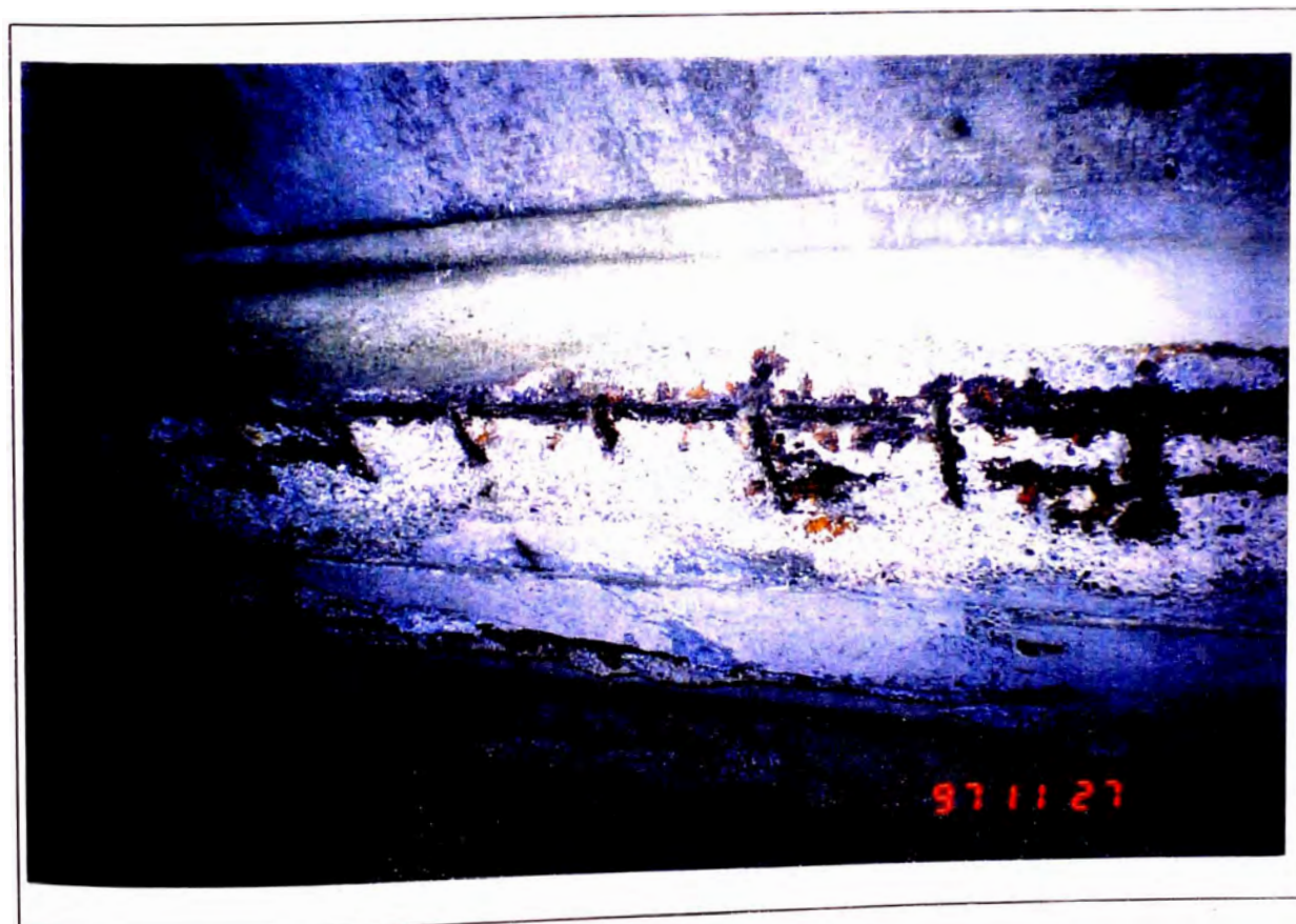
FOTOGRAFIA N° 22 DAÑO TIPICO EN FONDOS DE VIGAS LONGITUDINALES POR CORRISION INTERNA DE ARMADURAS
