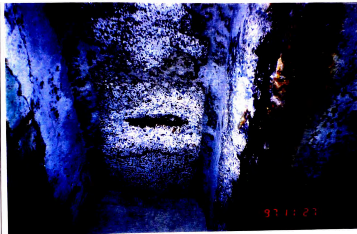
FOTOGRAFIA N° 34 PUNTO DE CORROSION EN FONDO DE LOSA EN PERIODO FINAL
