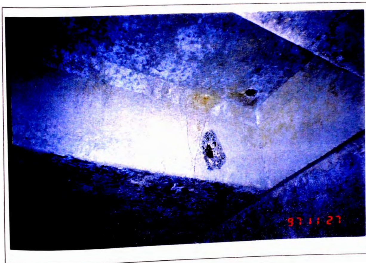
FOTOGRAFIA N° 32 PUNTO DE CORROSION EN VIGA LONGITUDINAL EN PERIODO FINAL, NOTESE PUNTO DE CORROSION EN FONDO DE LOSA
