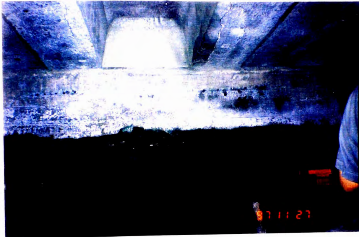
FOTOGRAFIA N° 06 DESPRENDIMIENTO DEL RECUBRIMIENTO DE CONCRETO POR CORROSION DE ARMADURAS EN VIGA TRANSVERSAL
