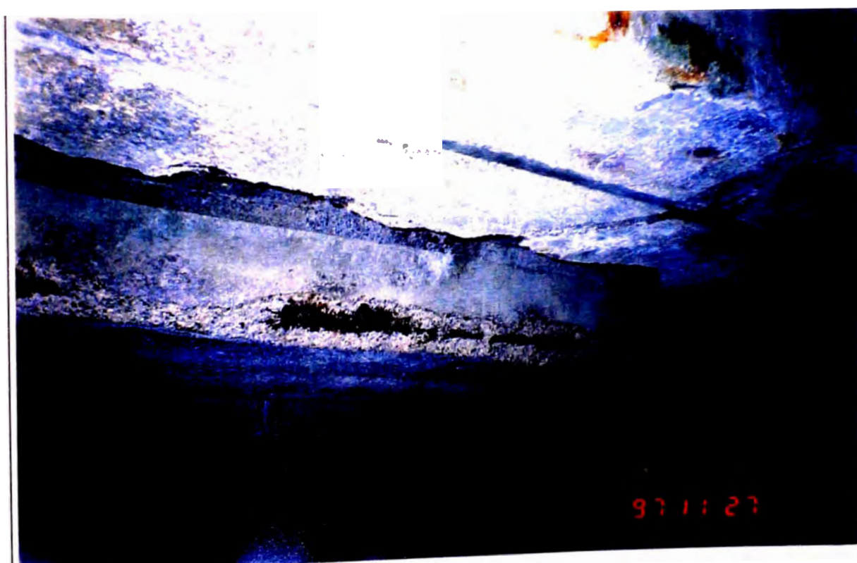
FOTOGRAFIA N° 16 DAÑO TIPICO EN ARISTAS DE VIGAS LONGITUDINALES POR CORRISION INTERNA DE ARMADURAS
