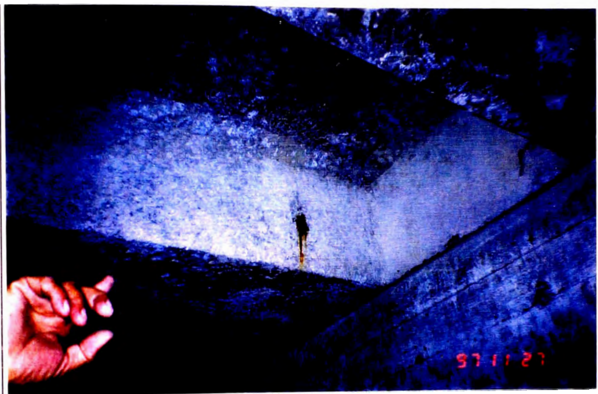
FOTOGRAFIA N° 32 PUNTO DE CORROSION EN VIGA LONGITUDINAL EN PERIODO FINAL, NOTESE PUNTO DE CORROSION EN FONDO DE LOSA
