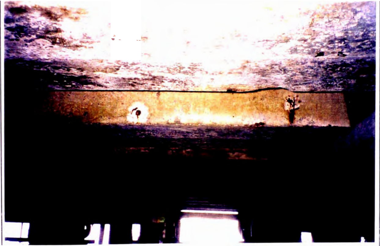
FOTOGRAFIA N° 28 PUNTO DE CORROSION EN VIGAS LONGITUDINALES, NOTESE FRACTURA EN EL CONCRETO
