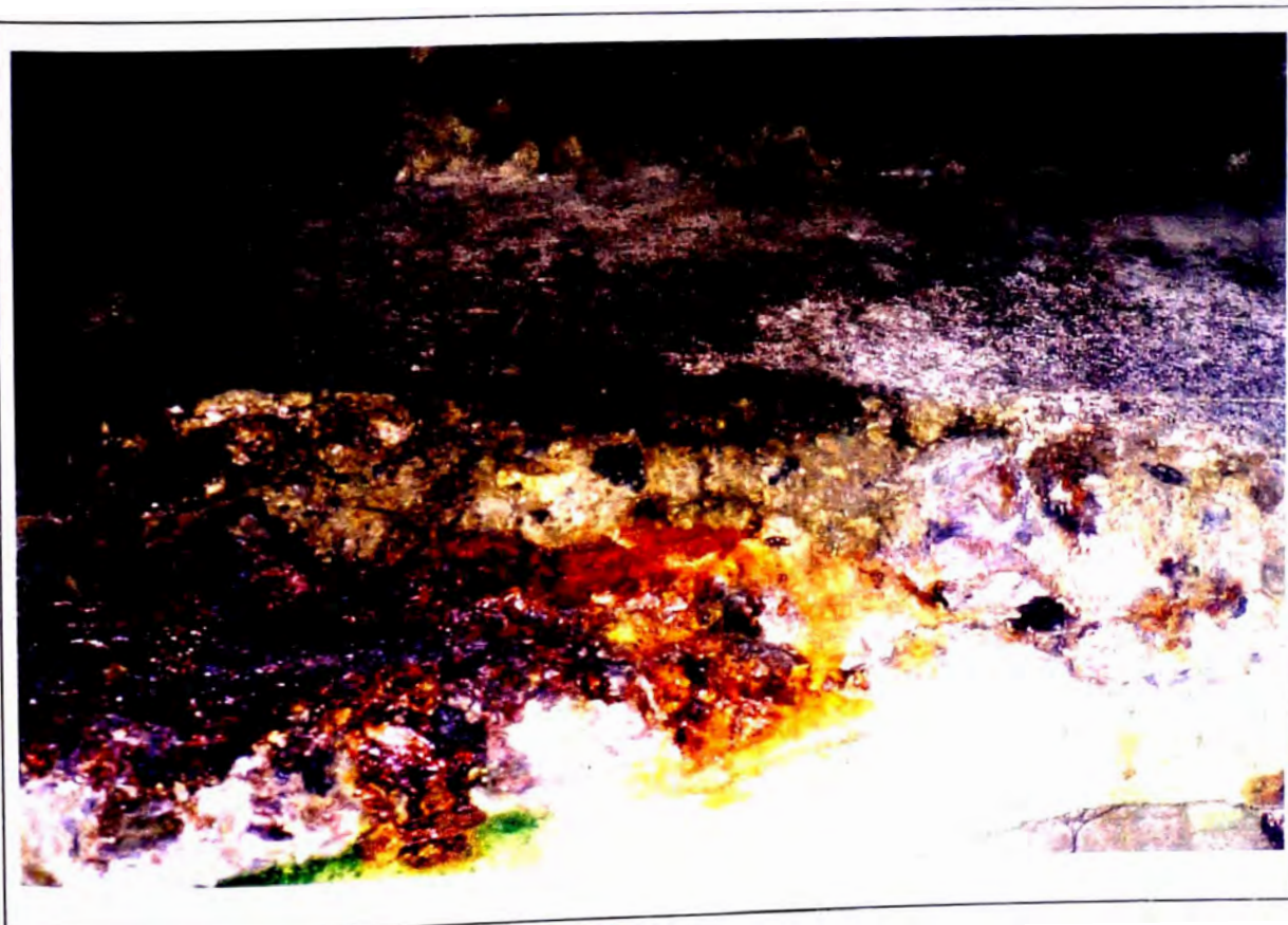
FOTOGRAFIA N° 26 DETALLE DEL ESTADO DE LAS ARMADURAS EN FONDOS DE VIGAS LONGITUDINALES
