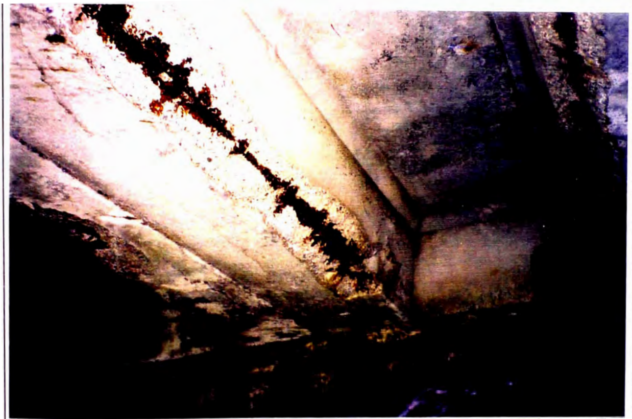
FOTOGRAFIA N° 14 DAÑO TIPICO EN ARISTAS DE VIGAS LONGITUDINALES POR CORRISION INTERNA DE ARMADURAS
