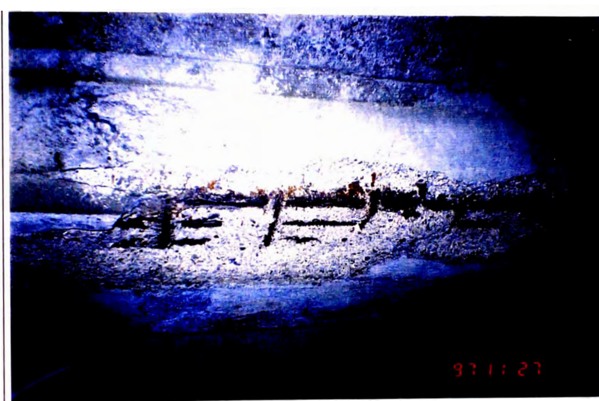
FOTOGRAFIA N° 22 DAÑO TIPICO EN FONDOS DE VIGAS LONGITUDINALES POR CORRISION INTERNA DE ARMADURAS
