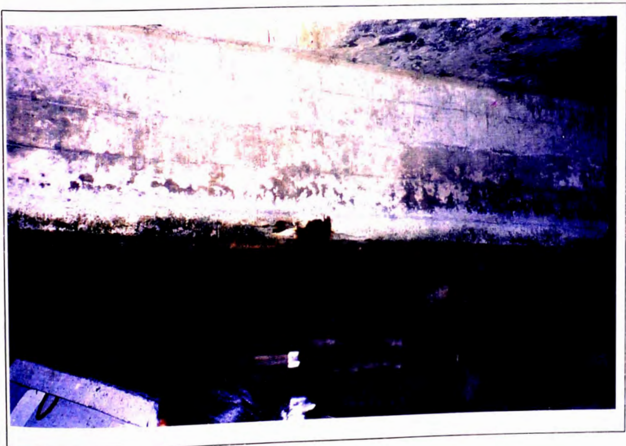
FOTOGRAFIA N° 04 PUNTO DE CORROSION Y FRACTURA DEL RECUBRIMIENTO DE CONCRETO EN VIGA TRANSVERSAL
