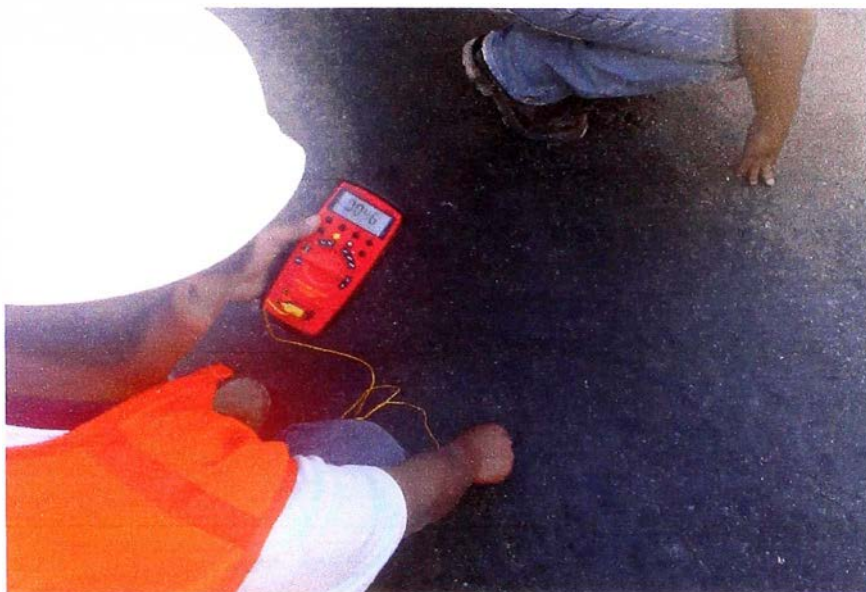
Figura 4.3 Vista de la toma de temperatura del asfalto
