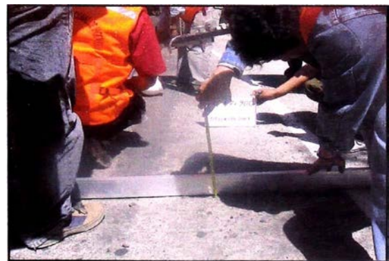
Figura 6.6 Medida de ahuellamiento
