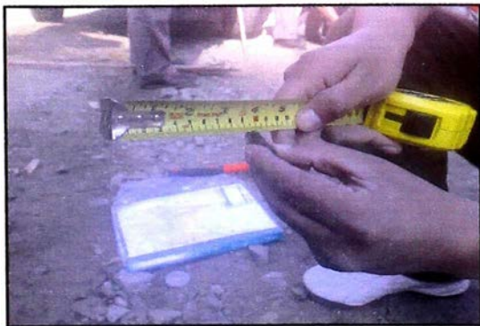
Figura 6.5 Medición espesor de la carpeta asfáltica
