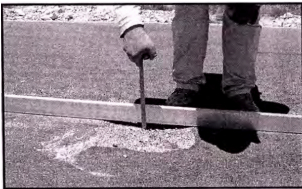
Foto 09: Se observa una falla tipo Hueco de severidad Alta. Foto 10: Se observa falla tipo Bache de severidad Media, producto de un hueco parchado entre los. (km 70+000 – km. 71+000)
