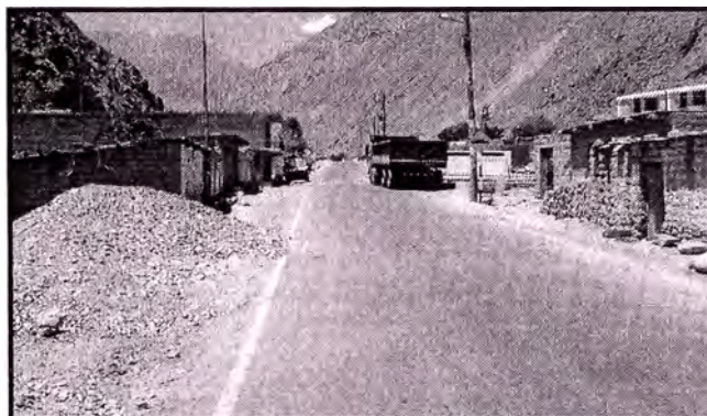
Foto 19 y 20: Se observa el cruce de la carretera a través del poblado de San Jerónimo, en este tramo la misma ha sufrido la acción de la actividad humana, como se observa, se utiliza parte de la vía para almacenar materiales de construcción y estacionar volquetes. (km. 72+000 – km. 73+000)
