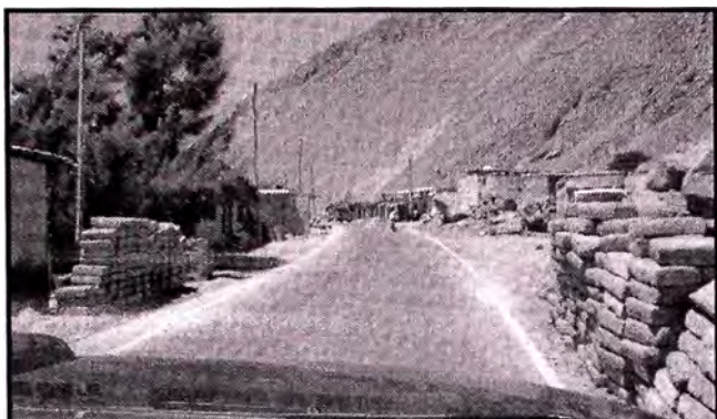
Foto 19 y 20: Se observa el cruce de la carretera a través del poblado de San Jerónimo, en este tramo la misma ha sufrido la acción de la actividad humana, como se observa, se utiliza parte de la vía para almacenar materiales de construcción y estacionar volquetes. (km. 72+000 – km. 73+000)
