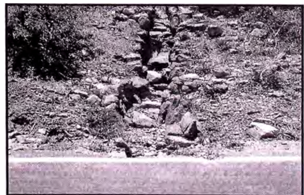
Foto 17: Se observa el hito de inicio de la progresiva del km. 72+000. Foto 18: Se observa el cruce a través de la vía de una alcantarilla artesanal de piedra, esto con el tiempo puede ocasionar fallas estructurales en esa parte de la vía. (km 72+000 – km. 73+000)
