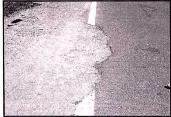
Foto 13: Se observa una falla tipo Bache de severidad Baja, Foto 14: Se observa una falla tipo Grieta de Borde de severidad Alta. Se ve el desprendimiento total de la capa superficial. (km 71+000 – km. 72+000)
