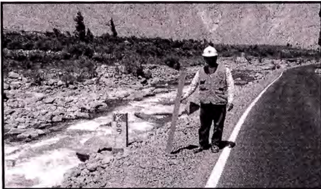
Foto 01: Se muestra el hito de inicio del tramo en estudio en el km 69+000. Foto 02: Falla tipo Grieta de Borde, con severidad Media y Alta, en la figura se observa la identificación y el metrado de la falla. (km 69+000 – km. 70+000)
