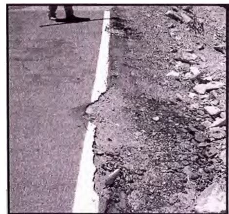
Foto 11: Se observa una vista lateral de la erosión del Rio Cañete al talud inferior de la carretera. Esta erosión poco a poco socaba la base de la estructura generando hundimientos en la superficie. Foto 12: Fallas tipo Grietas de Borde con severidad Alta. (km 70+000 – km. 71+000)
