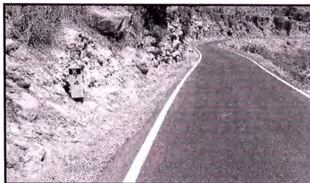
Foto 23: Se observa un sector de la vía la cual caracteriza a los km 71+000 al km 74+000. con escasas fallas en la superficie. Esto debido al poco tiempo de aplicado el mejoramiento superficial tipo Slurry Seal. Foto 24: Se observa el hito final del tramo, km. 74+000.
