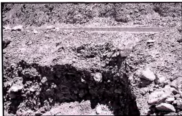
Foto 11: Se observa una vista lateral de la erosión del Rio Cañete al talud inferior de la carretera. Esta erosión poco a poco socaba la base de la estructura generando hundimientos en la superficie. Foto 12: Fallas tipo Grietas de Borde con severidad Alta. (km 70+000 – km. 71+000)
