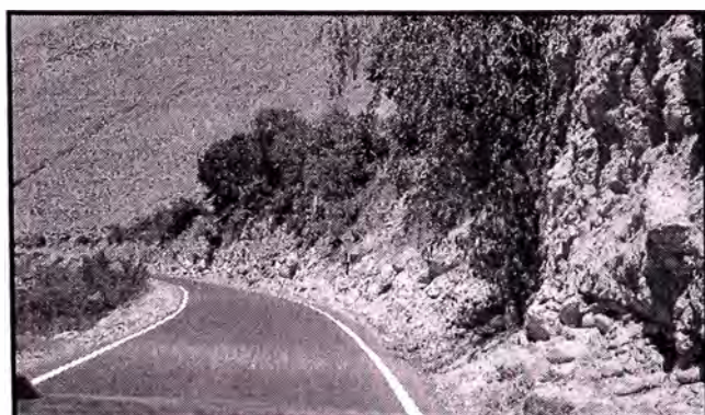
Foto 23: Se observa un sector de la vía la cual caracteriza a los km 71+000 al km 74+000. con escasas fallas en la superficie. Esto debido al poco tiempo de aplicado el mejoramiento superficial tipo Slurry Seal. Foto 24: Se observa el hito final del tramo, km. 74+000.
