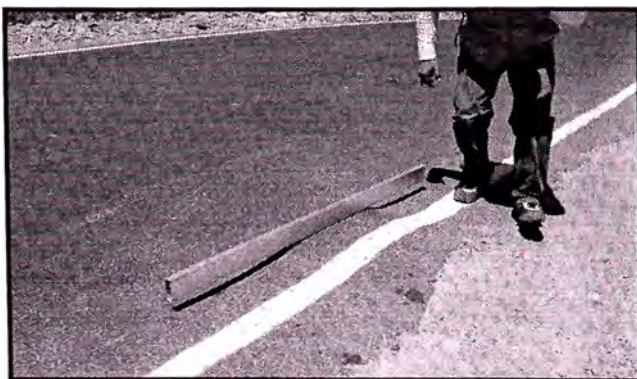
Figura 05: Se observa una falla tipo Hinchamiento de severidad Alta. Figura 06: Se observan varias fallas consecutivas tipo Huevo de severidad Baja. (km 69+000 – km. 70+000)
