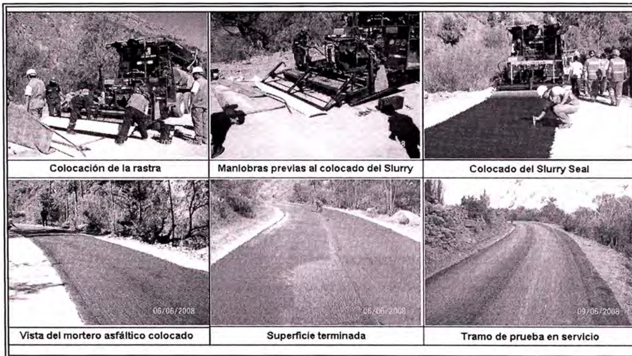
Figura N° 1.7 Aplicación del Slurry Seal
