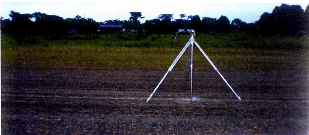
FOTOGRAFIA N°7. Fotografía del área donde se proyectó la futura calle de acceso y plataforma de estacionamiento de aeronaves, se aprecia el trazo del eje, perpendicular al eje de pista en la progresiva 0+940.
