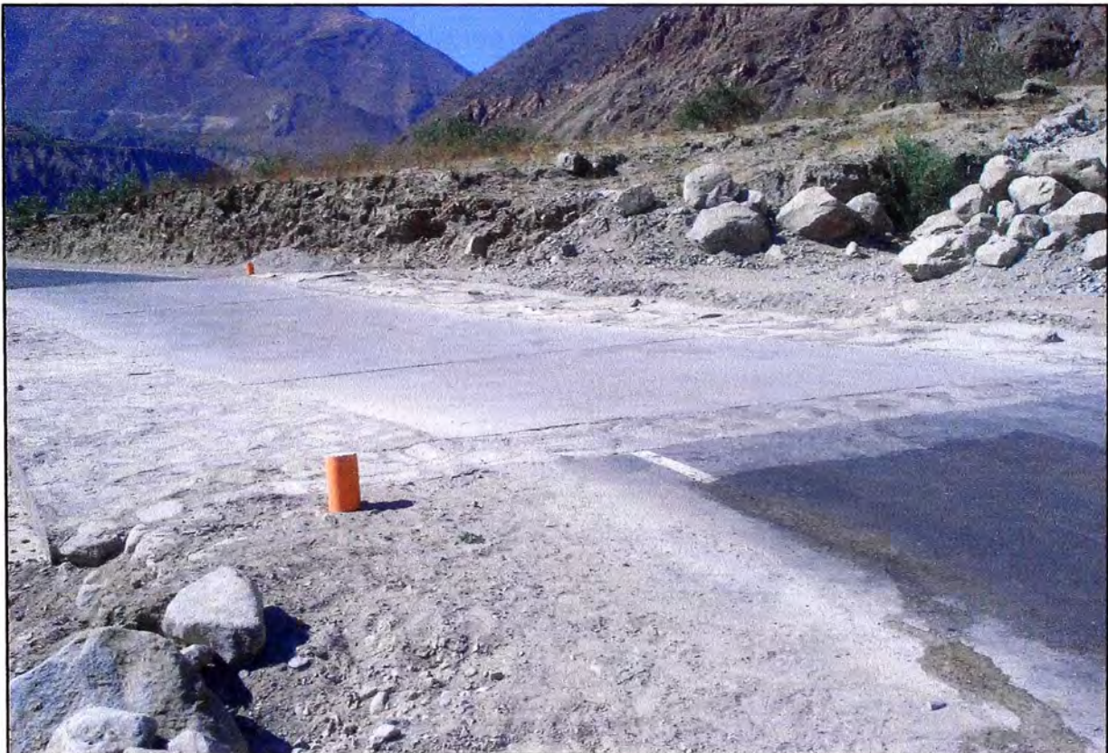
FIGURA N° 4.07: Badén de Concreto Km. 103+900
