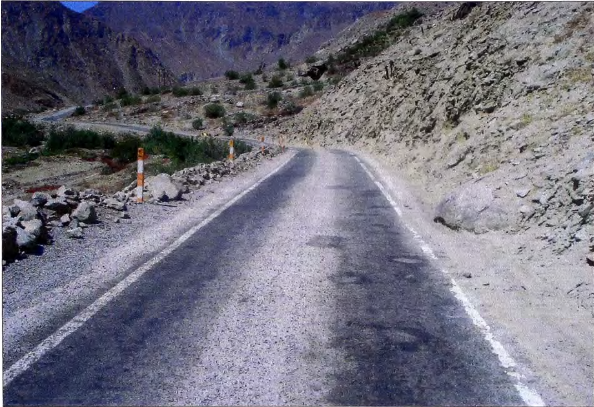
Fotografía N° 05, Vista Panorámica, Km. 99+600 Tratamiento Superficial Monocapa
