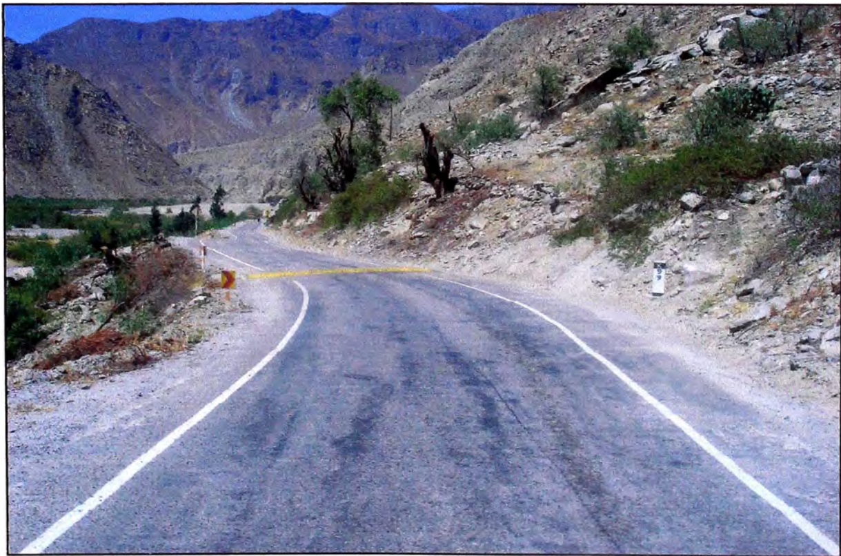
FIGURA N° 4.03: Tratamiento Superficial Monocapa Km. 99+000
