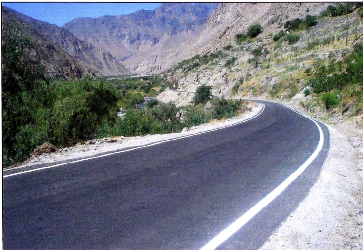
Fotografía N° 07, Vista Panorámica Tramo Curvo Km. 101+000, Tratamiento Superficial Slurry Seal,
