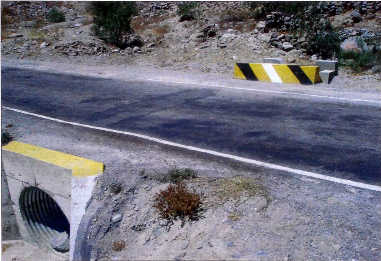
Fotografía N° 03, Presencia de Alcantarillas TMC 24" Km. 99+070, los cuales se observan a lo largo del Tramo evaluado
