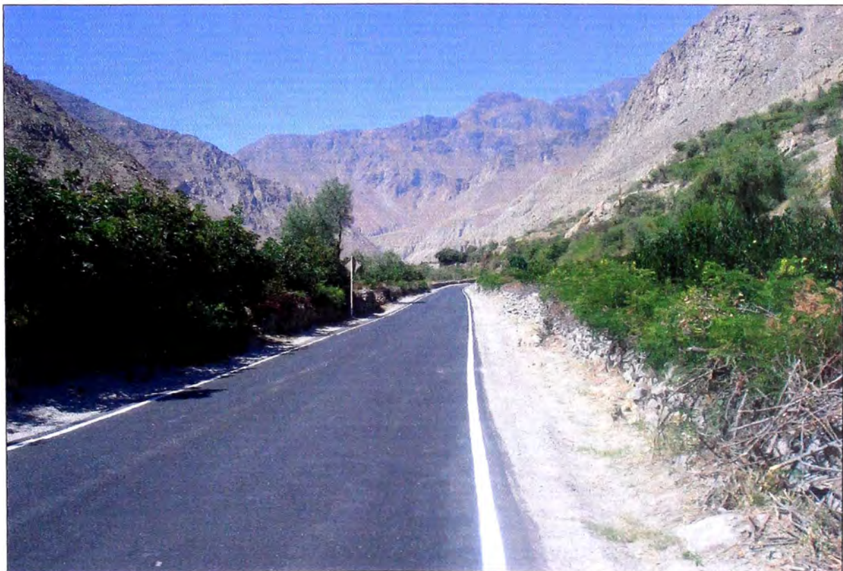
Fotografía N° 06, Vista Panorámica, Km. 100+500 Tratamiento Superficial Slurry Seal
