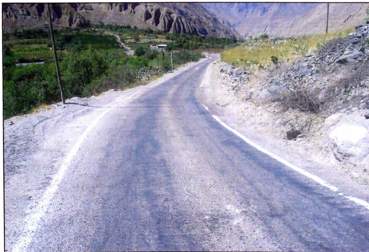
Fotografía N° 08, Vista Panorámica Tramo Curvo Km. 102+000, Tratamiento Superficial Monocapa,
