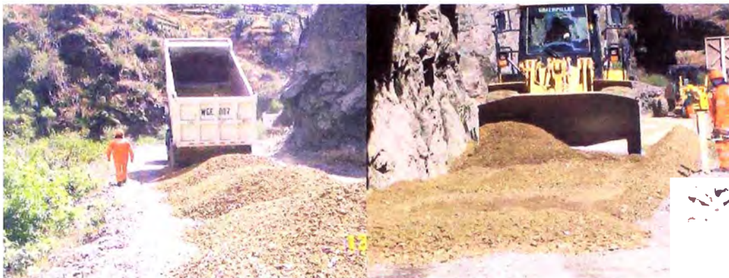
Colocación de capa granular con material de cantera
