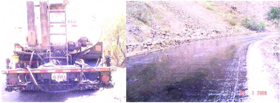
Riego de RC-250 sobre la superficie estabilizada
