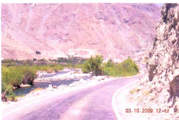
Vistas del km. 93+000 hacia el km. 92+000
