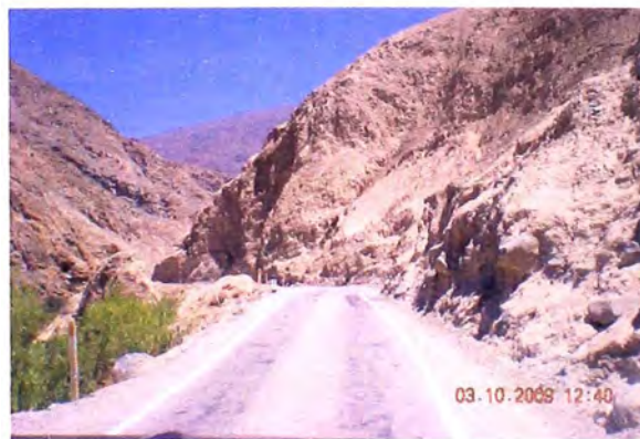
Vistas del km. 91+000 hacia el km. 90+000
