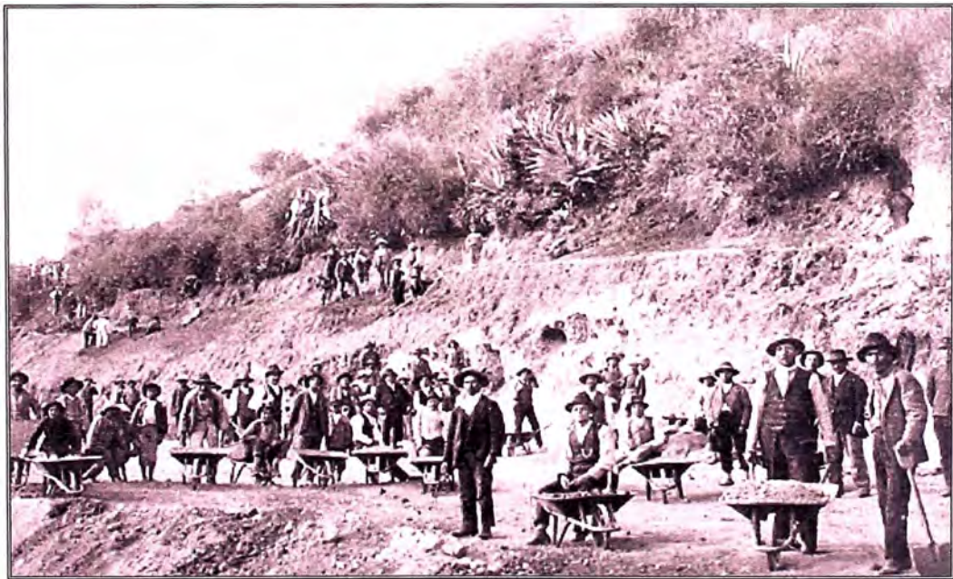
Figura N°1.1 Trabajos durante la Ley de Conscripción Vial
