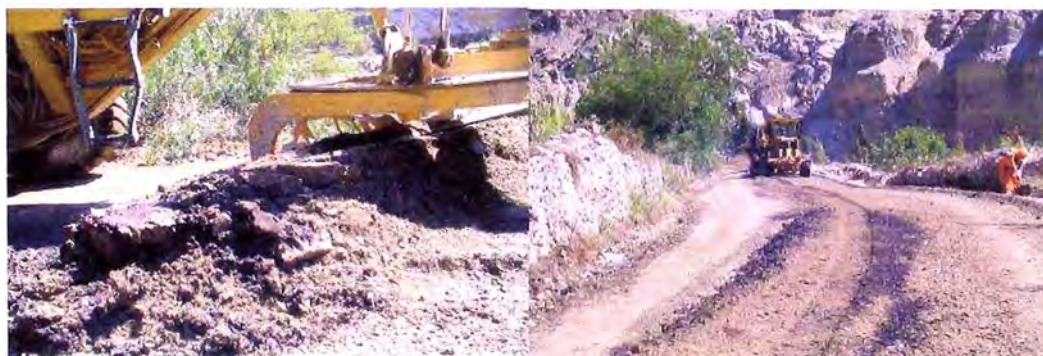
Estabilización de afirmado Km. 94+000
