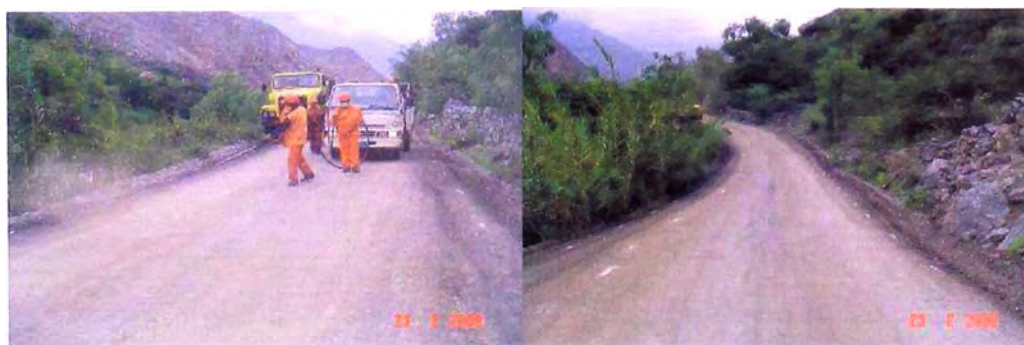
Limpieza de superficie estabilizada Km. 90+000
