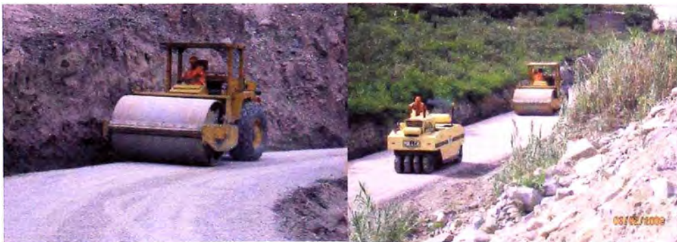
Trabajos de Compactado
