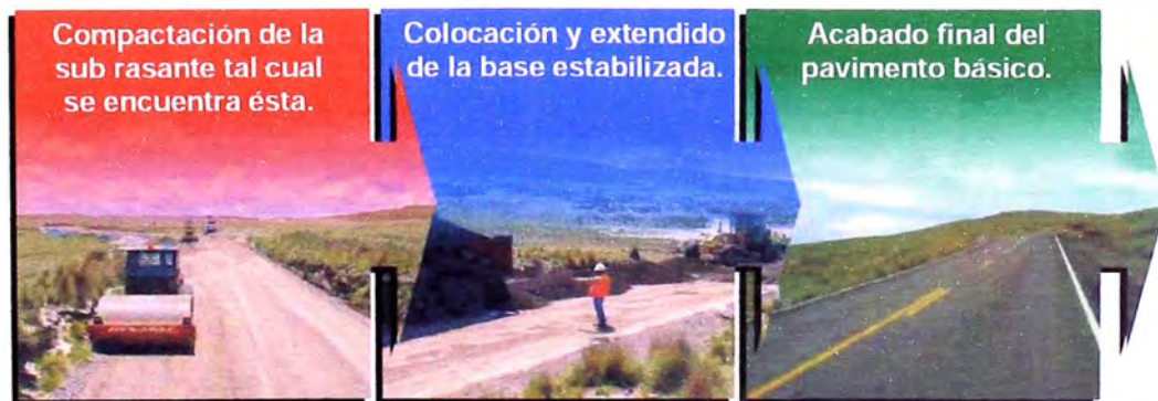
Figura N°1.9 Proceso de ejecución de pavimentos básicos
