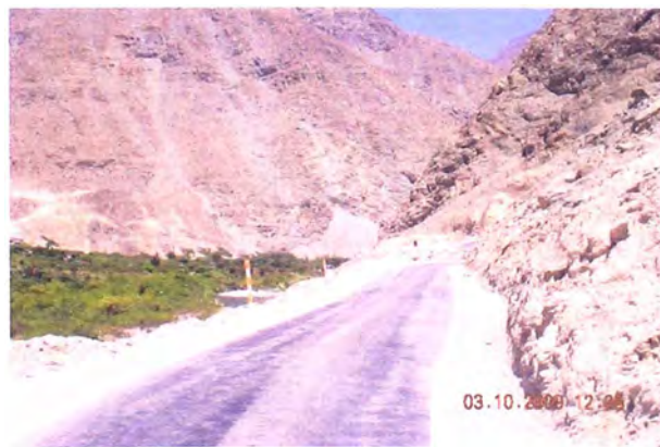
Vistas del km. 92+000 hacia el km. 91+000
