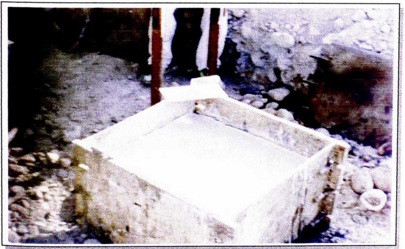
Foto N° 4 : Vista mostrando el empaste de mortero (yeso-cemento) para que la transmisión de la carga sea uniforme en toda el área
