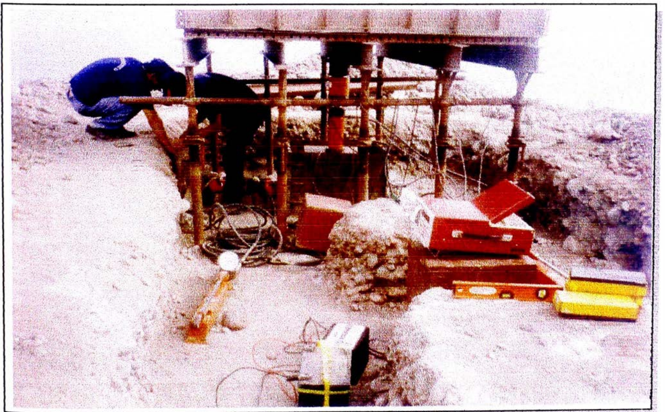
Foto N° 8 · Vista mostrando la instalación del equipo antes de realizar el ensayo
