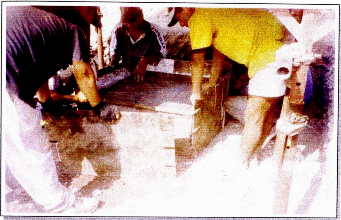
Foto N° 3 Vista mostrando la colocación de la caja metálica de confinamiento a uno de los dados (especimen)
