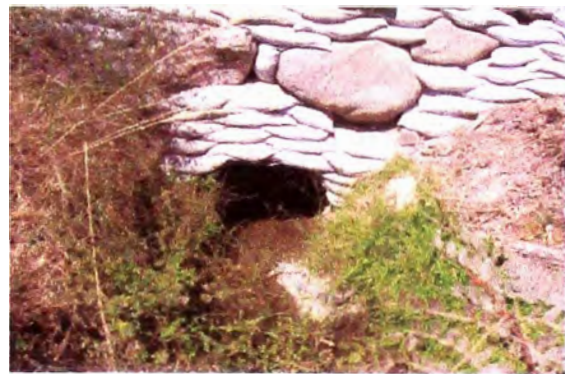
Foto 15: Se observa la construcción provisional de un muro de contención con sacos de arena, los cuales colapsaran debido al intemperismo predominante en la zona Km 92+500. Foto 16: Se observa la ausencia de alcantarilla en cruce de canal.
