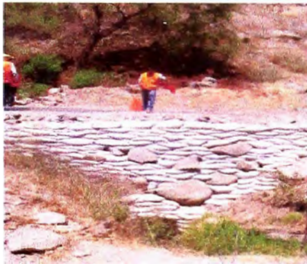
Foto 15: Se observa la construcción provisional de un muro de contención con sacos de arena, los cuales colapsaran debido al intemperismo predominante en la zona Km 92+500. Foto 16: Se observa la ausencia de alcantarilla en cruce de canal.
