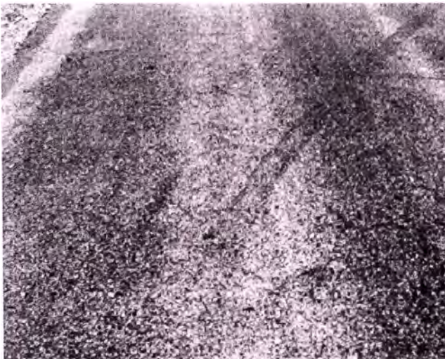
Foto. N°6 Exudación severidad Alta
