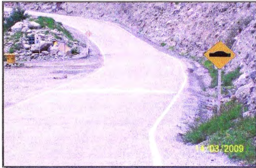
Fotografía 1.07.- Trabajo terminado a la fecha de marzo del 2009
