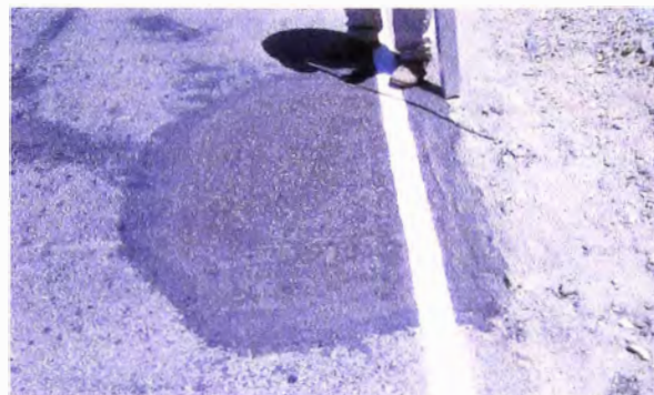
Foto 07: Se muestra el hito de inicio del km 93+000. Foto 08: Falla tipo Bacheo de severidad Baja, por estar este parche en buenas condiciones de transitabilidad. (km 92+700 – Km 92+900)
