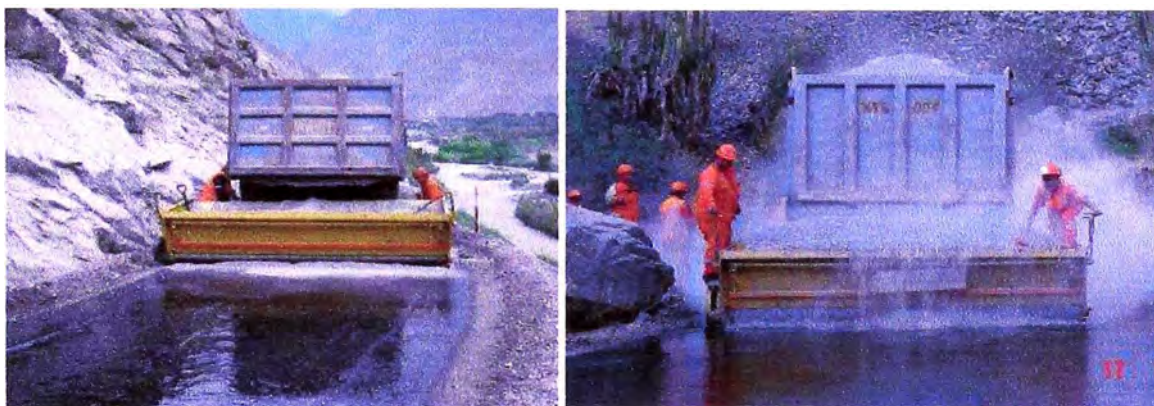
Fotografía 1.05.- Esparcido de gravilla sobre el RC-250
