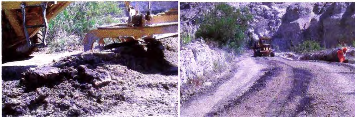
Fotografía 1.02.- Estabilización de afirmado Km. 94+000
