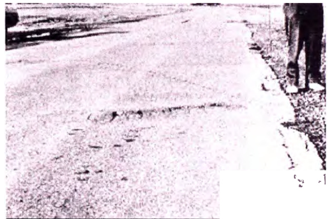
Foto N°12 Hundimiento severidad Alta
