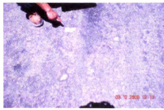
Foto 03: Fallas tipo Bacheo de severidad Baja. Foto 04: Falla tipo Huevo de severidad Baja. Estas fallas son producto del desprendimiento de rocas de la ladera, esto se produce repetitivamente a lo largo de los tres últimos kilómetros de estudio. (km 91+000 – Km 94+000)
