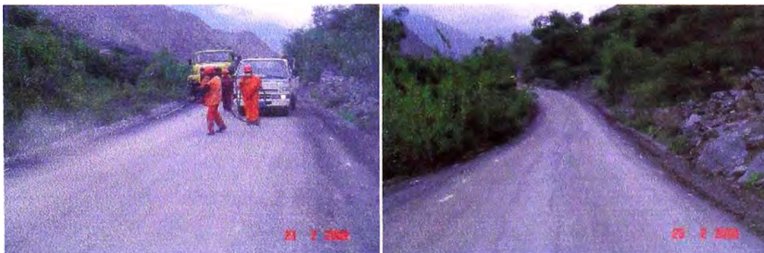
Fotografía 1.03.- Limpieza de superficie estabilizada Km. 90+000
