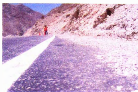
Foto 11: Se observa una vista que nos muestra el grado de severidad por la falta de sello, ocasionando el desprendimiento de agregados en forma prematura en algunos tramos de la carretera. Foto 12: Envejecimiento prematuro por falta de sello, requiere un tratamiento superficial para recuperar su periodo de vida proyectado.
