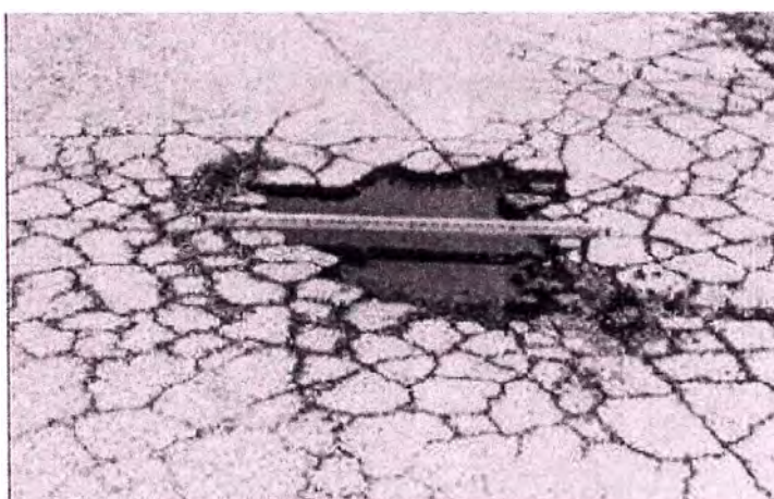
Foto. N°32 Hueco de severidad alta
