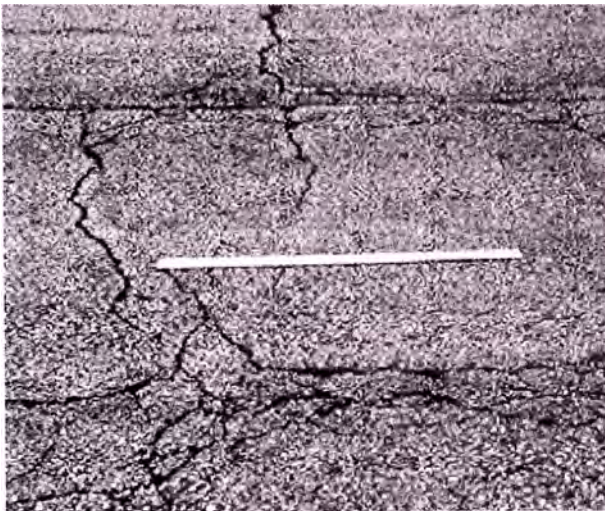
Foto. N°9 Falla en bloque severidad alta
