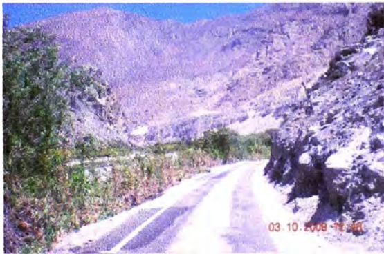
Foto 03: Fallas tipo Bacheo de severidad Baja. Foto 04: Falla tipo Huevo de severidad Baja. Estas fallas son producto del desprendimiento de rocas de la ladera, esto se produce repetitivamente a lo largo de los tres últimos kilómetros de estudio. (km 91+000 – Km 94+000)
