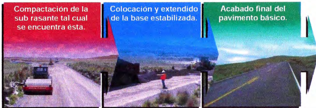
Figura 1.11.- Proceso de ejecución de pavimentos básicos
