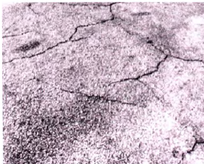
Foto. N°9 Falla en bloque severidad alta
