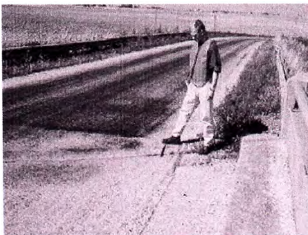
Foto. N°37 Deformación por empuje severidad baja y severidad media
