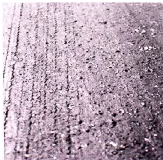
Foto. N°6 Exudación severidad Alta
