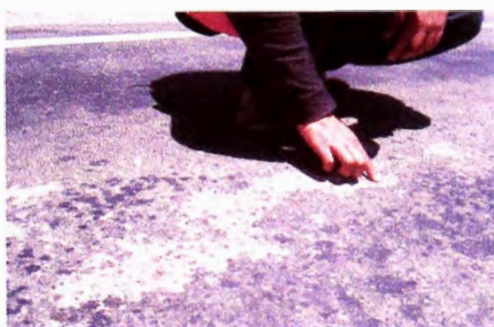
Foto 11: Se observa una vista que nos muestra el grado de severidad por la falta de sello, ocasionando el desprendimiento de agregados en forma prematura en algunos tramos de la carretera. Foto 12: Envejecimiento prematuro por falta de sello, requiere un tratamiento superficial para recuperar su periodo de vida proyectado.
