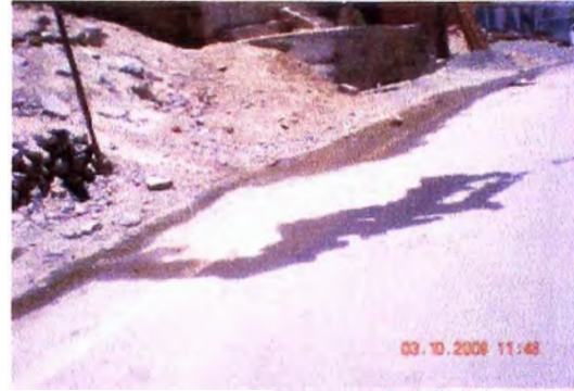
Foto 13: Se observa la ausencia de cunetas, que protejan el tratamiento mono capa recientemente colocado Foto 14: Se observa el uso indebido de la carretera para el riego artesanal, al no haberse construido las cunetas en ambos lados de la vía.
