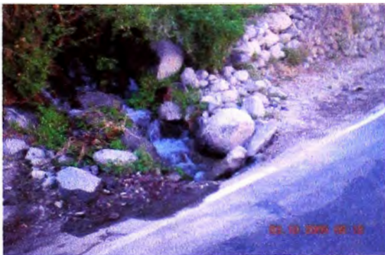
Foto 17: Se observa cruce de canal artesanal, el cual carece de mantenimiento. Foto 18: Se observa la solución adecuada a los cruces de canales, através de una alcantarilla. (km 102+000)
