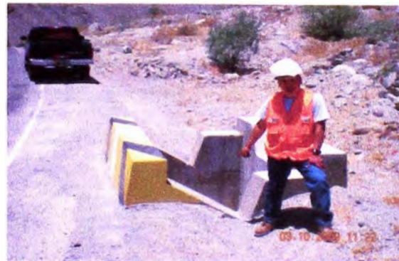
Foto 17: Se observa cruce de canal artesanal, el cual carece de mantenimiento. Foto 18: Se observa la solución adecuada a los cruces de canales, através de una alcantarilla. (km 102+000)
