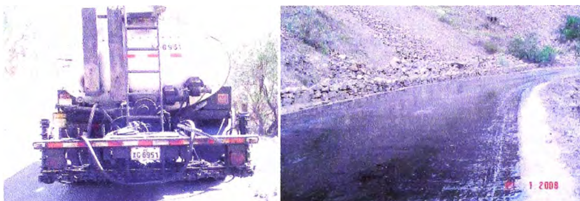
Fotografía 1.04.- Riego de RC-250 sobre la superficie estabilizada
