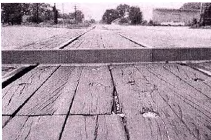
Foto. N°34 Acceso y salidas a líneas férreas severidad alta
