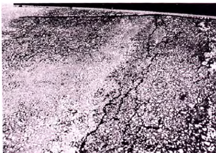
Foto N°12 Hundimiento severidad Alta
