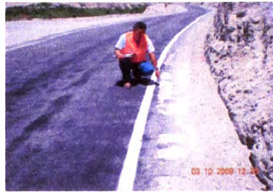
Foto 01: Se muestra el hito de término del tramo en estudio en el km 94+000. Foto 02: Falla tipo Grieta de Borde, con severidad Media y Alta, en la figura se observa el metrado y la identificación de la falla. (km 89+400 – 89+600)
