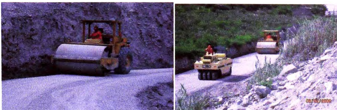
Fotografía 1.06.- Trabajos de compactado
