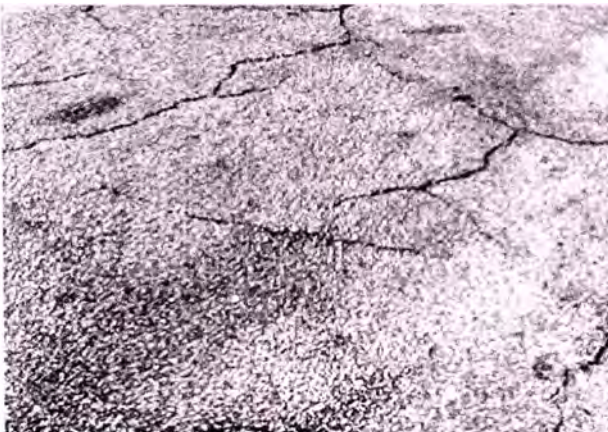
Foto N°12 Hundimiento severidad Alta
