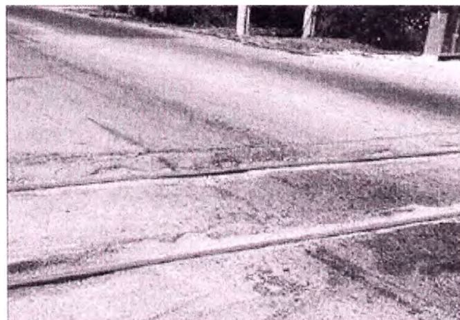
Foto. N°34 Acceso y salidas a líneas férreas severidad alta
