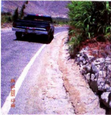
Foto 13: Se observa la ausencia de cunetas, que protejan el tratamiento mono capa recientemente colocado Foto 14: Se observa el uso indebido de la carretera para el riego artesanal, al no haberse construido las cunetas en ambos lados de la vía.
