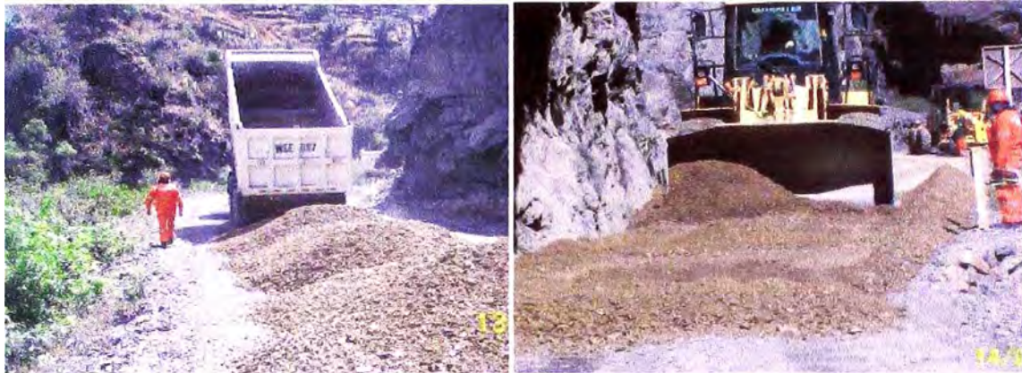
Fotografía 1.01.- Colocación de capa granular con material de cantera
