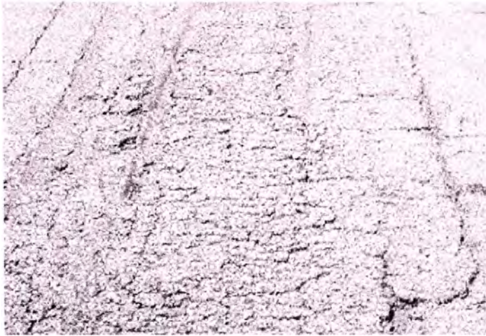
Foto N°42 Disgregación y desintegración severidad baja y severidad media
