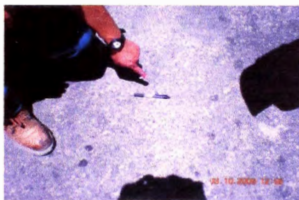
Foto 09: Se observa una falla tipo Huevo de severidad Baja. Foto 10: Se observa falla tipo Bache de severidad Media. Esta falla es producto del desprendimiento de rocas de la ladera en las épocas de lluvias. (km 90+000 – 90+200)
