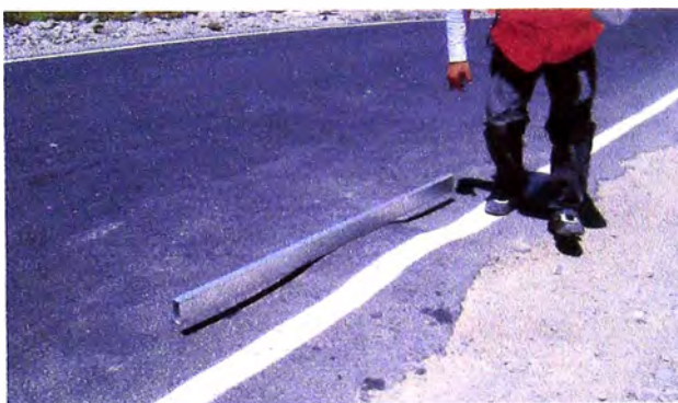
Foto 05: Se observa una falla tipo Hinchamiento de severidad baja. Foto 06: Se observan varias fallas consecutivas tipo Huevo de severidad Baja. (km 90+100 – Km 90+300)
