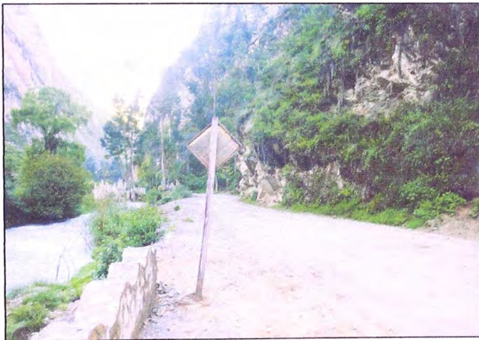
Foto N° 2: Tramo final, vista de ladera de la vía con el río,
