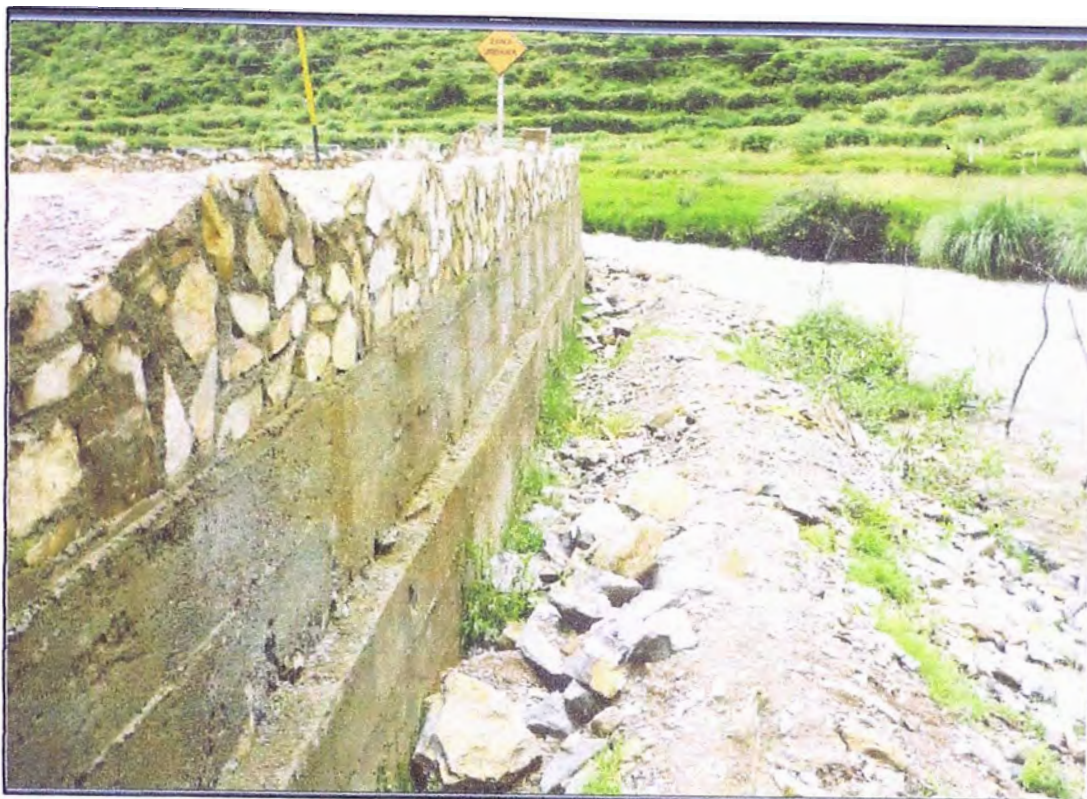
Foto N° 5: Vista de laderas del río, donde se aprecia que el tirante es pequeño, se asumirá para el estudio un tirante normal de 1.00m.
