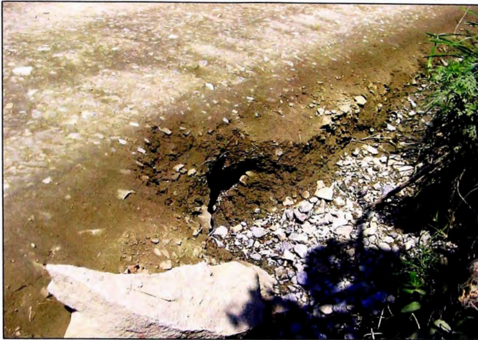
FOTO N° 5 – Una tajea en el tramo de la carretera.
