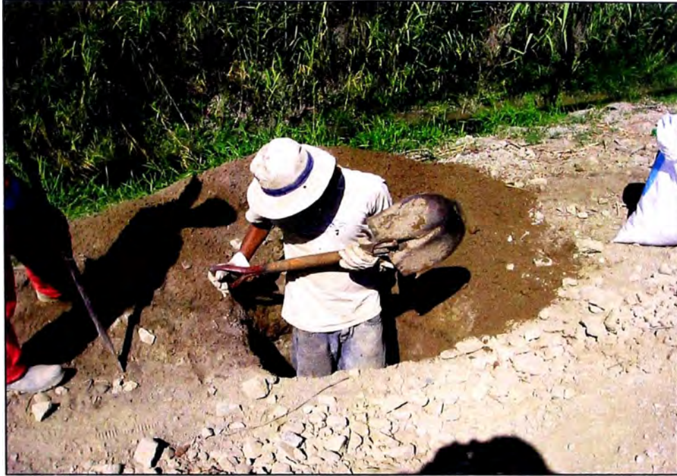
FOTO N° 1 – Excavación de calicata en la progresiva 57+450.
