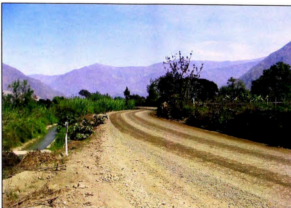
FOTO N° 3 – Vista panorámica de la Carretera Cañete – Yauyos Km 57+300 al 57+600.
