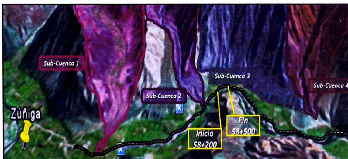
Figura N°2.1.2 Vista Panorámica del Tramo km 58+200 al 58+500
