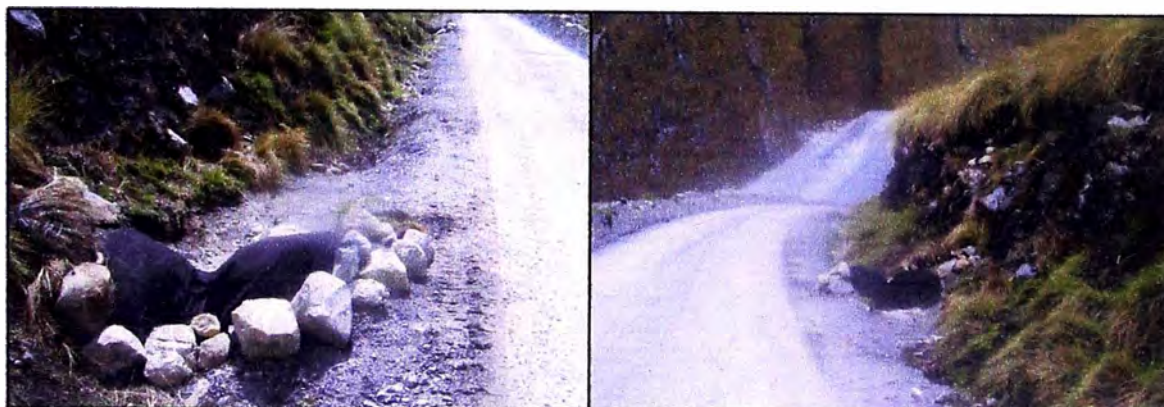
Figura N°2.6.4 Vista de diques-sedimentadores en cuneta para control de turbidez en agua
