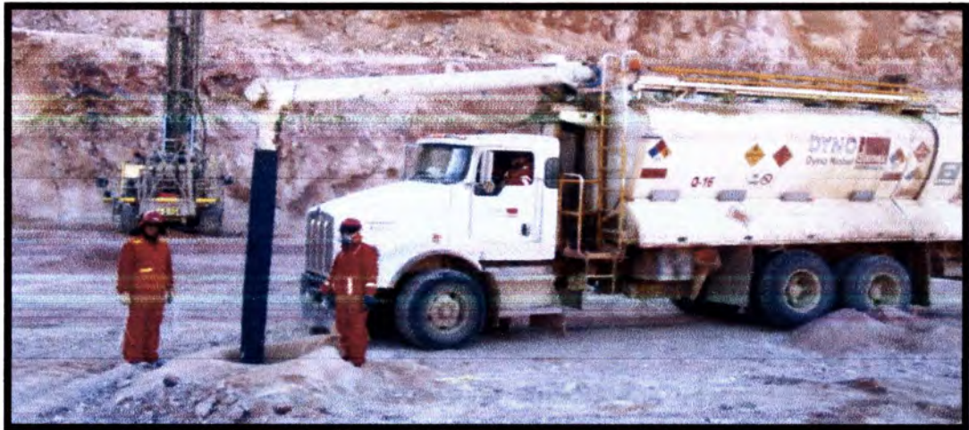
FIGURA 6: LLENADO DEL TALADRO CON EXPLOSIVOS
