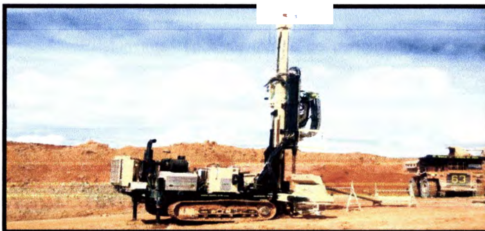
FIGURA 5: ACTIVIDAD DE PERFORACIÓN
