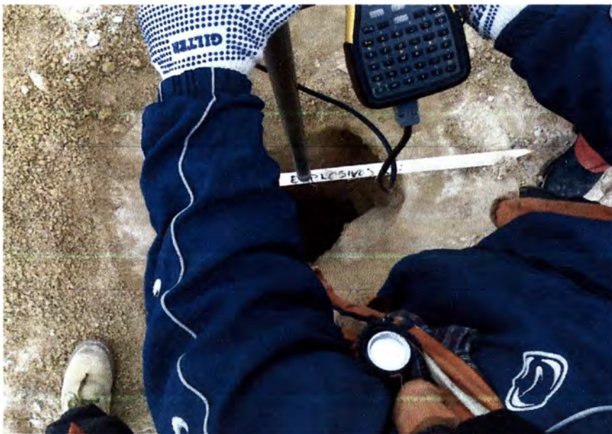
Figura 25: Topógrafos replanteando el punto según diseño.
