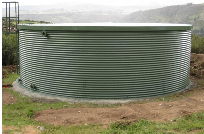
Figura N° 2. Cimentación de reservorio Ilurco con zuncho perimetral
