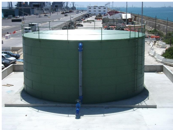
Figura N° 1. Reservorio Ilurco de construcción modular
