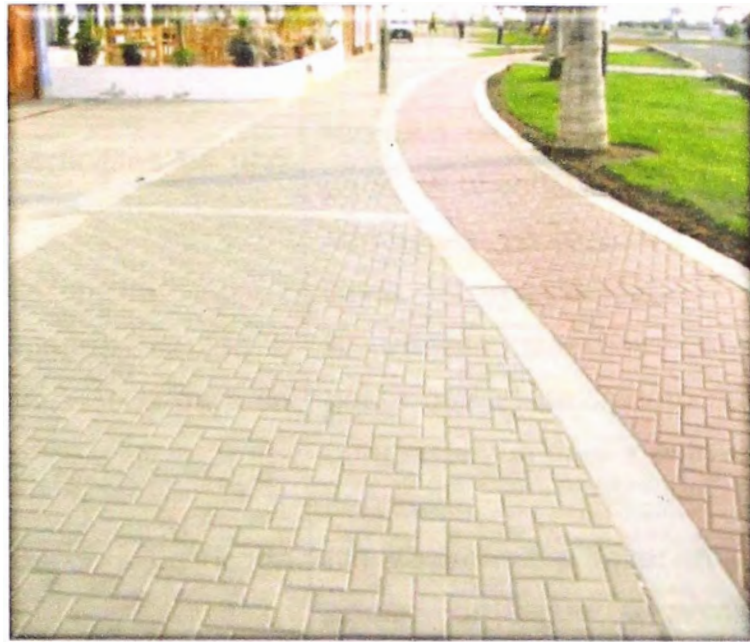
Gráfico N° 2.4.1: Pavimento de adoquines en Boulevard playa Huanchaco Trujillo
