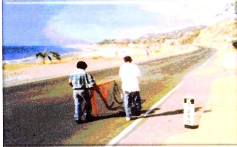
Gráfico N° 4.2.3: Estudio de rugosidad método Merlin
