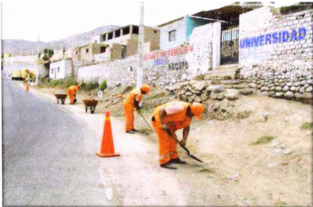
Gráfico N° 4.1.1: Limpieza de la zona de derecho de vía
