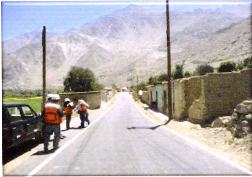
Foto N° 69: ZONA SAN JUAN, ubicado en el Km. 67+000.
