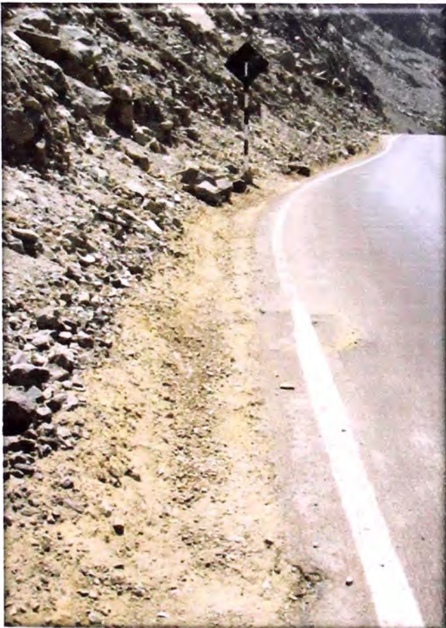
Foto N° 1: Km 68+950 al Km 69+000: Problemas de Drenaje – Cunetas de tierra en mal estado
