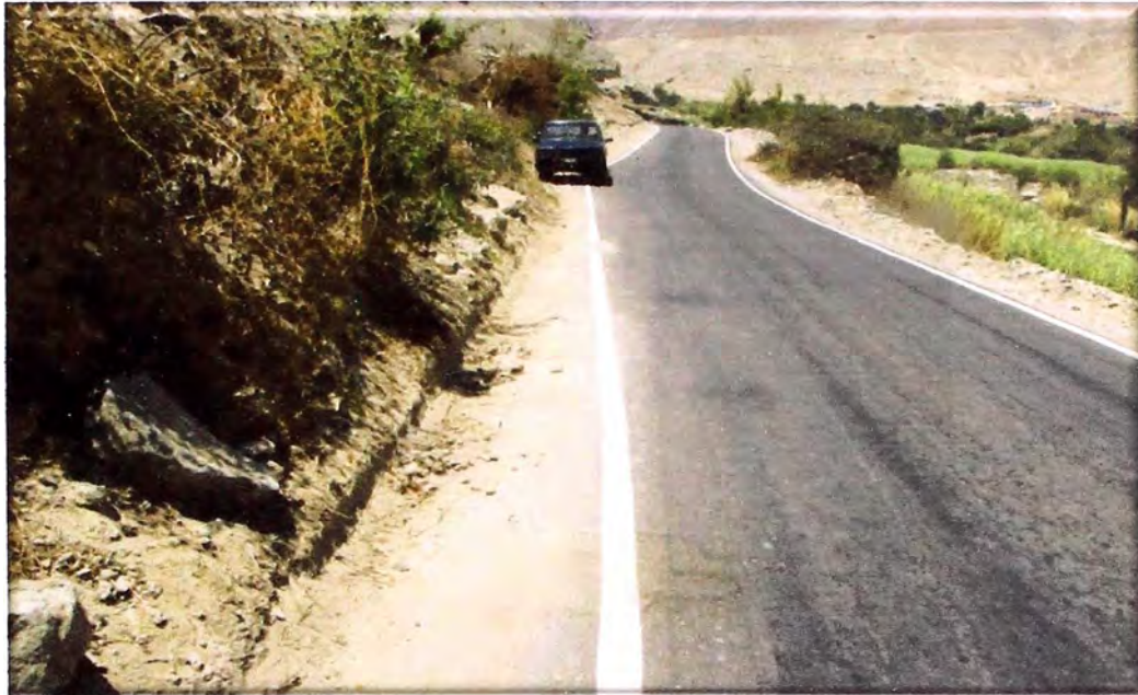
Foto N° 13: Km Km 67+000 al 68+000: Necesidad 03 alcantarillas TCM D=12", de longitud 4m c/u, por derrame de agua de terrenos de cultivo adyacente a la carretera.
