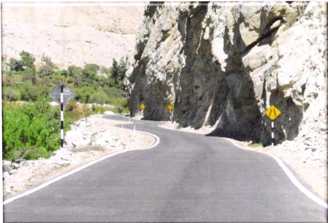
Foto N° 77: DISEÑO GEOMETRICO (anchos angostos, curvas reducidas): se observan entre el Km. 67+000 y el Km. 68+000. Se mitigara el peligro con reducciones de velocidad.
