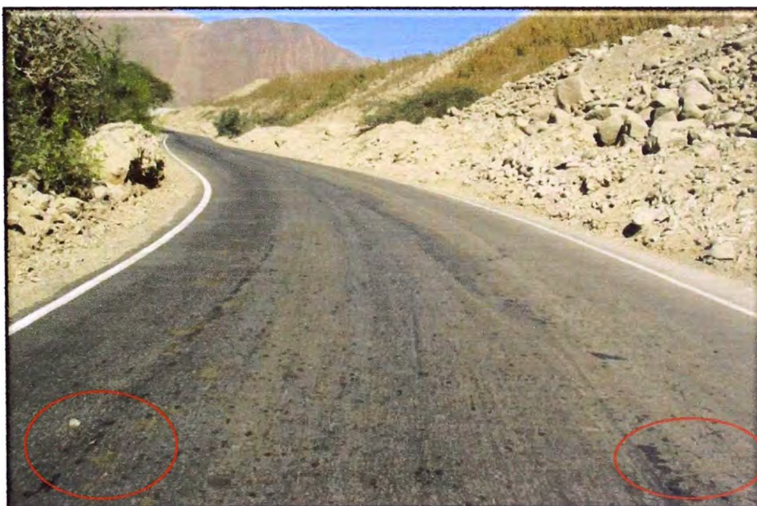
Foto N° 47: Km 64+700 en la imagen se ve que unos de los grandes problemas por lo cual el pavimento se deteriora rápidamente en muchas partes del Perú es por el aceite que los vehículos dejan cuando estos circulan por la vía, esto deteriora a la vía con el tiempo.
