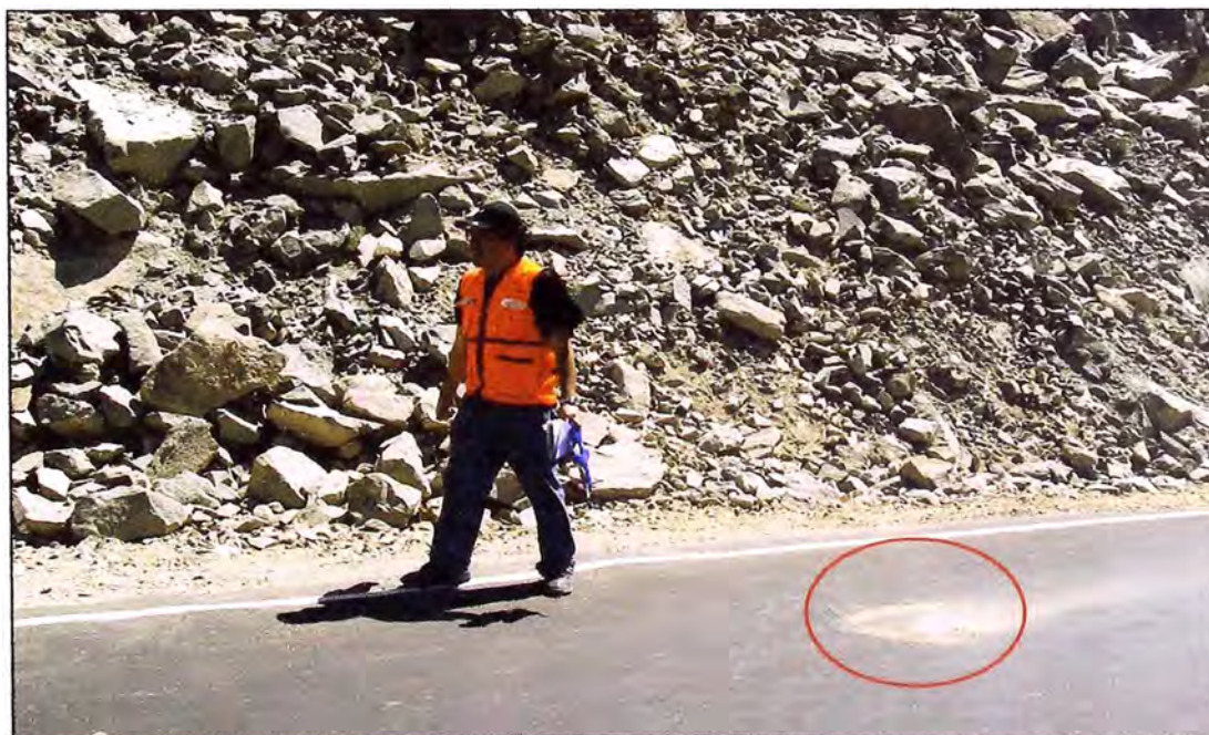
Foto N° 19: Km 68+960 se encuentra otra deformación producto de una piedra, al momento que fue aplicado del tratamiento con el slurry seal.
