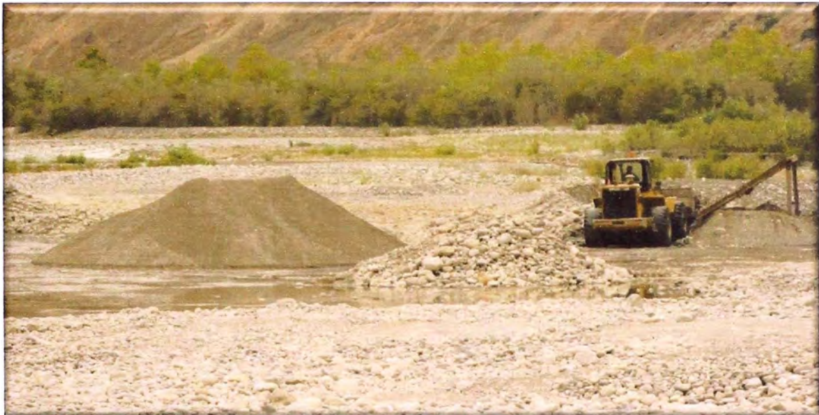
Gráfico N° 1.10.1: Cantera de la Central Hidroeléctrica El Platanal
