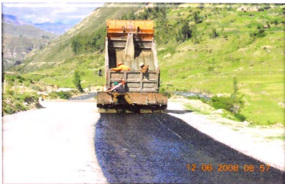
Gráfico N° 2.2.2: Tratamiento Superficial Bicapa Carretera Huallanca – La Unión – Huánuco.
