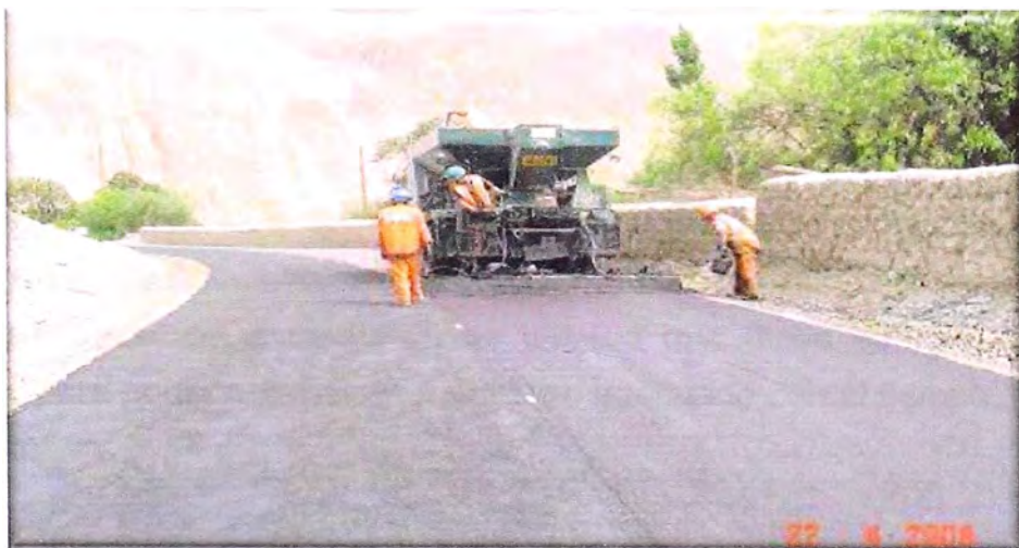
Gráfico N° 4.2.2: Colocación de slurry seal
