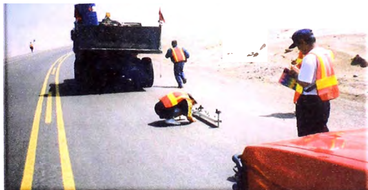
Gráfico N° 4.2.4: Medición de deflexiones con Viga Benkelman
