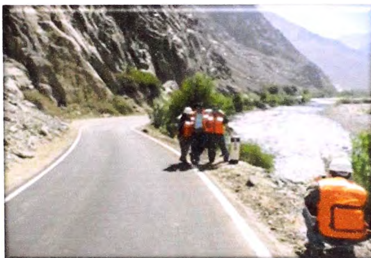
Foto N° 80: En el Km. 69+000 existencia de curva peligrosa, no existiendo postes delineadores o en el mejor de los casos la colocación de guardavías
