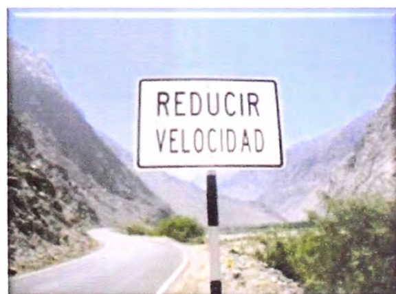
Foto N° 80: En el Km. 69+000 existencia de curva peligrosa, no existiendo postes delineadores o en el mejor de los casos la colocación de guardavías
