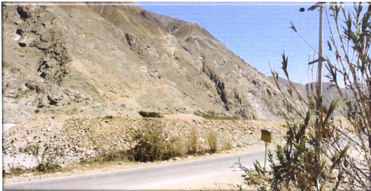
Foto N° 49: KM 65+700: Se ubica cerca de San Juanito, en esta zona el cauce el río se ensancha.
