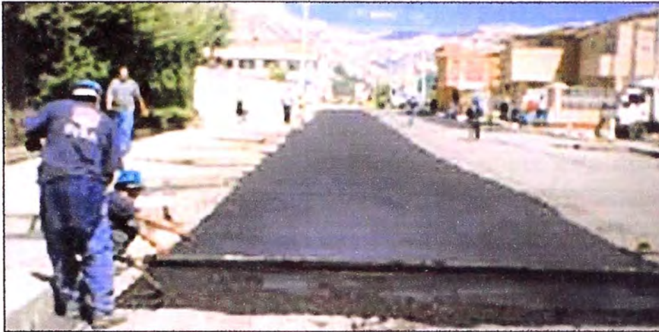
Gráfico Nº 2.3.1: Slurry Seal manual - Huaraz
