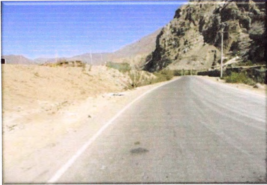
Foto N° 71: Deposito 2 - Ubicado en el Km 65+950
