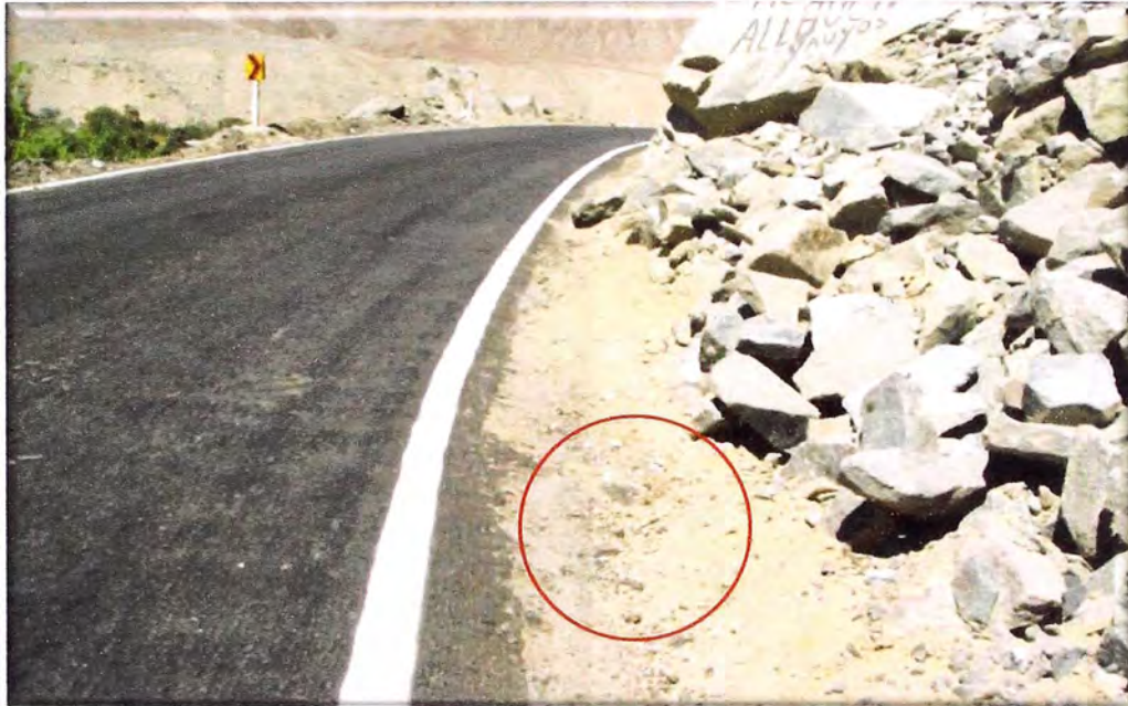
Foto N° 1: Km 68+950 al Km 69+000: Problemas de Drenaje – Cunetas de tierra en mal estado
