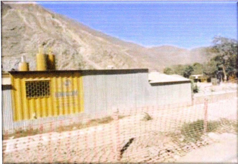
Foto N° 72: Planta Concretera UNICON: Laboratorio móvil de la empresa abastecedora de concreto para trabajos en central hidroeléctrica ubicado en el Km 65+350.
