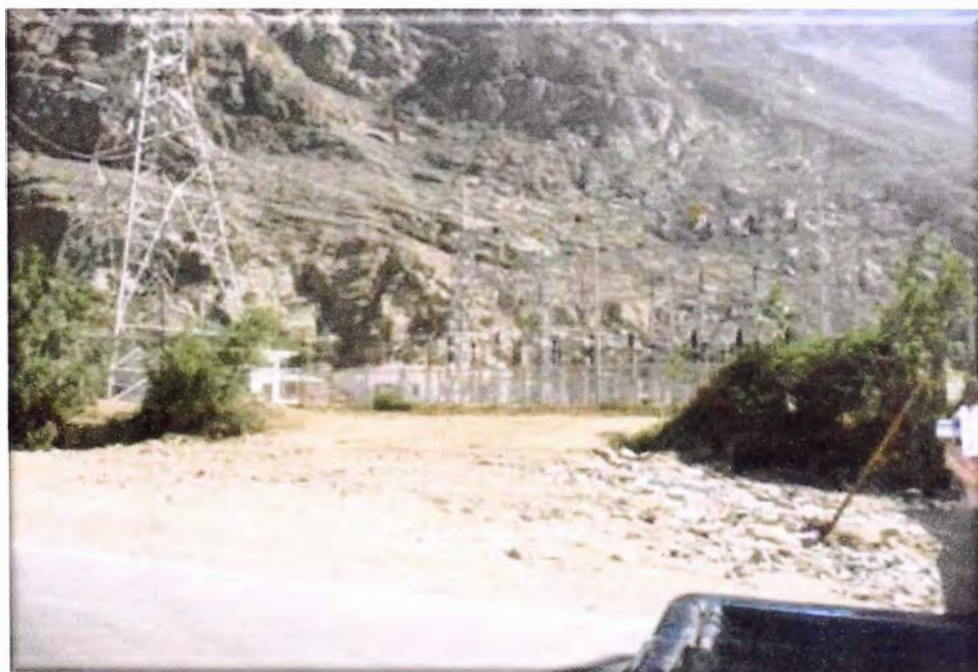
Foto N° 74: S.S.K. Empresas de desmontaje e instalaciones del Proyecto "El Platanal": Ubicado en el Km. 65+950
