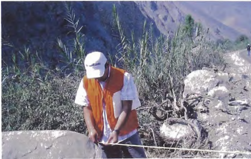
FOTO N° 2: Reconocimiento del ancho de la plataforma en el inicio del tramo, se verifica que se necesita ampliar la vía.
