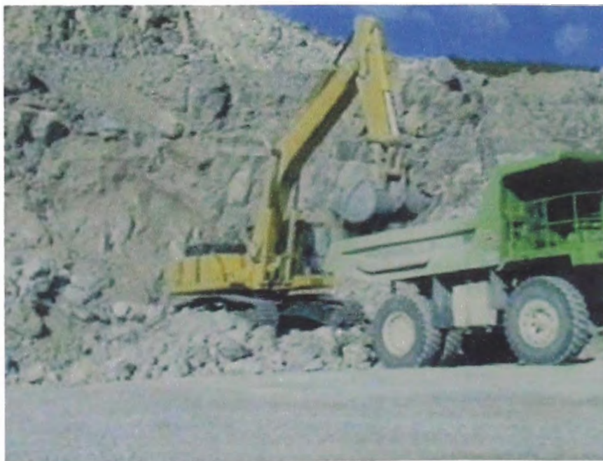
FOTO N° 14: Cantera de piedra para muro KM 61+900.
