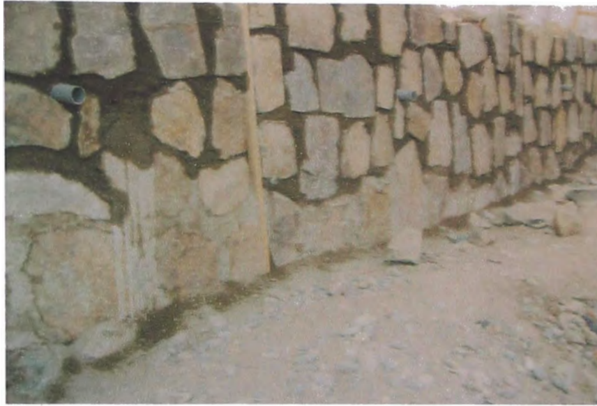
FOTO N° 15: Construcción de un muro de mampostería, se ve las tuberías para el drenaje y las juntas.
