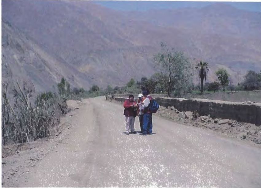
FOTO N° 1: Inicio del tramo.
