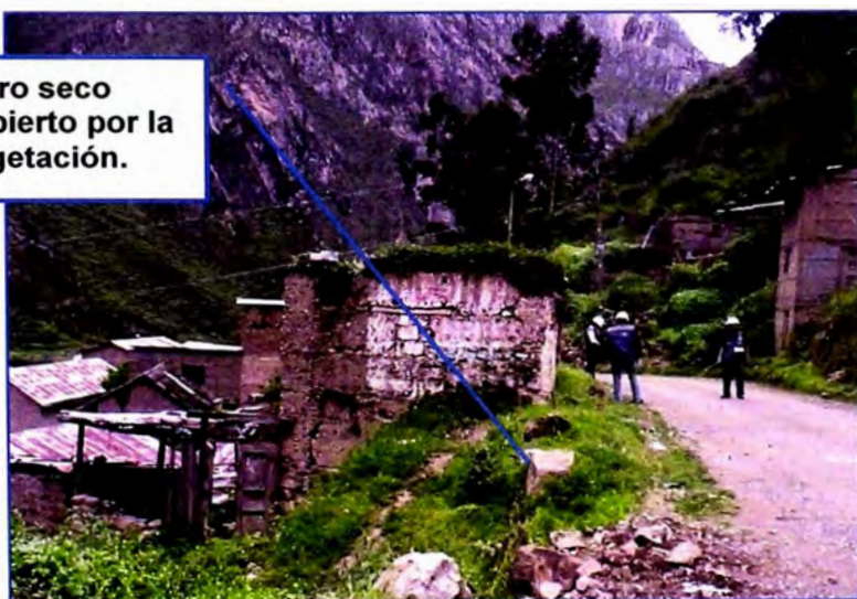
Foto N° 3.4: Progresiva Km 165+270 LD. Vista atrás.
