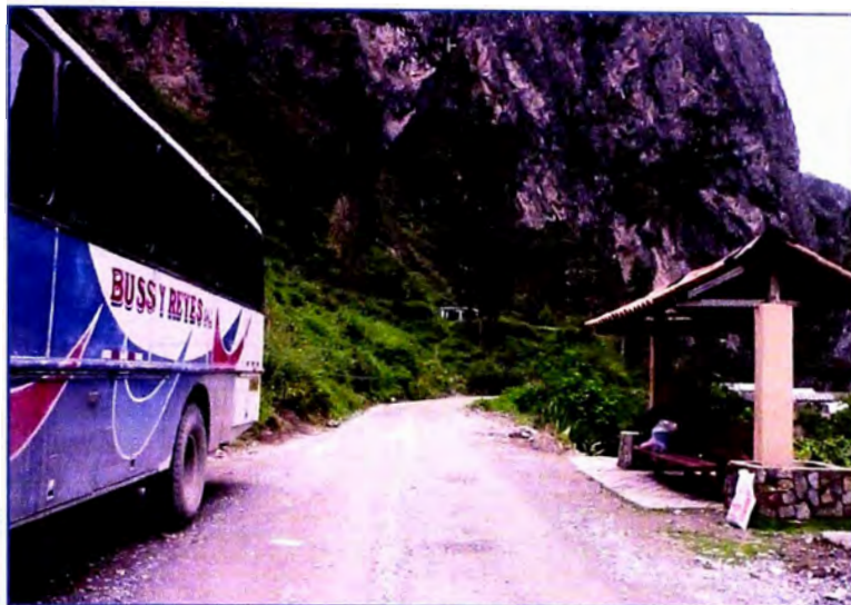
Foto N° 3.5: Paradero - Progresiva Km 165+290 LD
