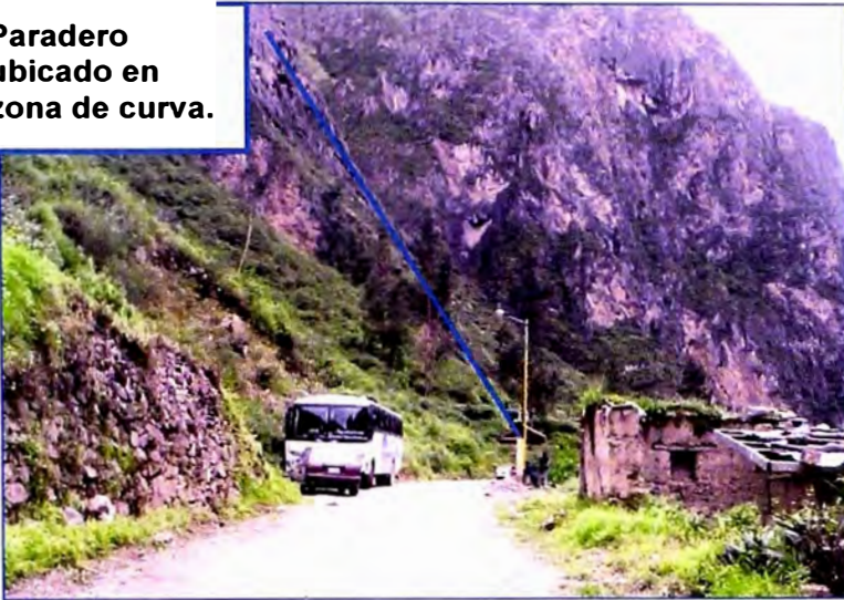
Foto N° 3.6: Vista Panorámica del Paradero
