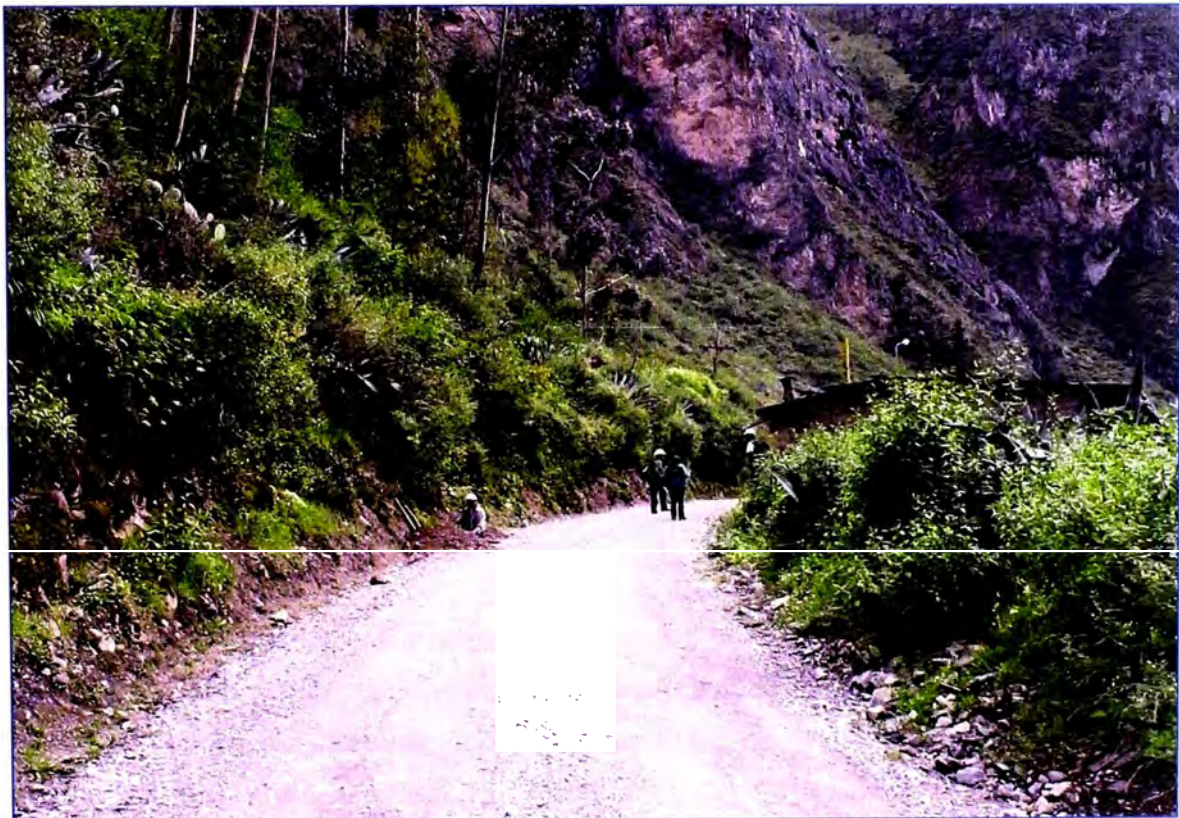
Foto N° 1.2 Sección Media Ladera km 165+150
