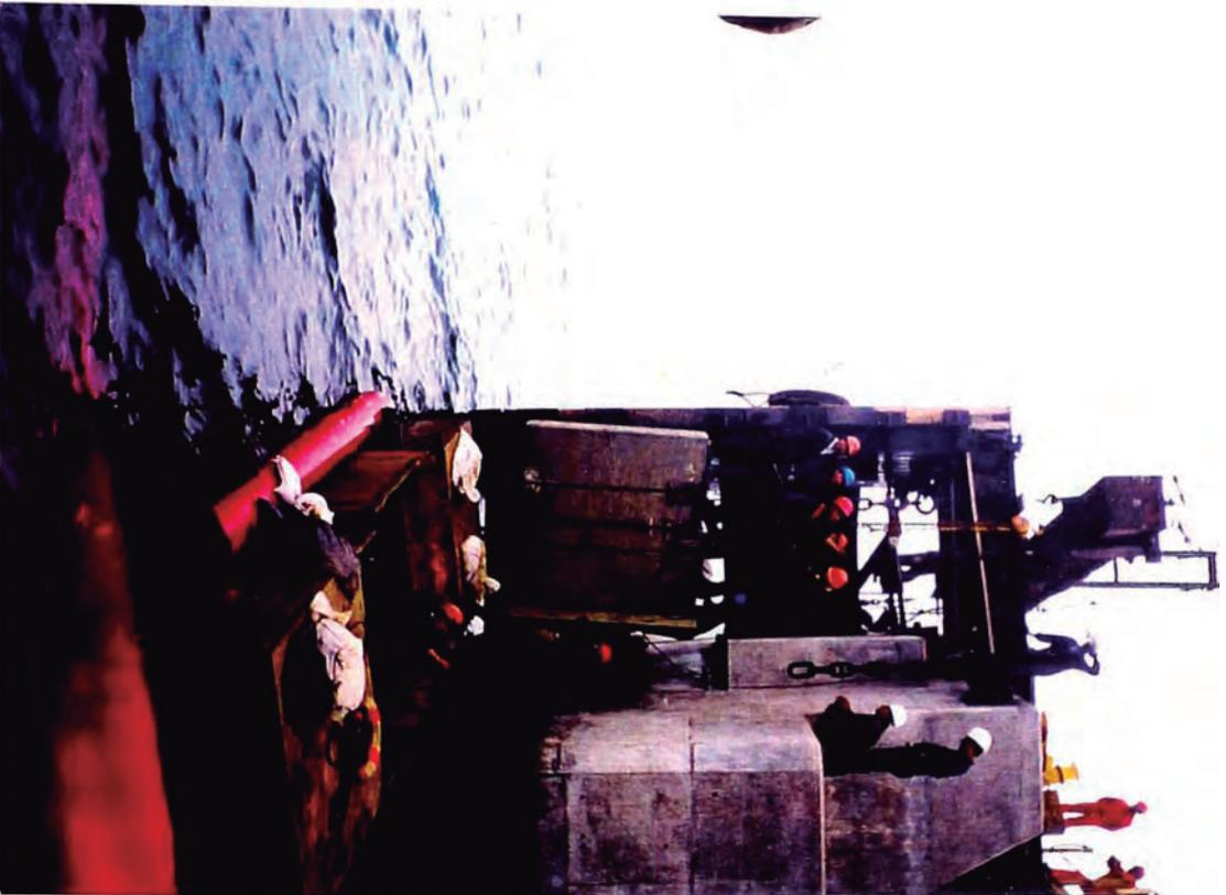
7.- Maniobra de izaje del fender Seibu. Nótese las vigas VS y VE arriba y el bote que trasladará el jebe abajo.
