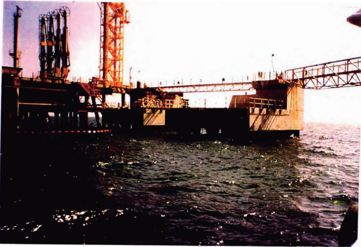
1.- Vista de la parte posterior de los dolphines de atraque BD3 y BD4. Se aprecia la plataforma del muelle con los brazos de carga
