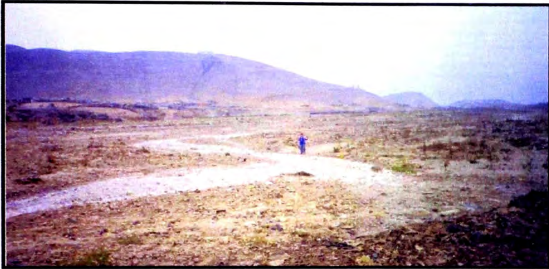
FOTO N° 2.11 Chuquitanta, el río se desplaza lateralmente, no existe diques de protección. (Progresiva km 4+181)
