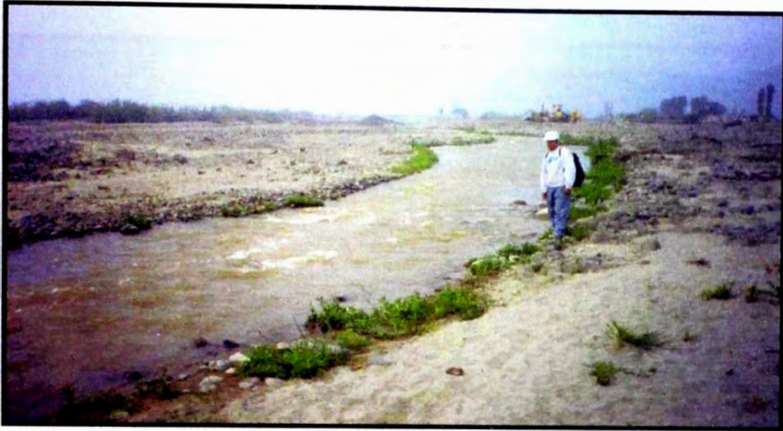
FOTO N° 2.3 Punchauca, el río se desplaza lateralmente, no hay diques de protección al valle. (Progresiva km 24+000)
