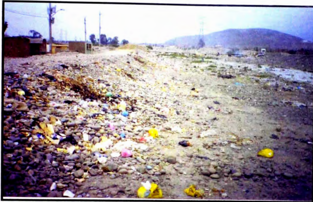
FOTO N° 2.9 San Diego, los diques de protección son inadecuados. (Progresiva km 6+431)
