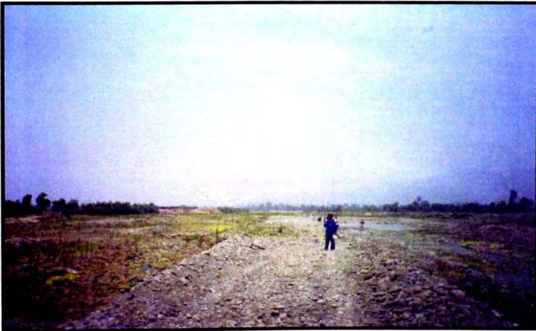
FOTO N° 2.6 Caudivilla, el río no está encauzado. (Progresiva km 17+311)
