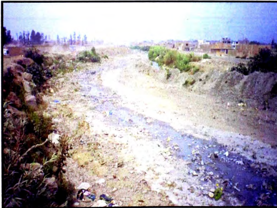
FOTO N° 2.8 Pro Lima, los diques de protección se hallan destruidos. (Progresiva km 8+811)
