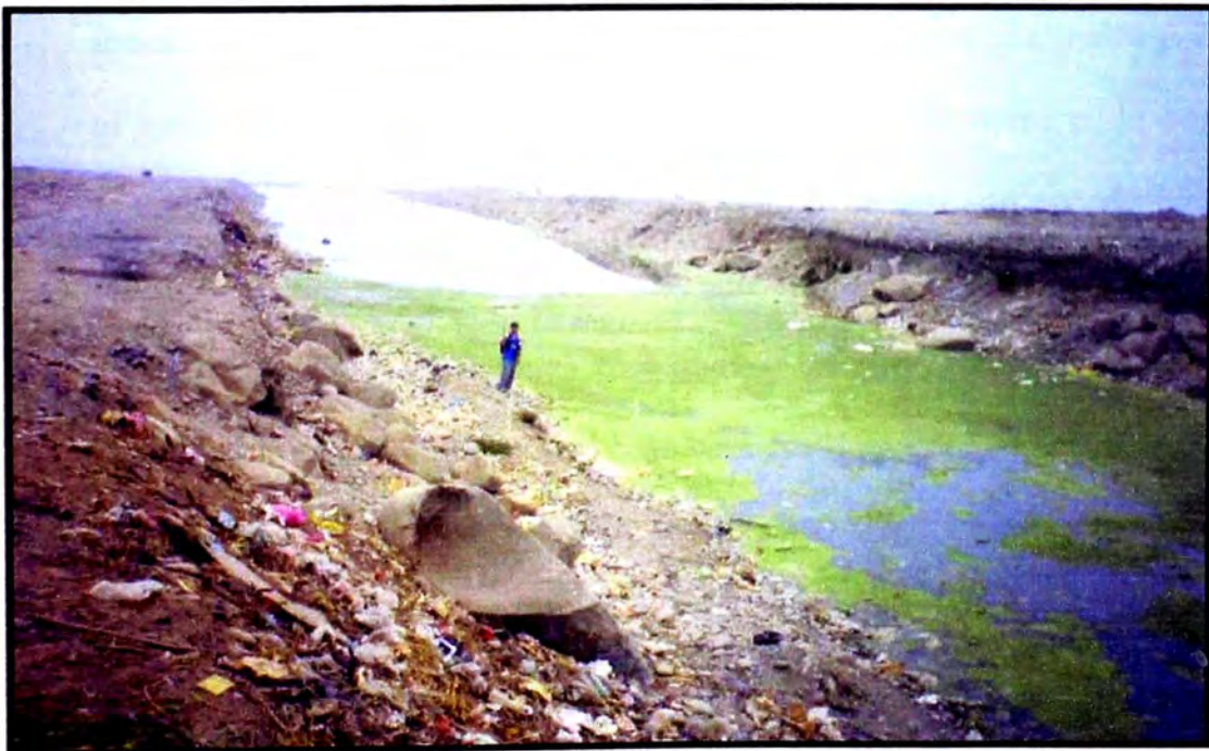
FOTO N° 2.14 Desembocadura, gaviones de protección están destruidos. (Progresiva km 0+60)
