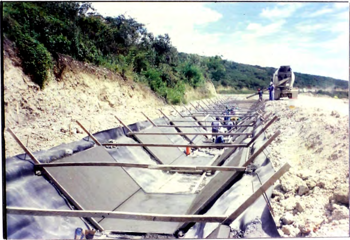
Vista de paños acabados intercalados separados con sus respectivas serchas.
