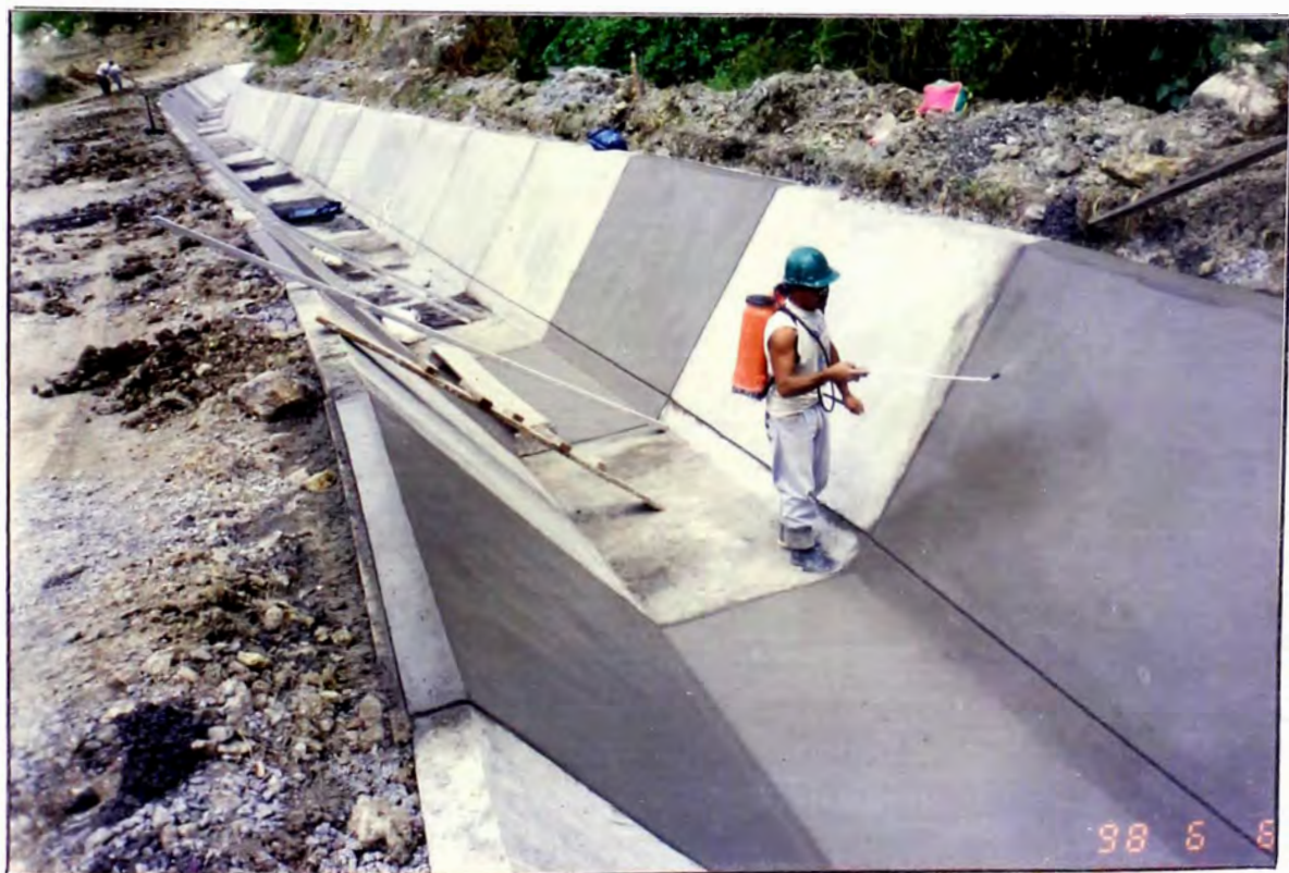
Aplicación del curador por el método de aspersion, operado mecánicamente, inmediatamente después que haya desaparecido el brillo del agua y del acabado final del concreto.
