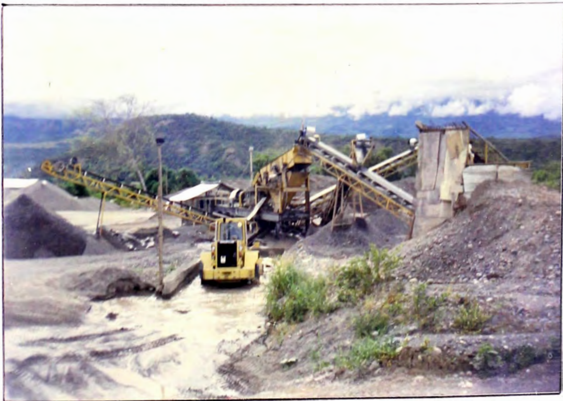
Poza a pie de la chancadora para el lavado de arena, extracción de arena lavada.
