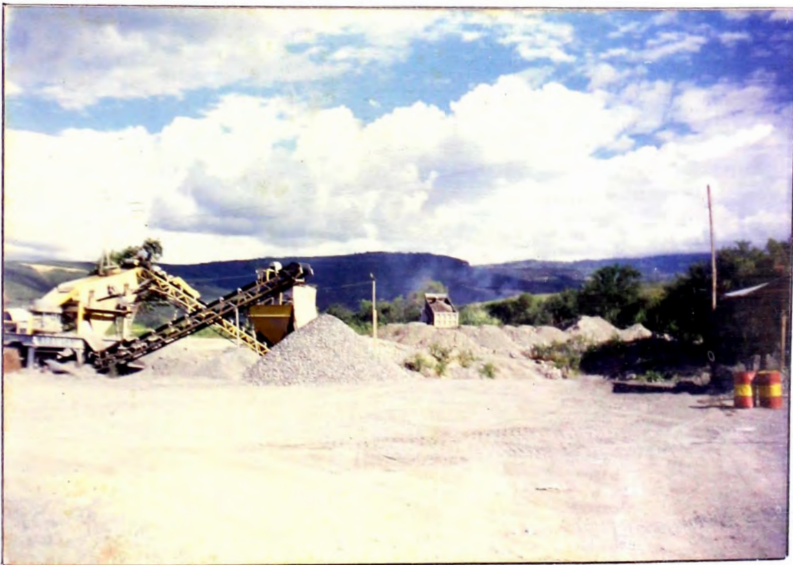
Acumulación de hormigón en Planta Chancadora, para la producción de agregados para elaborar concreto pre-mezclado.
