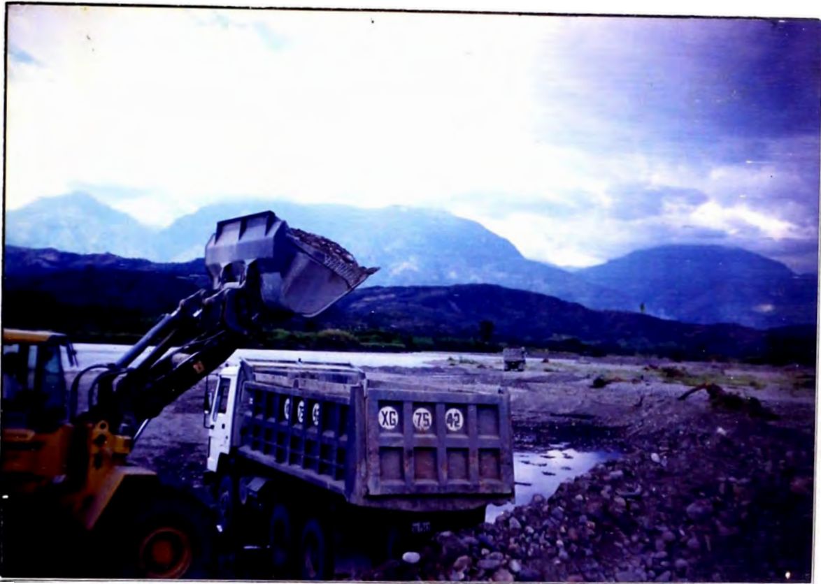
Explotación de cantera ubicada a orillas del río Utcubamba, Bagua Grande, Amazonas, proceso de extracción, acopio, cargio y transporte de hormigón.
