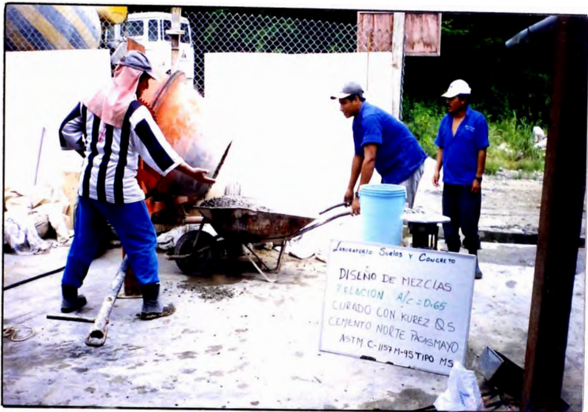
Proceso de mezclado de concreto, según los diseños de mezcla.
