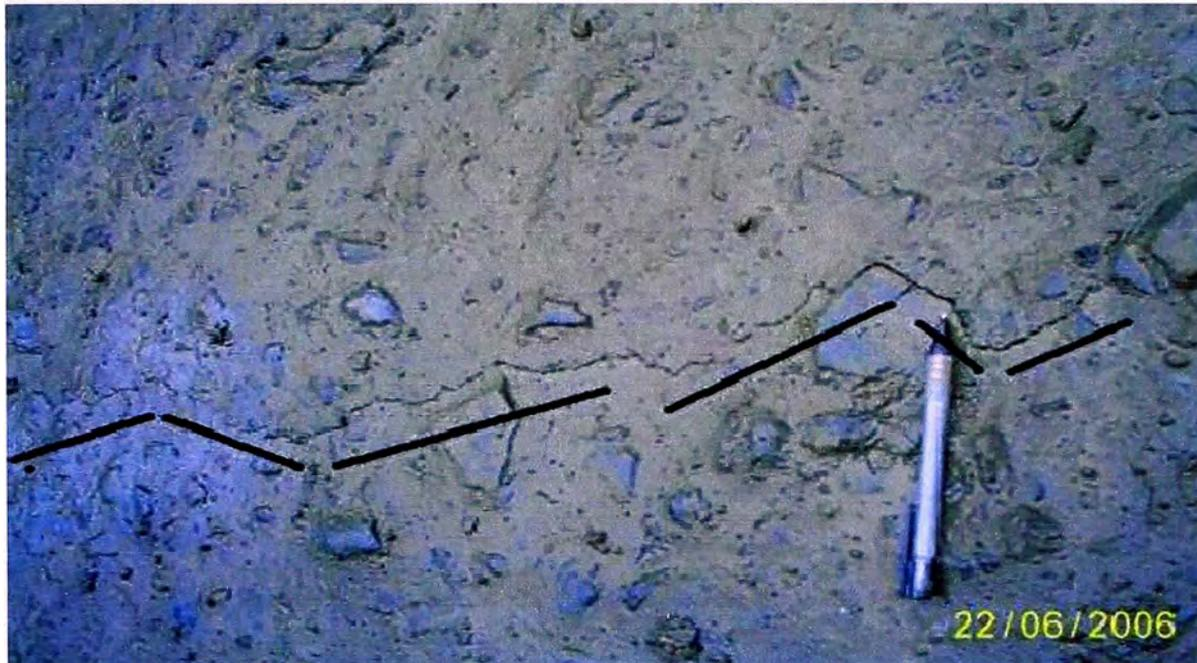
**Problema: Fisuramientos longitudinales en la plataforma de la vía.**
