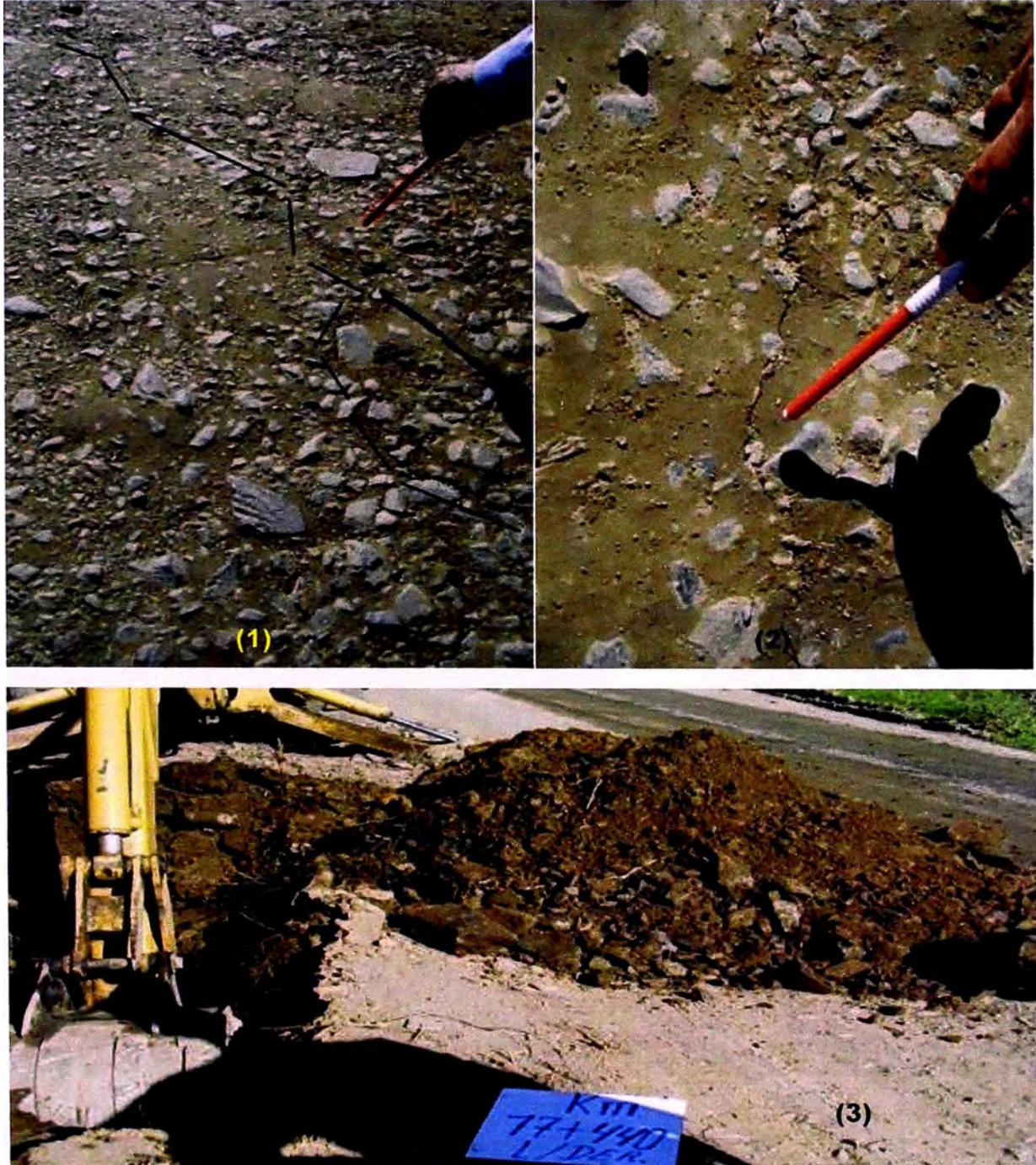
**Problema: Fisuramientos longitudinales en la plataforma de la vía (1 y 2).**
