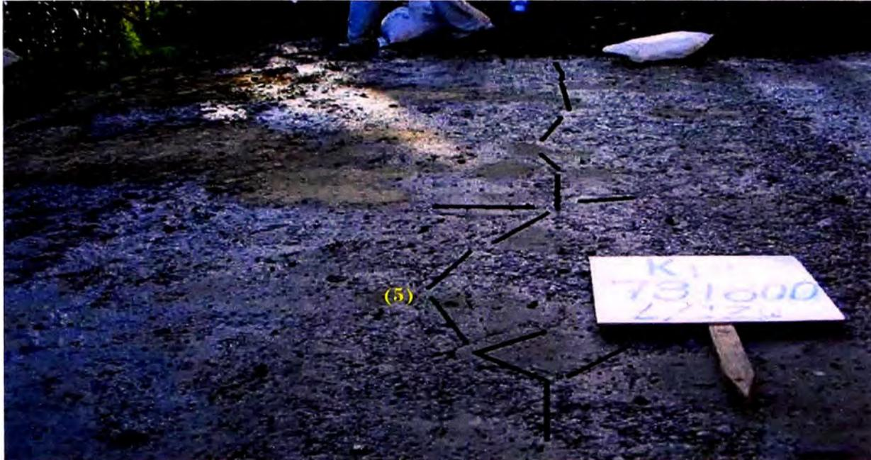
**Problema: Fisuramientos longitudinales (5) en la plataforma de la vía.**
