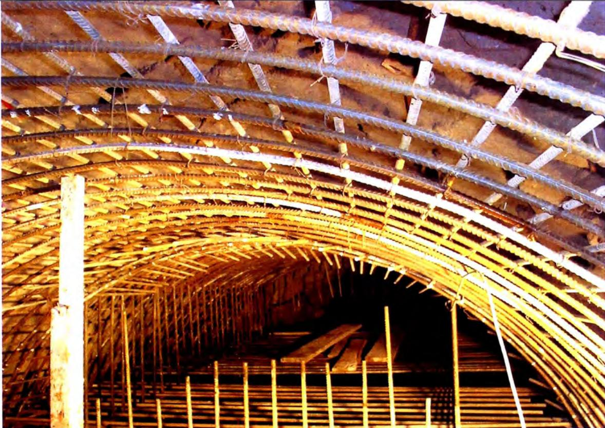
Foto N° 14: Armadura en el Tapón Nivel -100.
