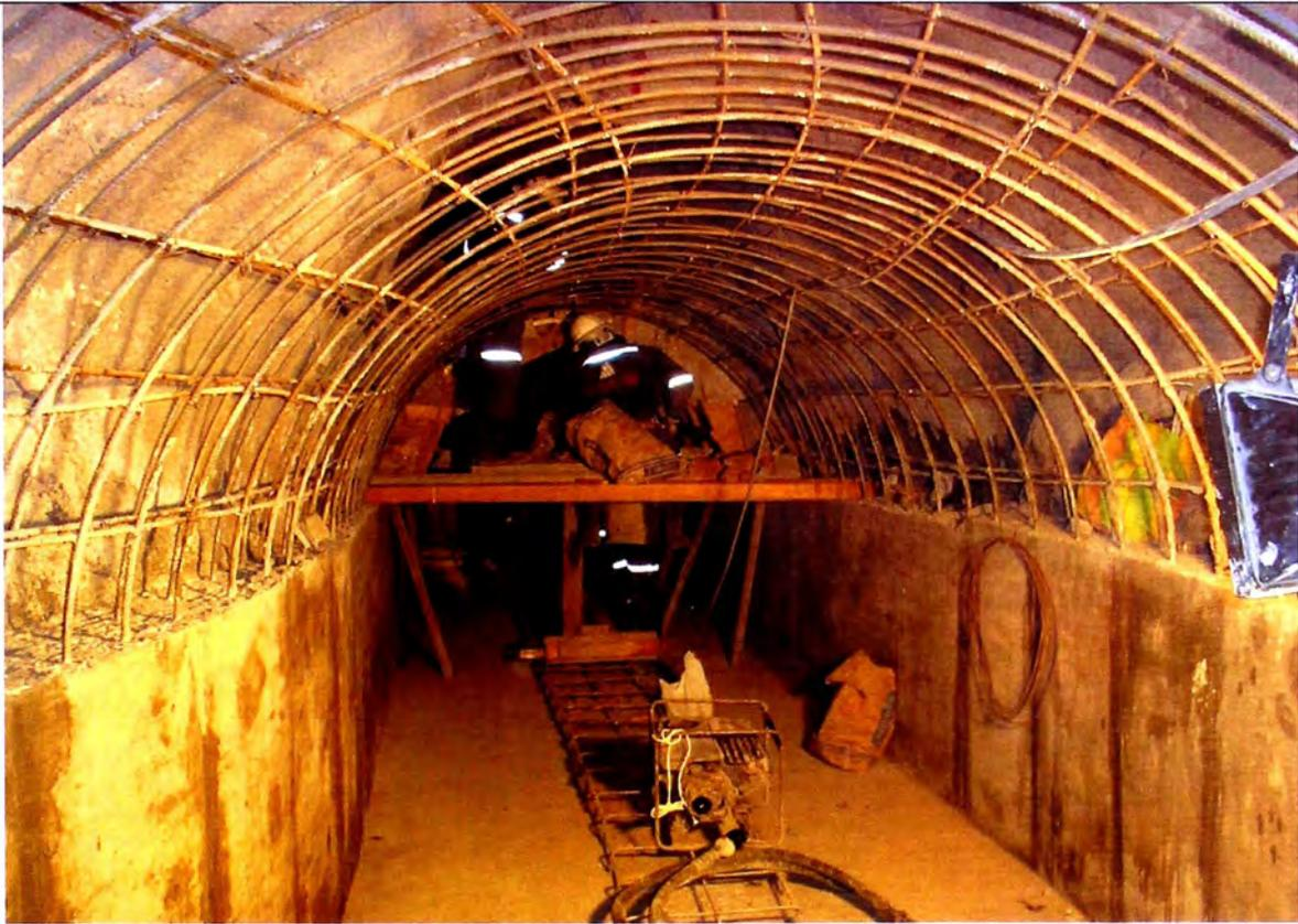
Foto N° 10: Vaciado de concreto de bóveda en túnel de drenaje.
