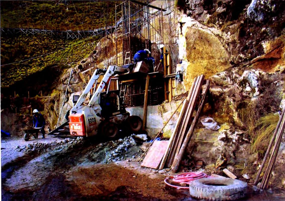
Foto N° 07: Vaciado de concreto de muros Ventana N°13 con Bobcat.
