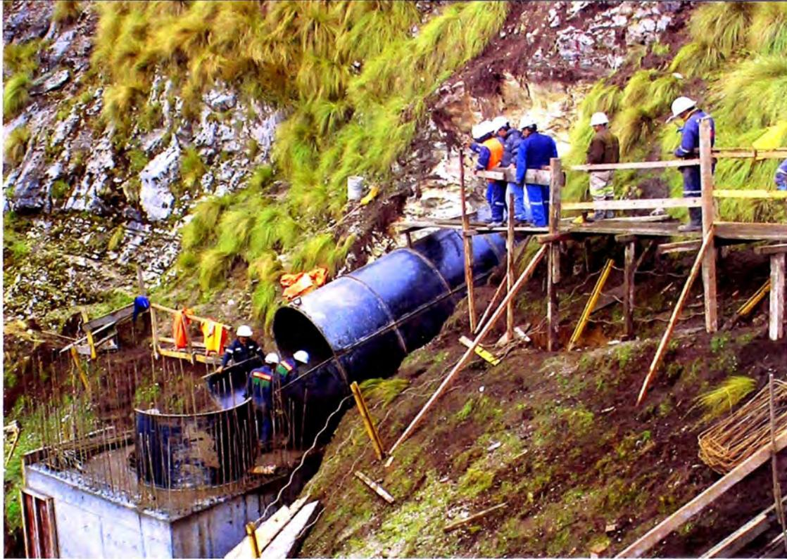
Foto N° 16: Colocación de tubería metálica para ampliación de pique.
