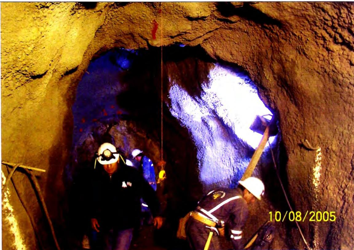
Foto N° 04: Shocrete colocado en túnel de drenaje.
