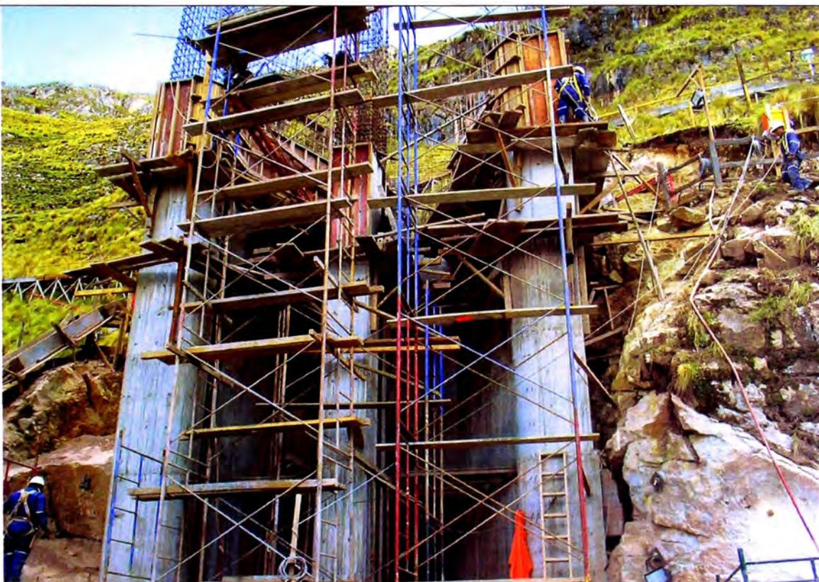
Foto N° 09: Vaciado manual de concreto en muros Ventana N°13.
