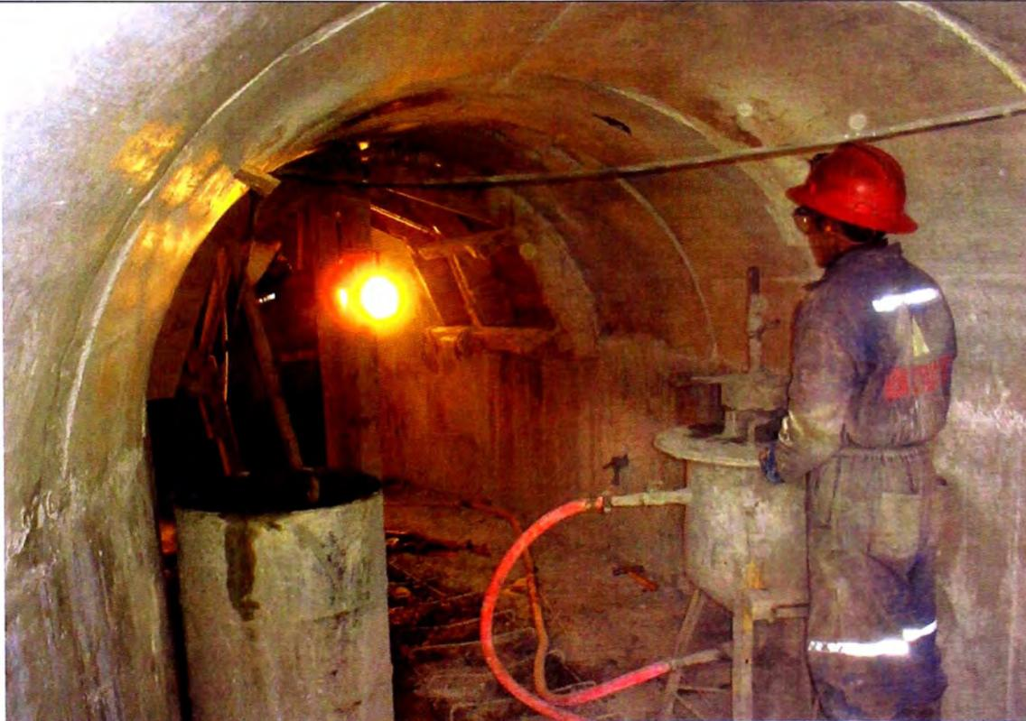
Foto N° 11: Inyecciones en túnel de drenaje.
