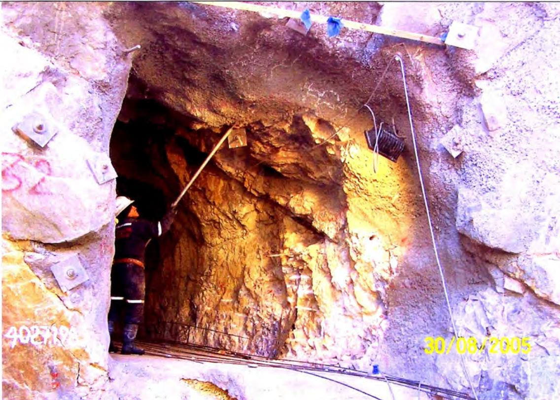
Foto N° 03: Desquinche de rocas en túnel de drenaje.
