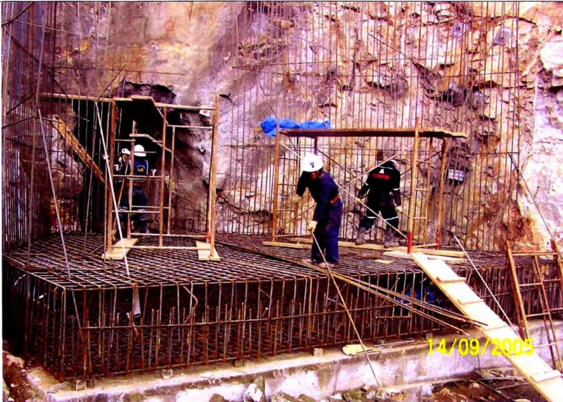
Foto N° 06: Armadura en Zapata de Ventana N° 13.
