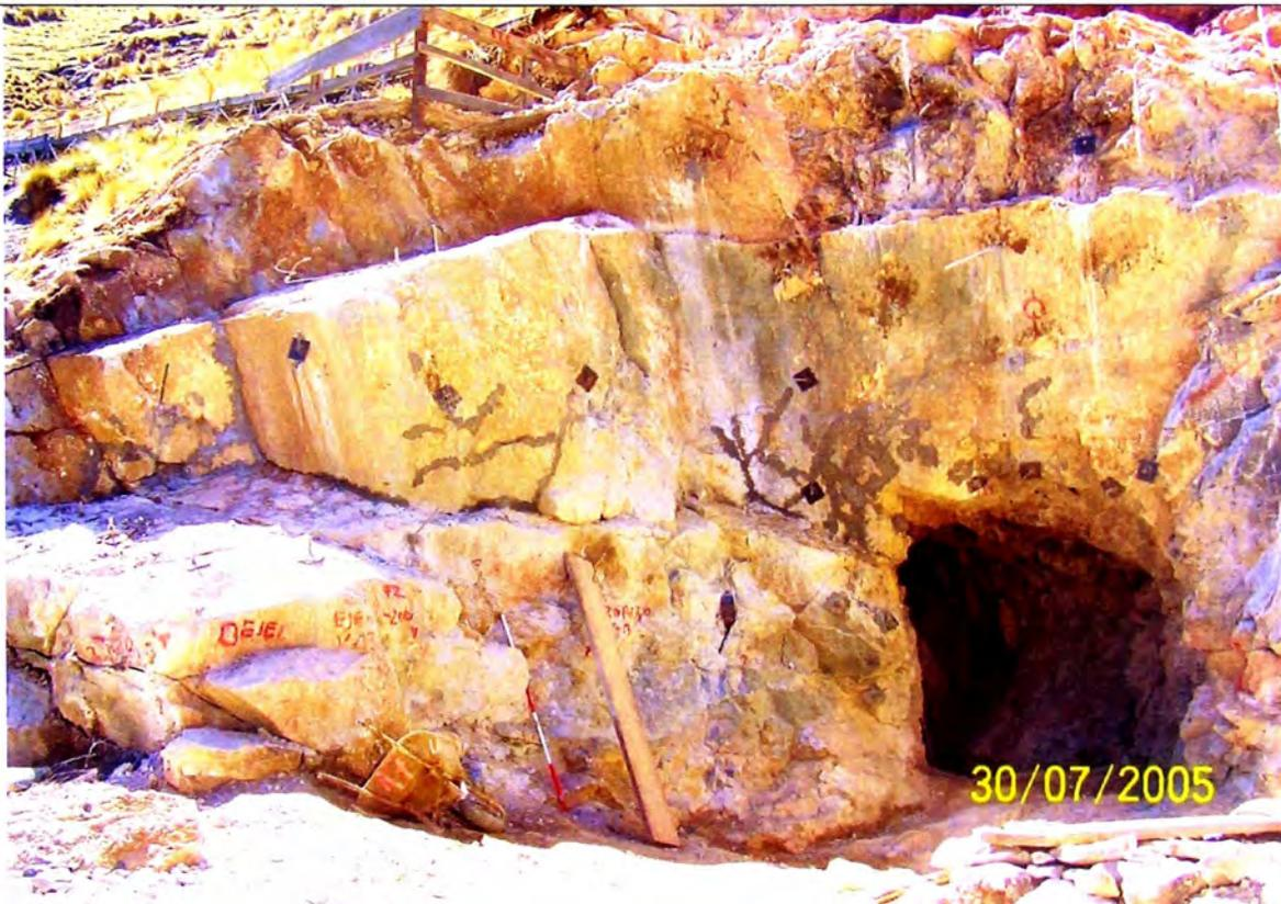
Foto N° 02: Pernos de anclaje en la Ventana N° 13 y túnel de drenaje.
