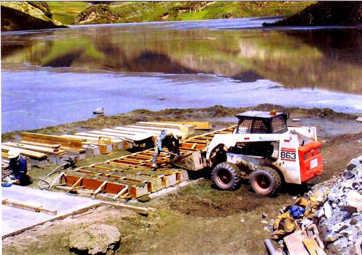
Foto N° 17: Fabricación de ataguías de concreto armado.
