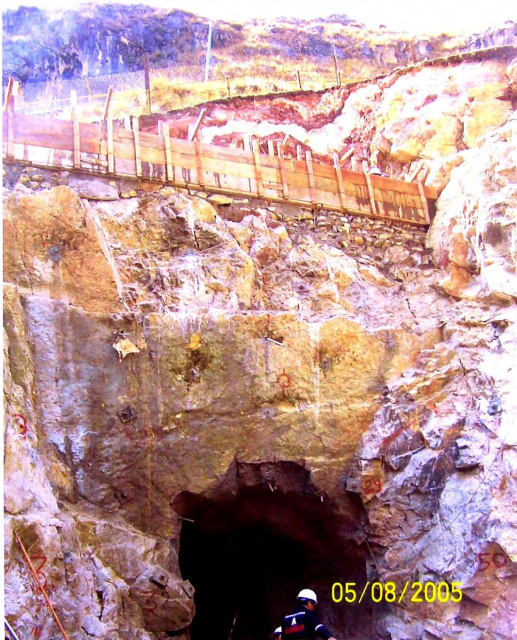
Foto N°05: Pernos de anclaje y muro de contención nivel 4036.
