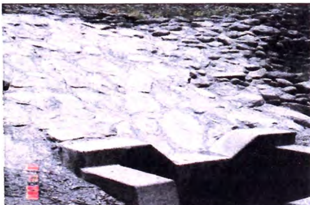
Figura 27: Emboquillado de mampostería de piedra.
