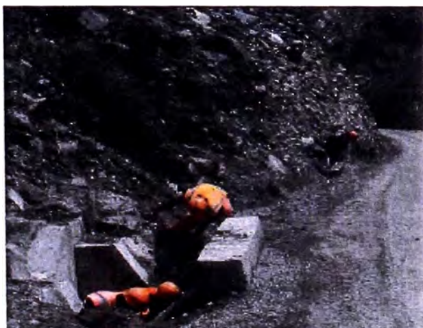
Figura 18: Limpeza de cunetas revestidas.
