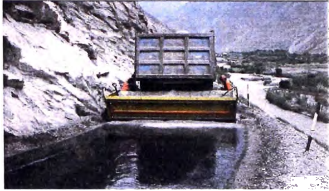
Figura 16: Colocación de sello asfaltico.
