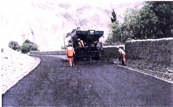
Figura 17: Colocación de mortero asfaltico.
