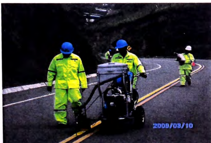
Figura 22: Pintado de marcas en el pavimento.
