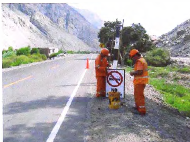
Figura 19: Reposición de señales verticales.
