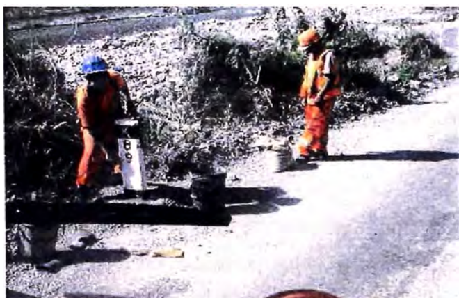
Figura 29: Reposición de hito kilometrico
