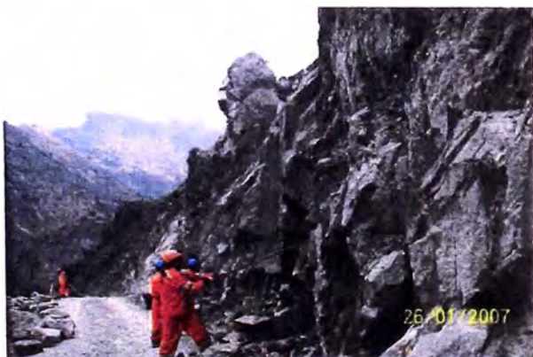
Figura 26: Desquinche Manual de Taludes
