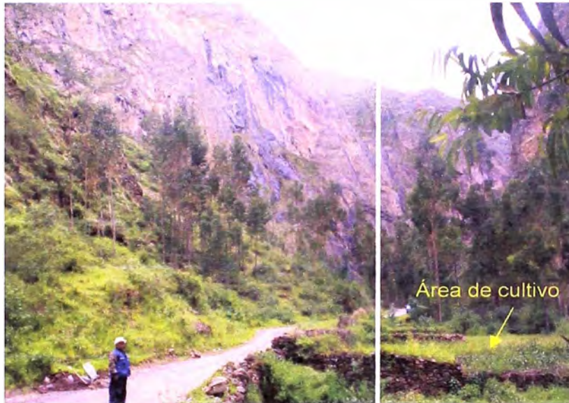
Foto 2.5. Km. 166+900. Vista adelante. Sector de trazo con menor corte proyectado.
