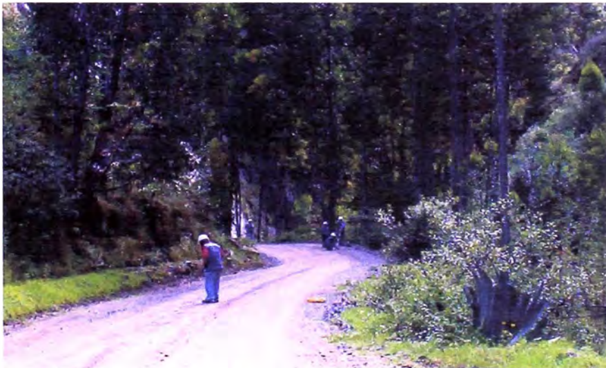
Foto 2.6. Km. 167+000. Vista hacia adelante.
