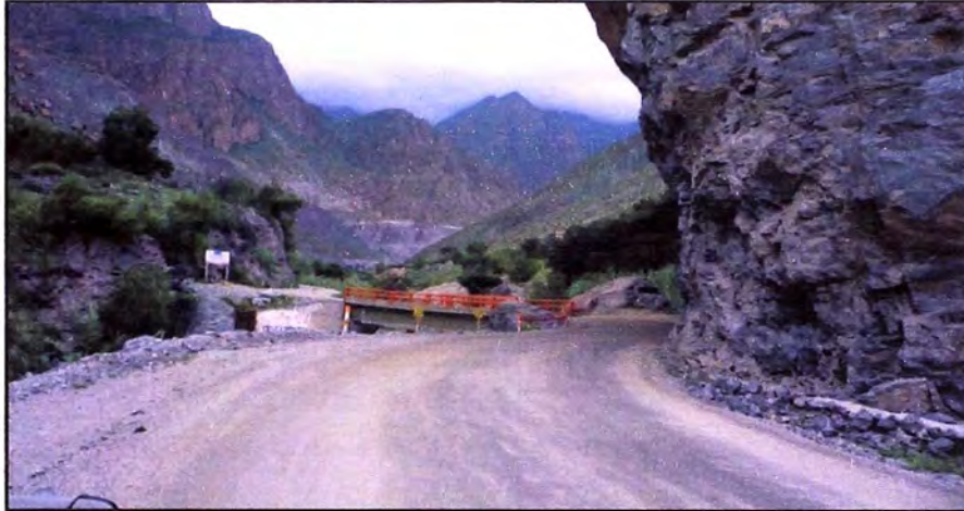
Foto 2.10. Km. 85+500. Puente Matica.
