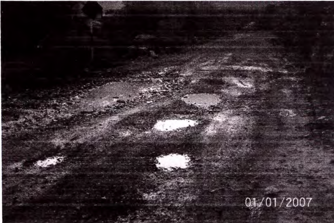
FOTO N° 03: Daños superficiales en tramo no asfaltado
