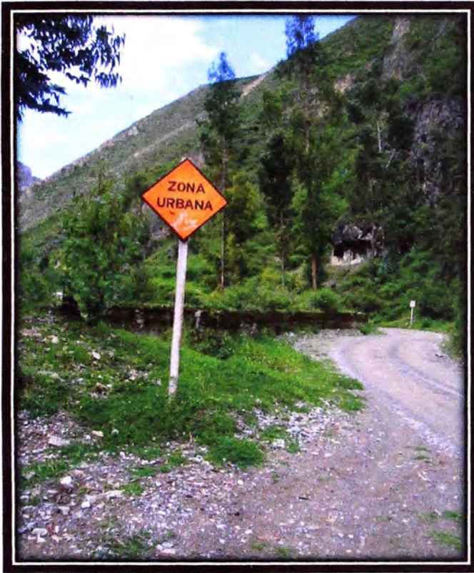
Foto N03. Señalización en Mal estado.
