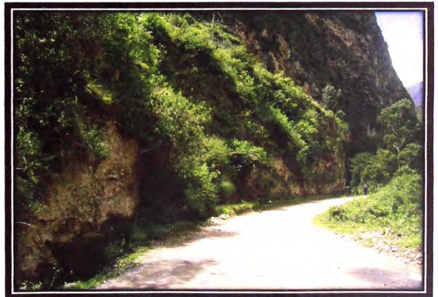
Foto N06. Taludes a cortar
