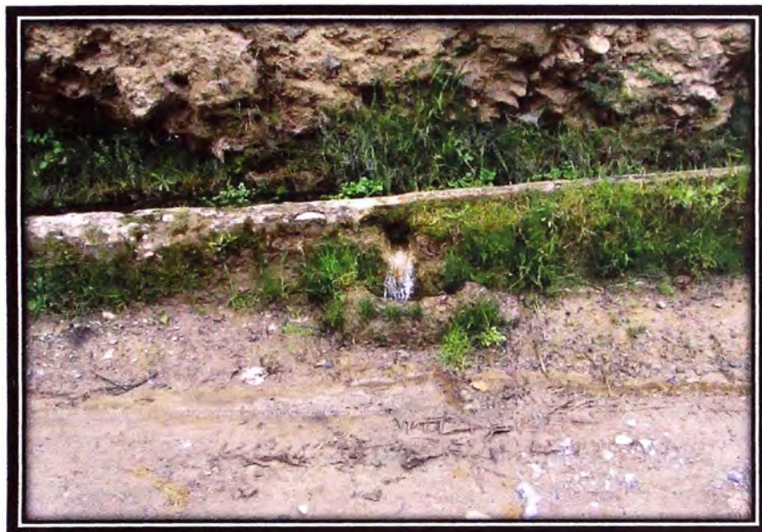
Foto N07. Presencia de Obras de Arte
