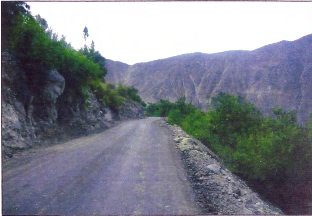
FOTOGRAFÍA 3. Ruta de Acceso al Tramo en Estudio
