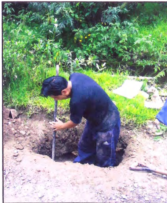
FOTOGRAFÍA 6. Realización de Calicata
