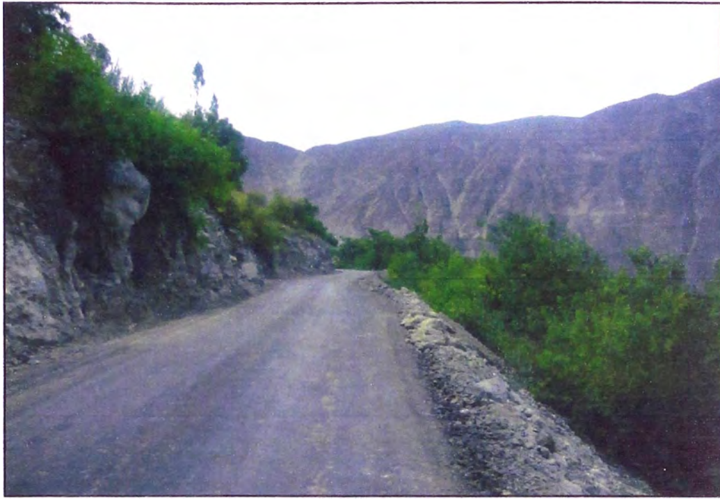
FOTOGRAFÍA 3. Ruta de Acceso al Tramo en Estudio
