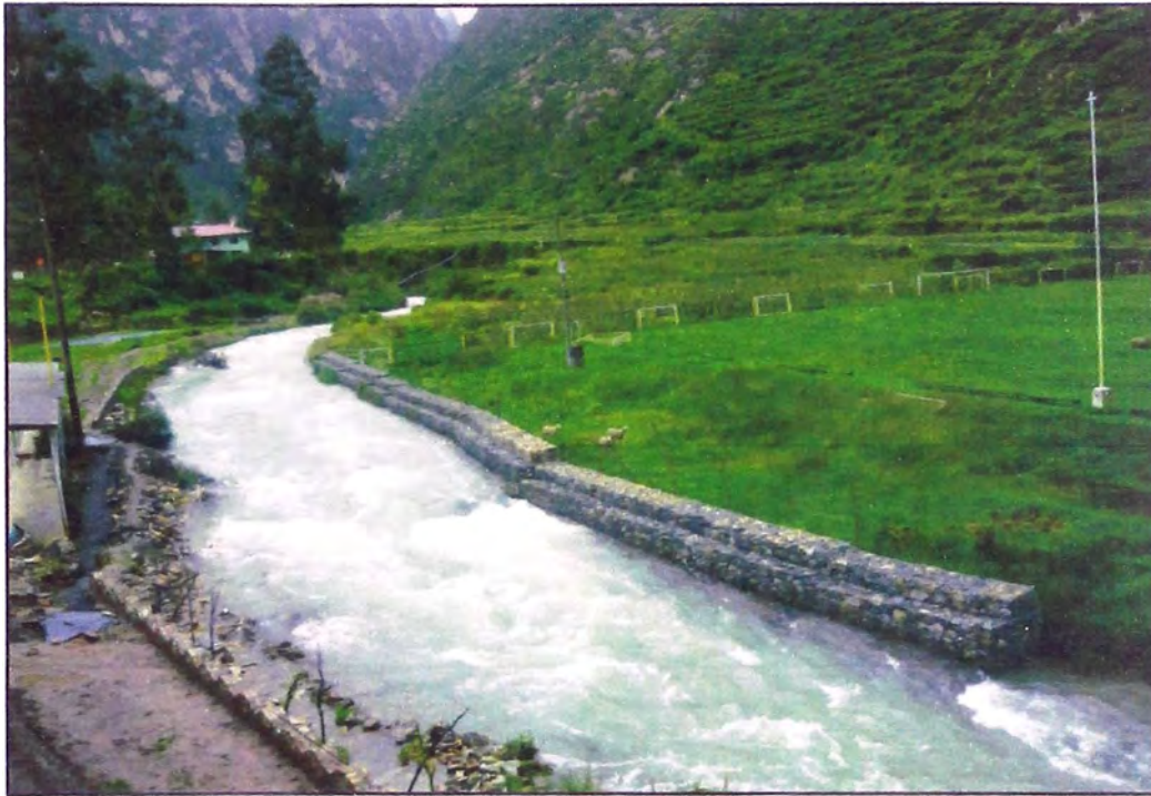
FOTOGRAFÍA 5. Protección de Ribera a la altura del Km. 164
