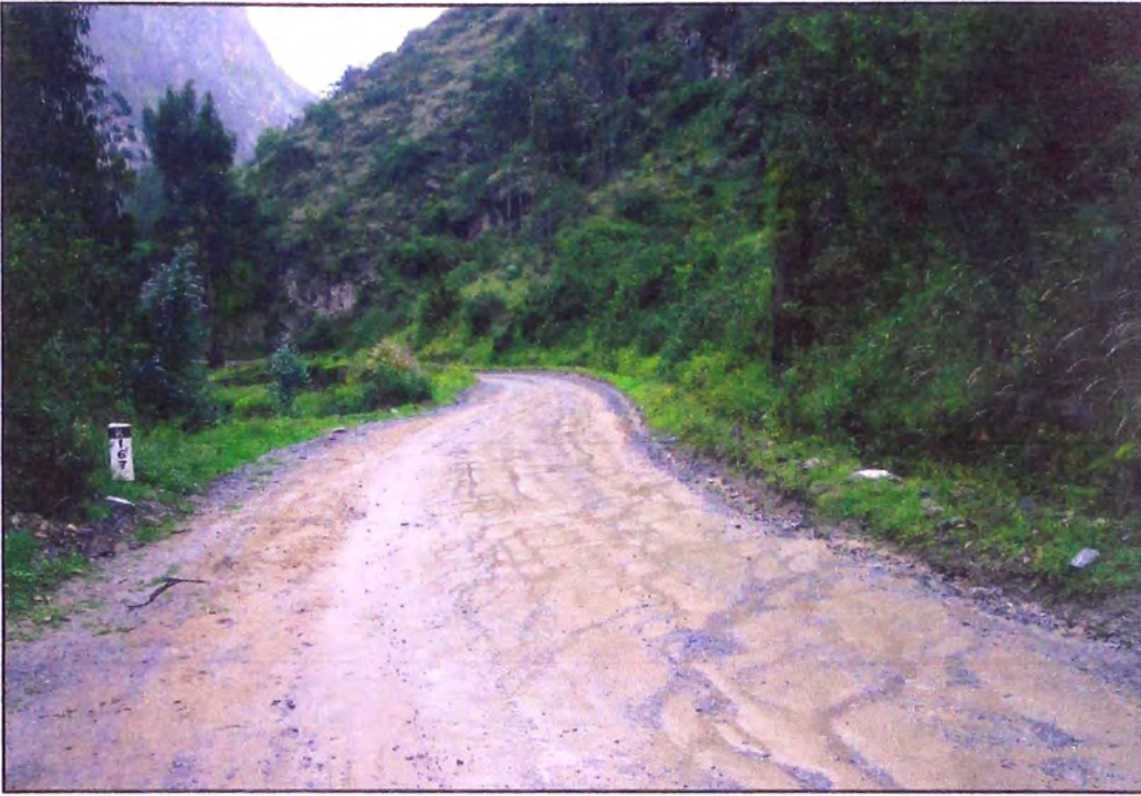
FOTOGRAFÍA 7. Progresiva 167+020 – Vista atrás
