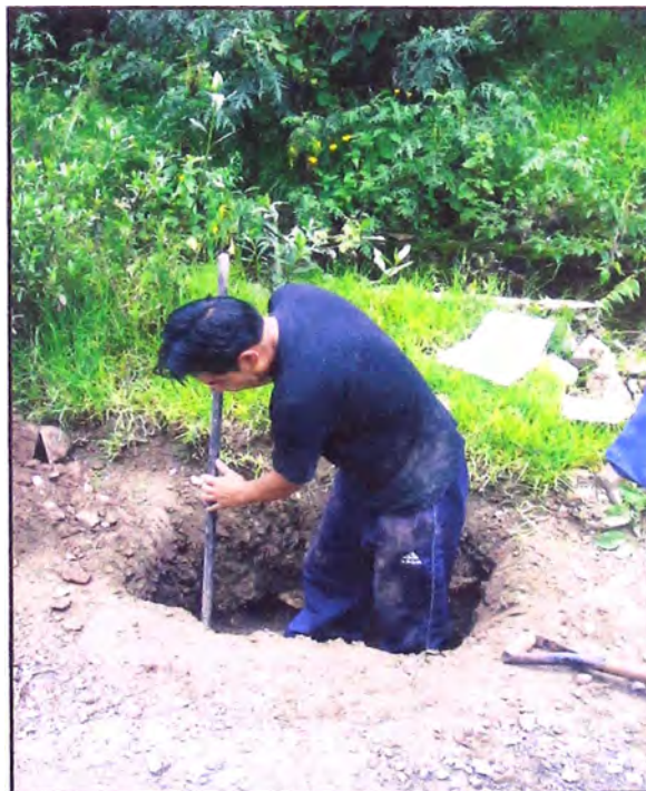
FOTOGRAFÍA 6. Realización de Calicata
