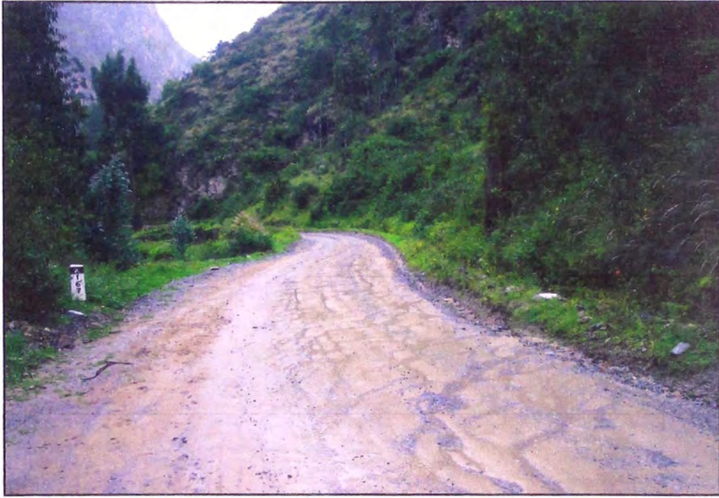
FOTOGRAFÍA 7. Progresiva 167+020 – Vista atrás
