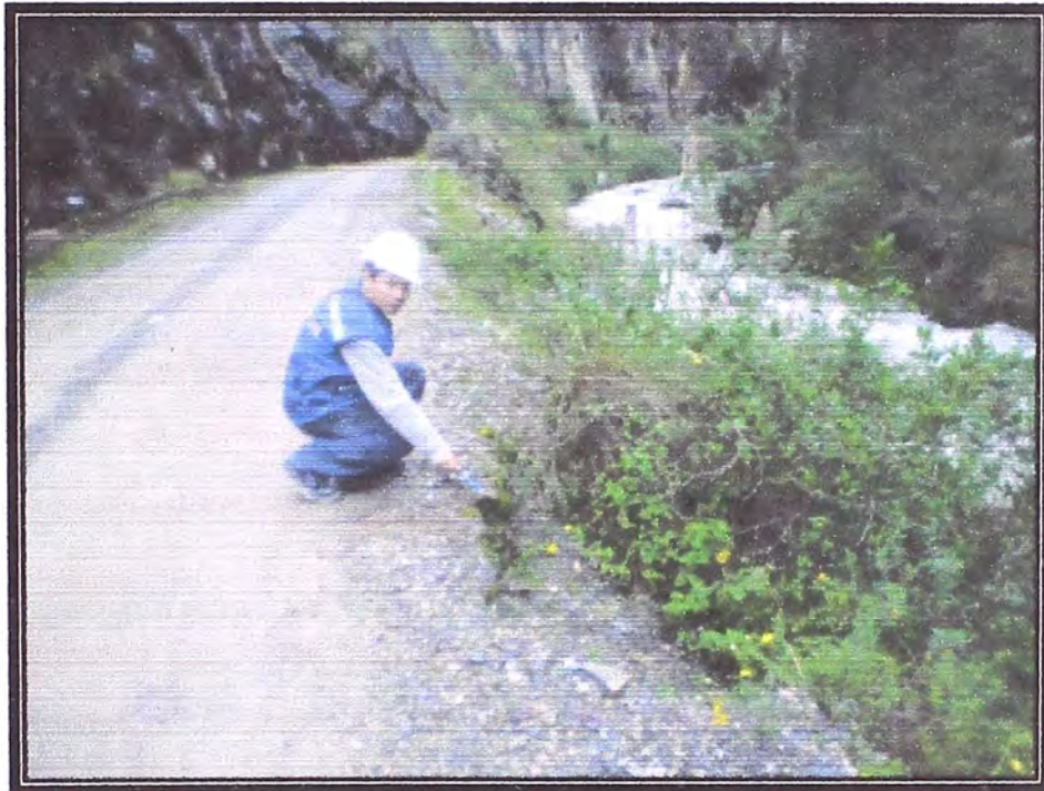
Figura Nro. 3.1.4-2: Erosión de Plataforma
