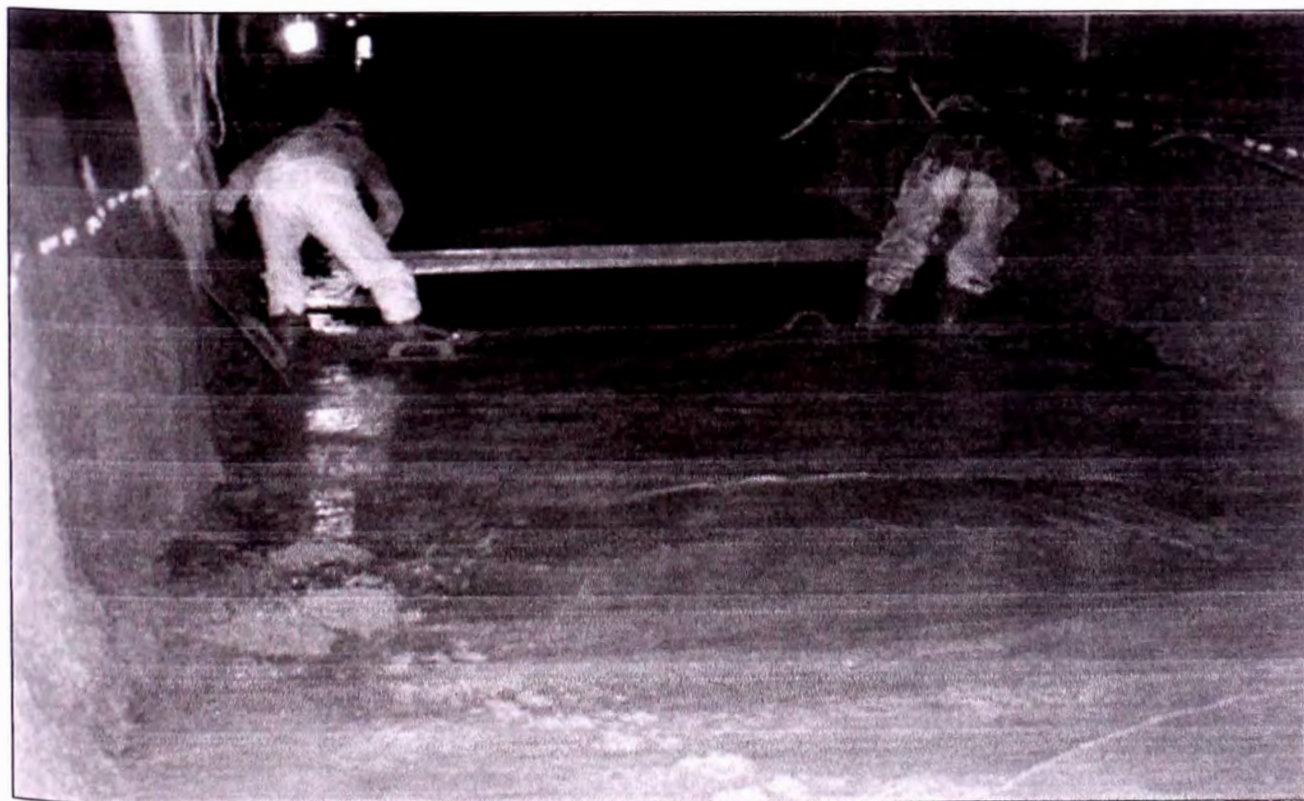
FOTO N° 04 - CONCRETADO PISO TUNEL DE ADUCCION
