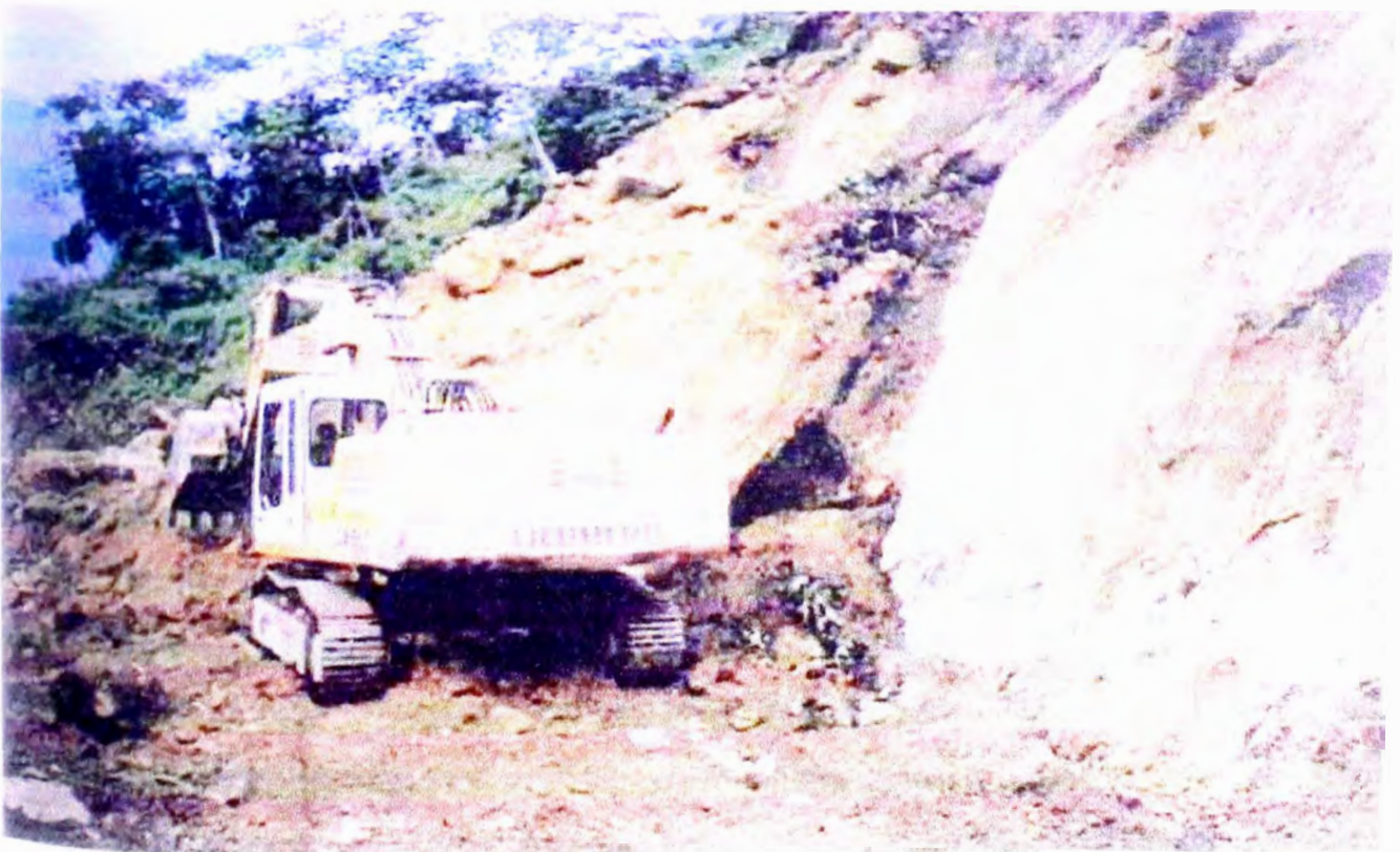
FOTO N° 28 - ELIMINACION DE DERRUMBES ACCESO CASAHUIRI
