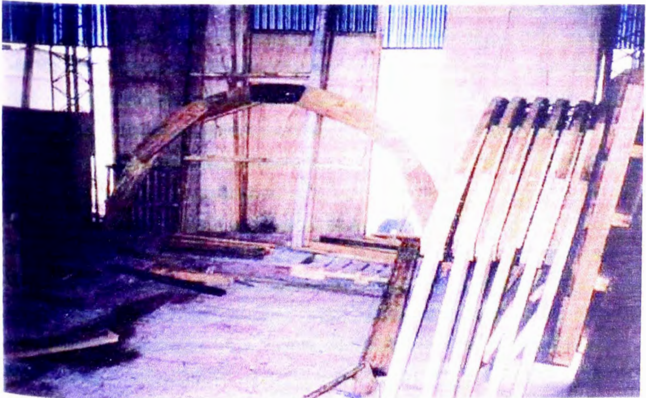
FOTO N° 26 - CERCHA PARA ENCOFRADO DE TAPON URUHUASI
