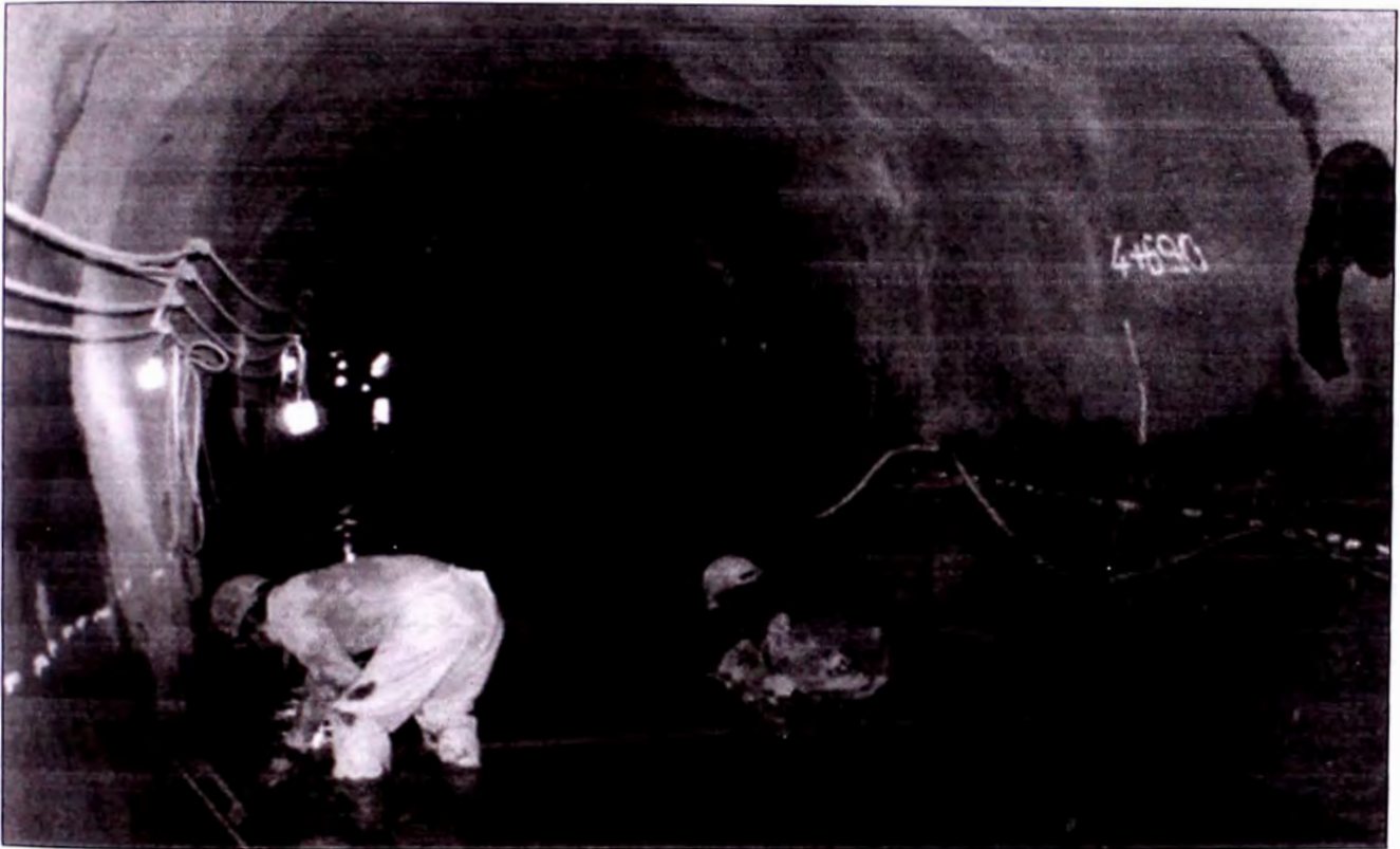
FOTO N° 05 - CONCRETADO PISO TUNEL DE ADUCCION
