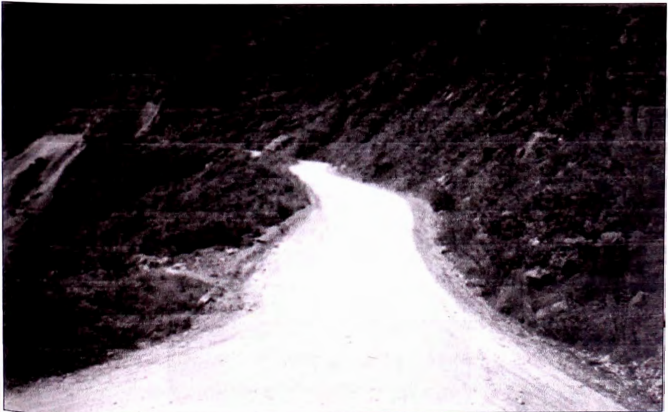
FOTO N° 06 - ACCESO VENTANA URUHUASI
