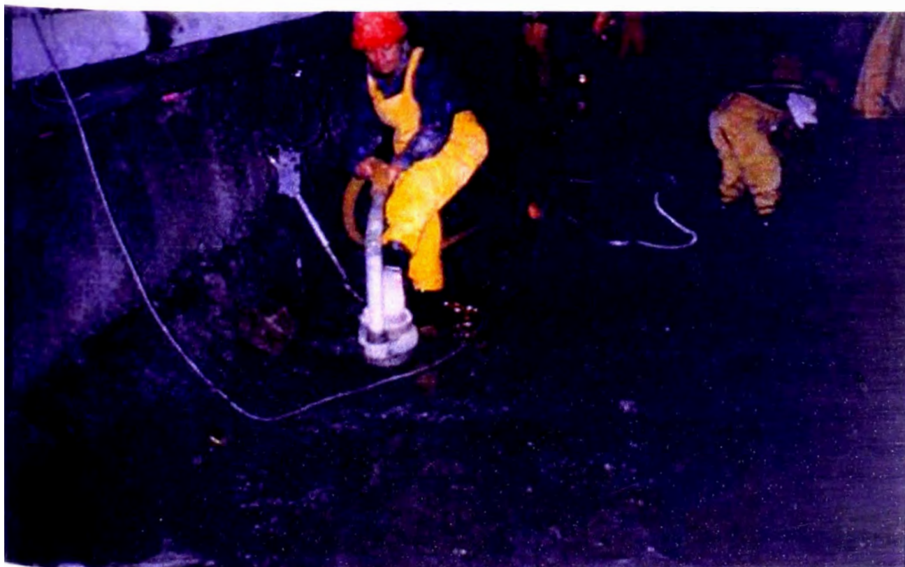
FOTO N° 24 - TRABAJOS PREVIOS PARA EL SOLADO DEL TUNEL
