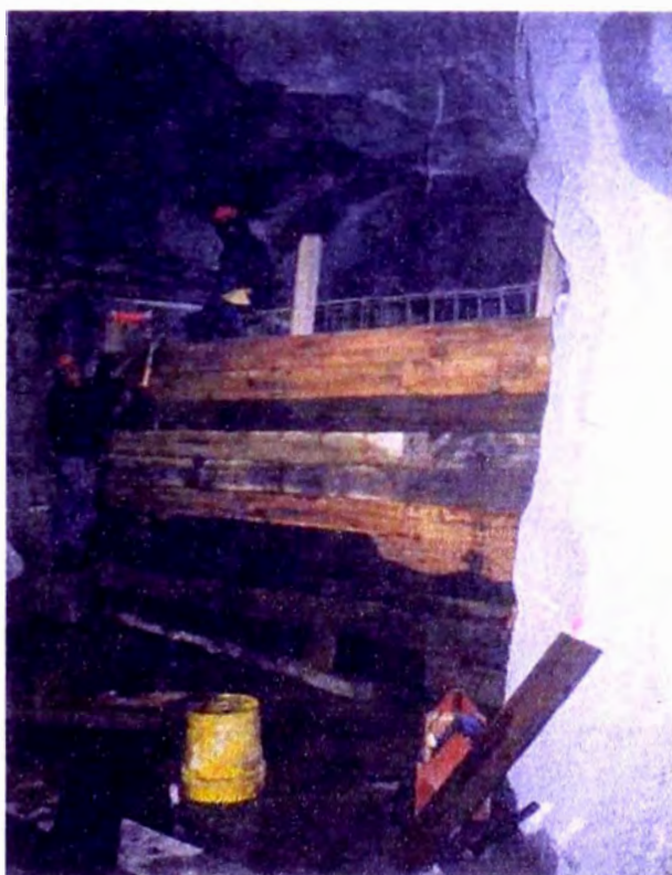
FOTO N° 22 - EJECUCION DE PANTALLA
