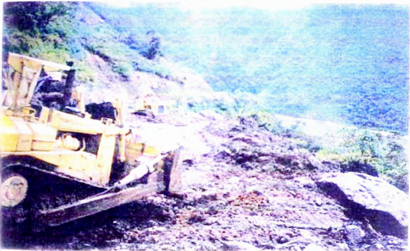
FOTO N° 29 - ELIMINACION DE DERRUMBES ACCESO CASAHUIRI
