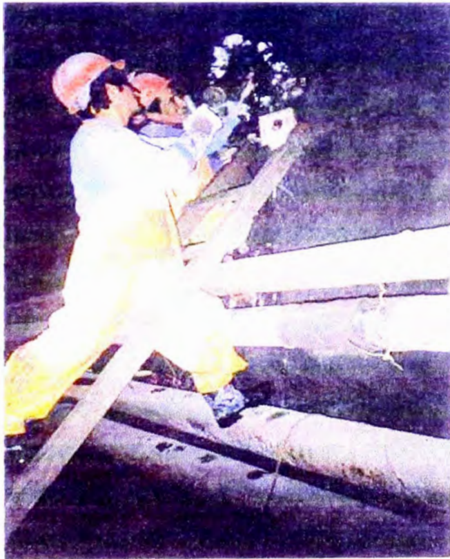
FOTO N° 30 - RELLENO DE PERNOS DE ANCLAJE CON LECHADA
