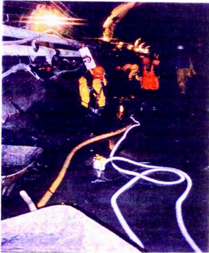
FOTO N° 25 - PREPARACION DE AREA PARA SOLADO DE TUNEL
