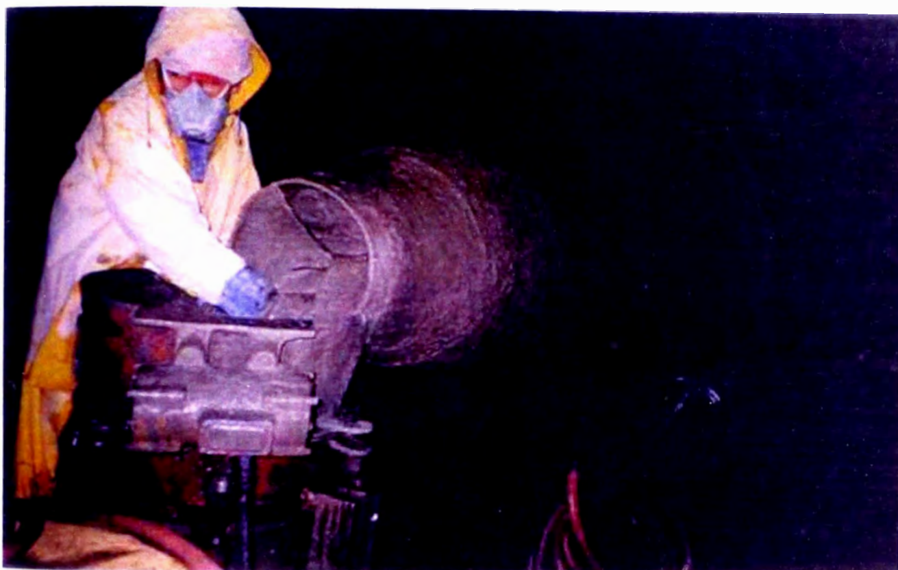
FOTO N° 23 - VAGON MIXER Y BOMBA SHOTCRETERA
