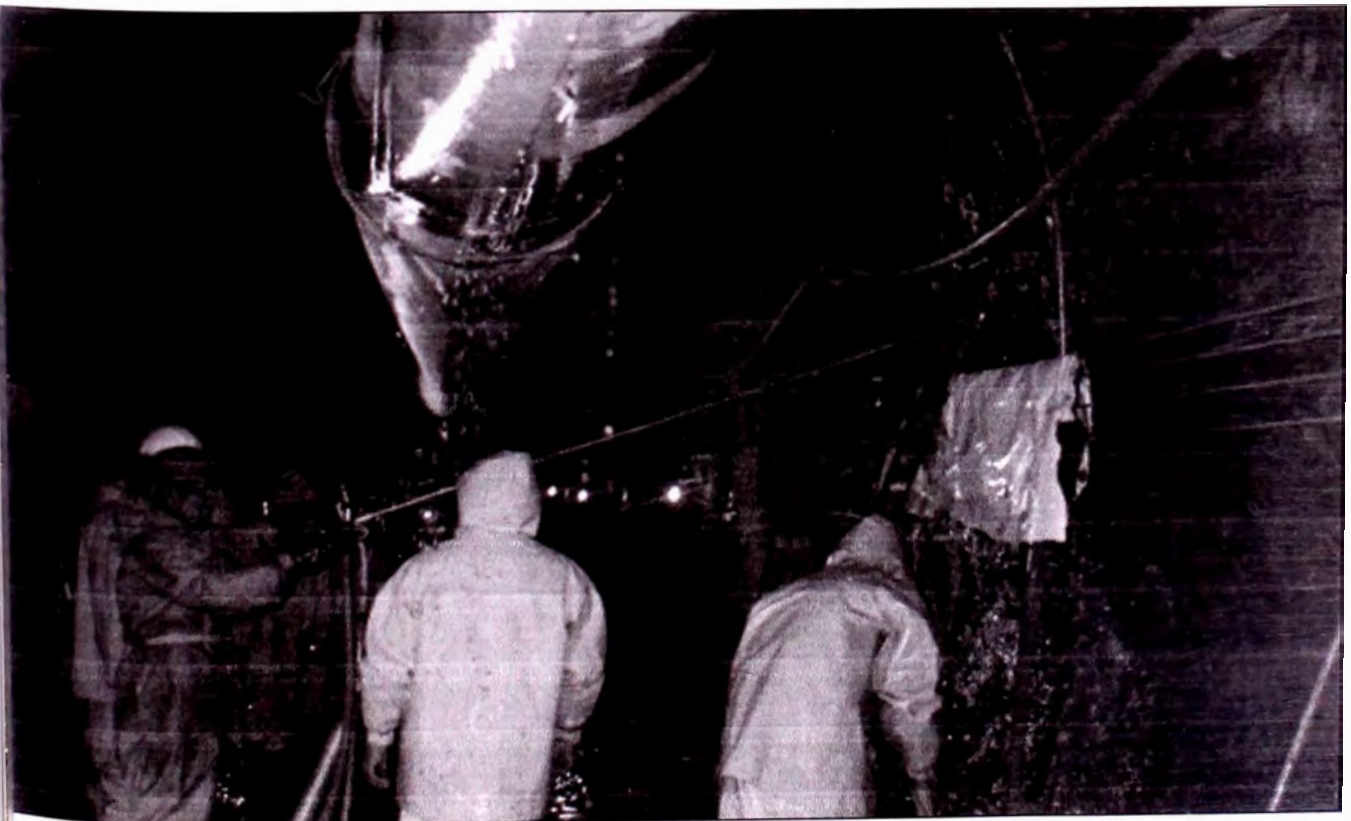
FOTO N° 02 - PERFORACIONES DE ALIVIO
