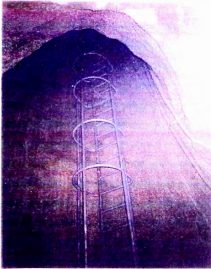
FOTO N° 27 - POZO DE VENTILACION
