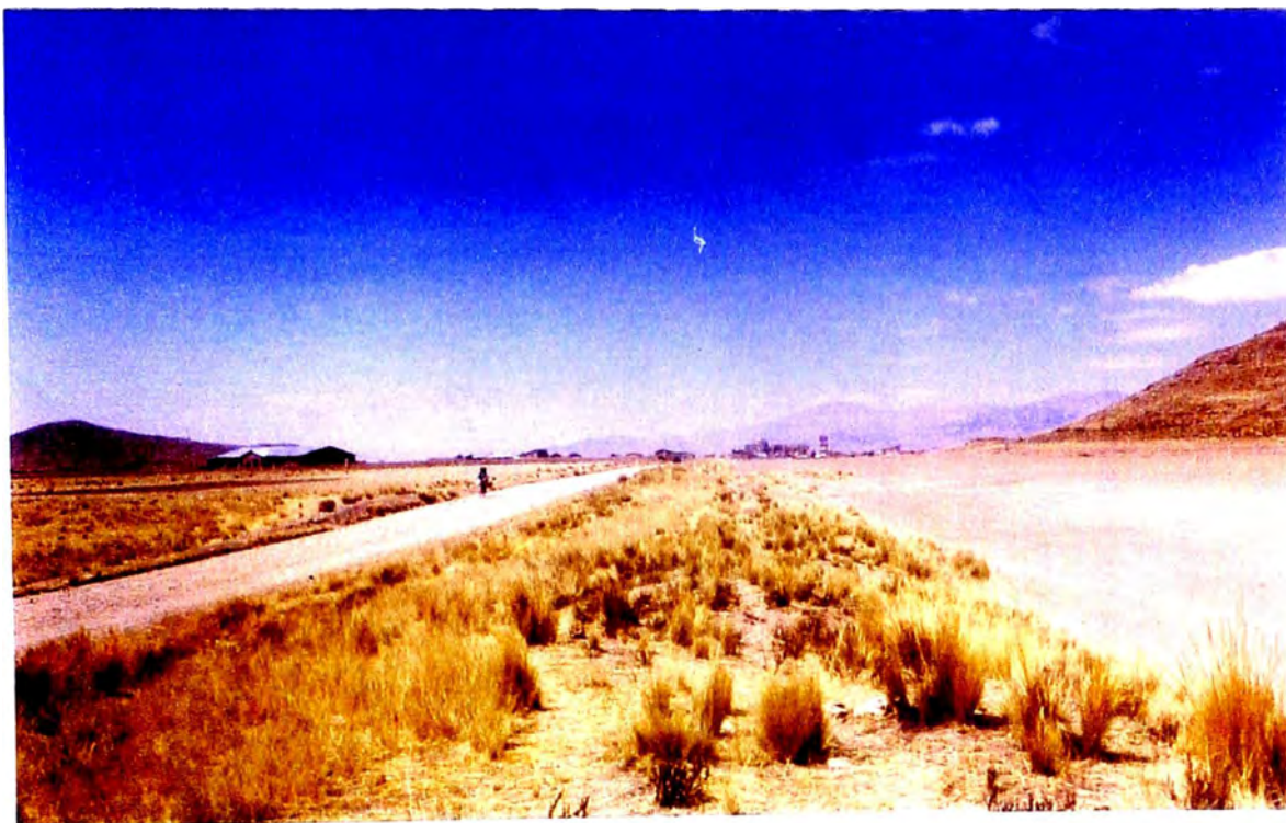
Foto N° 31 Km. 35+200, vista de la vía hacia Lampa, al fondo se observa dicha ciudad.
