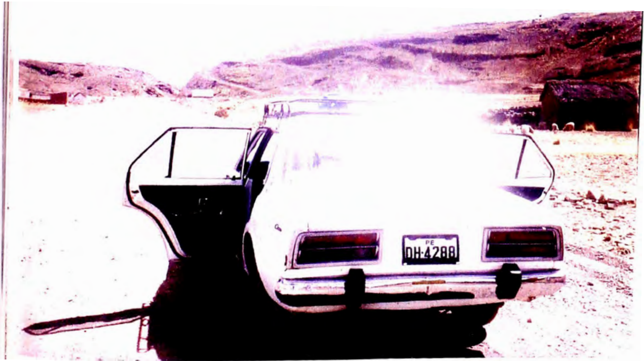
Foto N° 2 Vista del Km. 10+215 de la vía. Al fondo, paso en corte cerrado y a la derecha la cantera Picñan.
