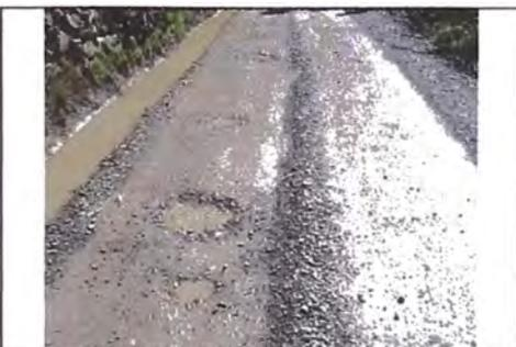
**FOTO N° 8:** Zona crítica tramo Km165+660 al Km 165+680; bacheo a causa de falta drenaje y bombeo.
