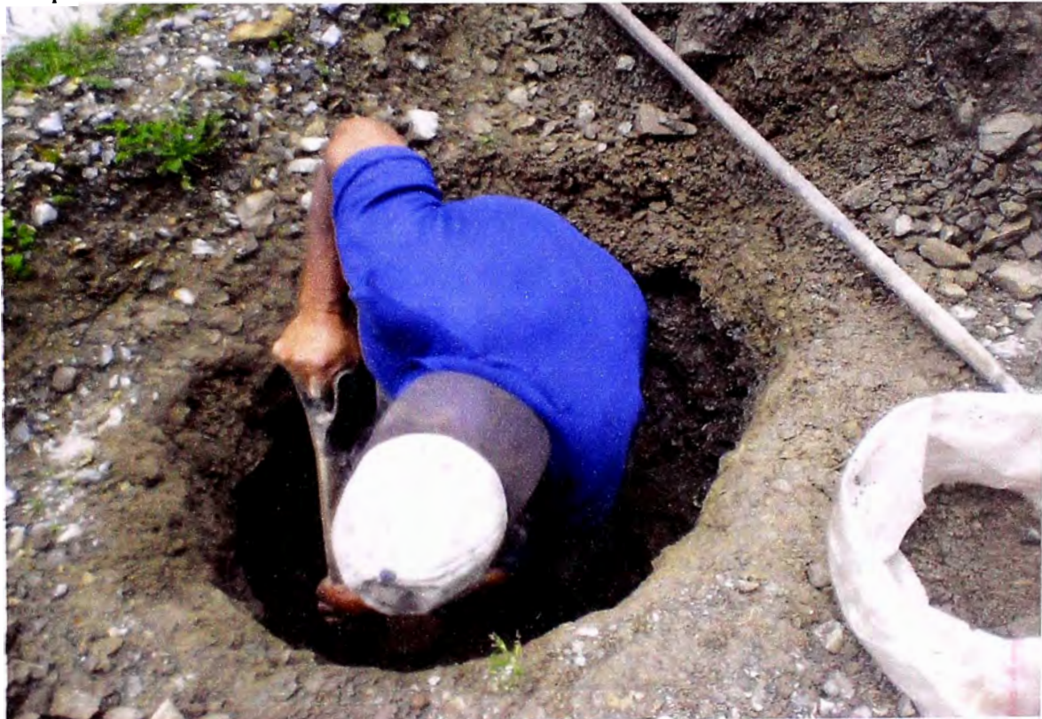
Foto N° 6: Excavación de Calicata para el Estudio de Suelos
