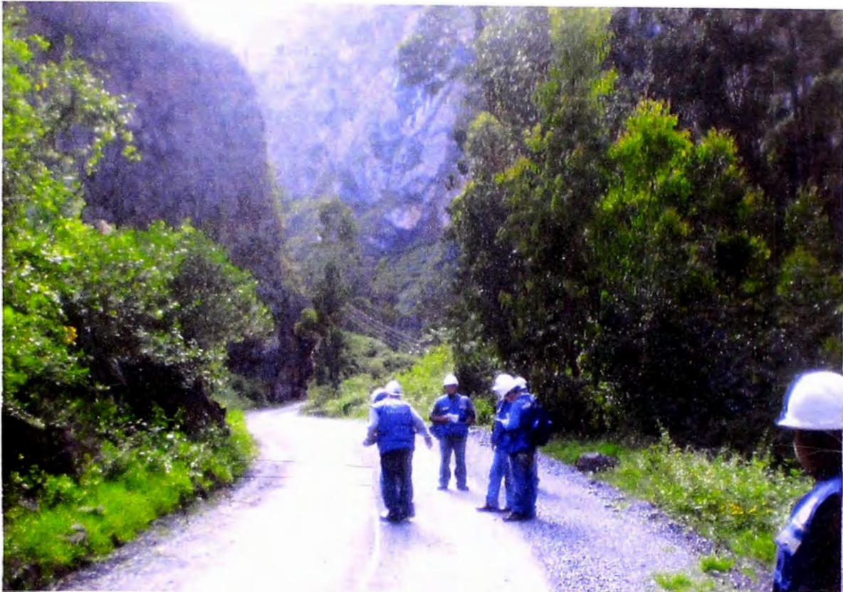
Foto N°3: Inicio del Tramo en estudio: Progresiva 167+100
