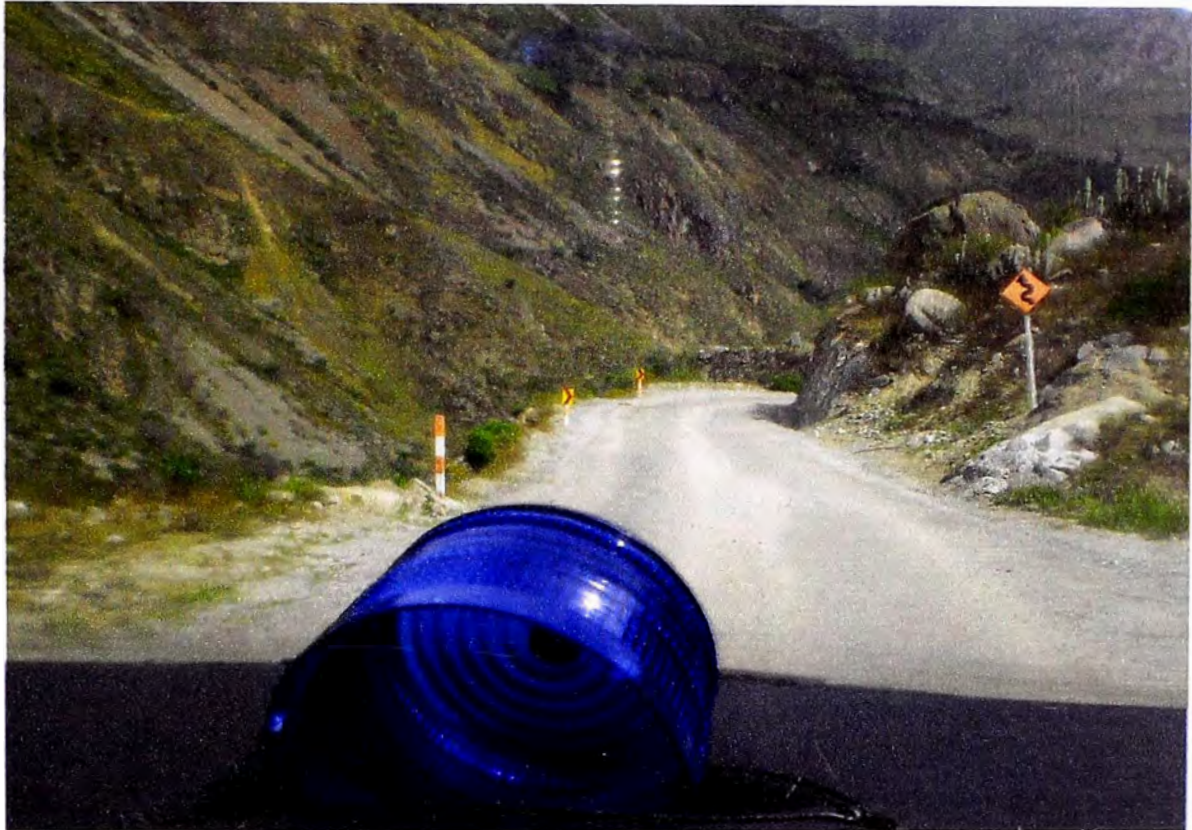
Foto N° 7: Elementos de seguridad existente a lo largo de la Carretera producto de los Trabajos de Conservación Vial de la Empresa ICGSA
