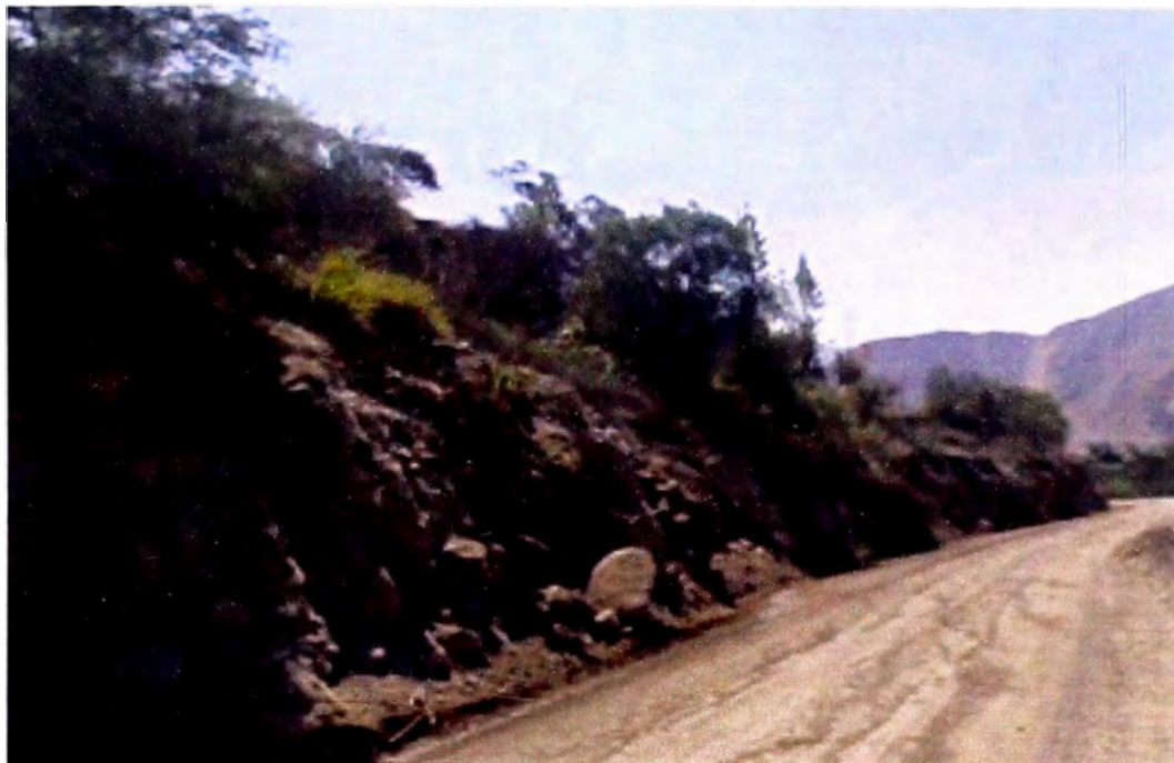
LUGAR DONDE SE CONSTRUIRA EL MURO DE CONTENCION
