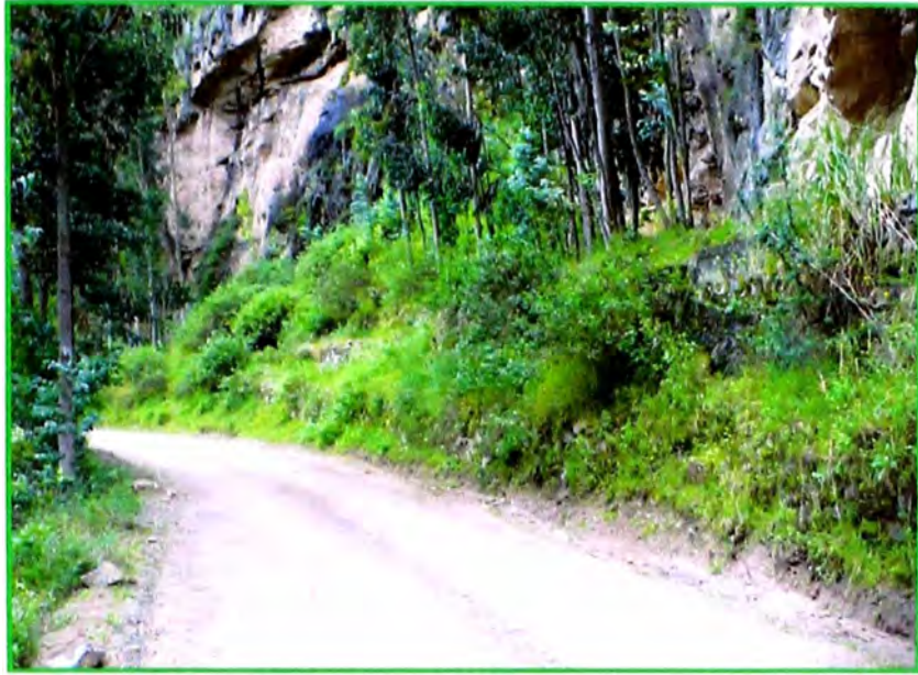
Zona que será sometido a corte y desbroce ubicado entre la progresiva Km. 165+ 820 al Km. 165+800
