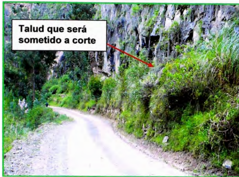
Zona de talud que será sometida a corte ubicado en la progresiva Km. 165+860
