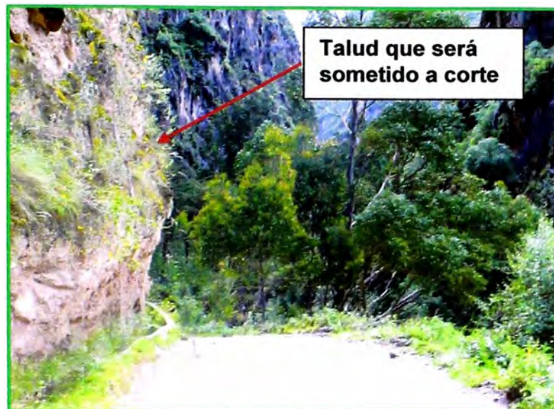
Zona ubicada en la progresiva Km. 165+640, que será sometida a corte
