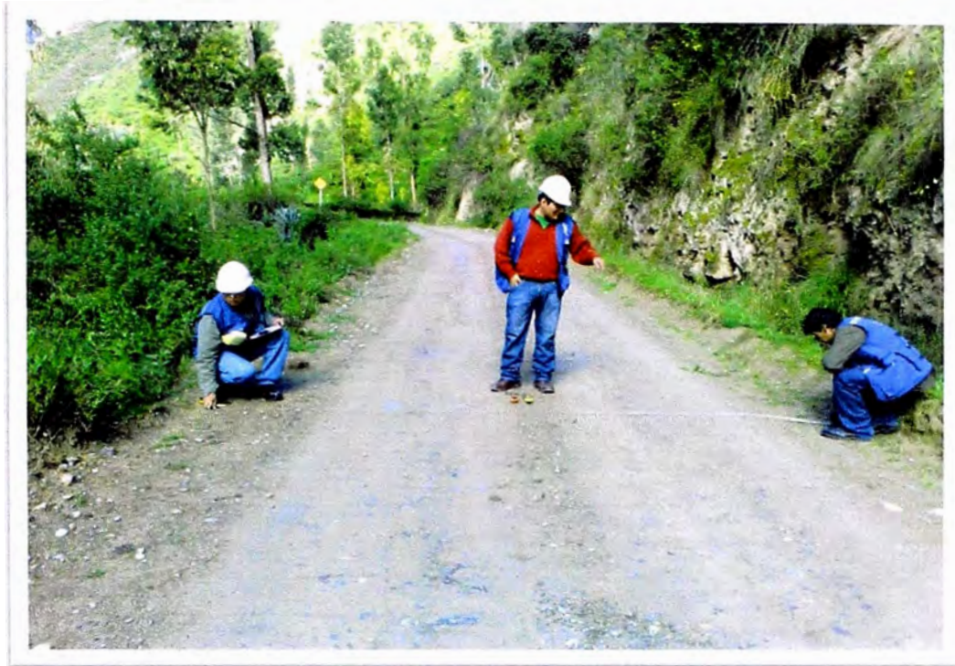
Foto N°1: Grupo 03 realizando el levantamiento de las secciones en el tramo asignado, 165+600 al 165+900.
