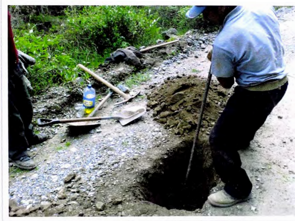
Foto N° 4: Grupo 03 registrando calicatas.
