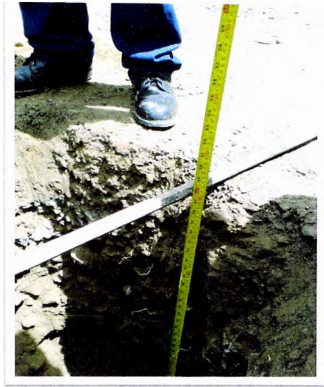
Foto N° 5: Grupo 03 registrando profundidad de calicatas.
