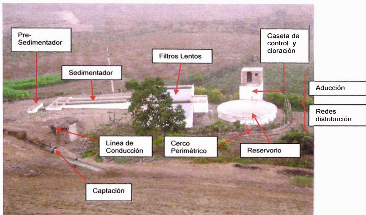
FOTO N° 4. 1 SISTEMA DE ABASTECIMIENTO DE AGUA EXISTENTE EN SANTA MARÍA ALTA
