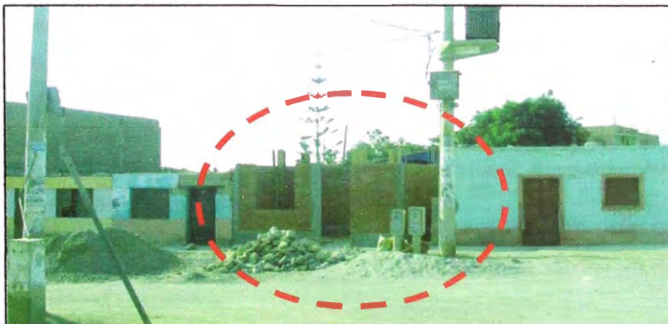
FOTO N° 2. 2 AUTOCONSTRUCCIÓN DE VIVIENDAS
