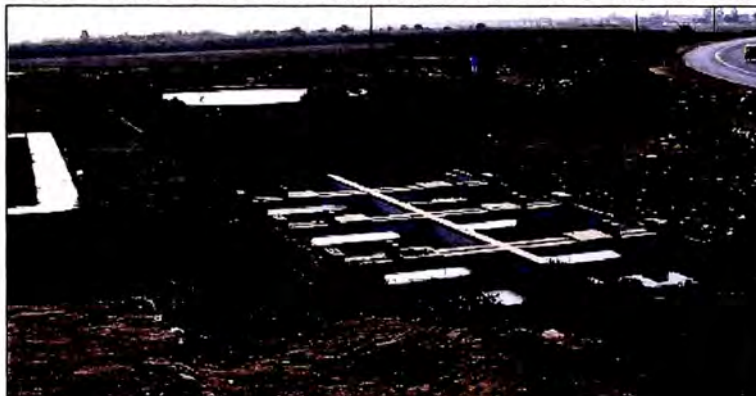
FOTO N° 2. 2 PLANTA DE TRATAMIENTO DE NUEVO IMPERIAL
