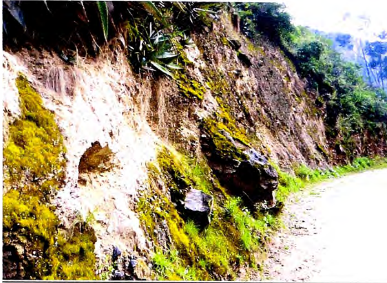
Figura N° 2.1.3: Tramo entre el Km. 164+540 al Km. 164+640, presencia de conglomerado
