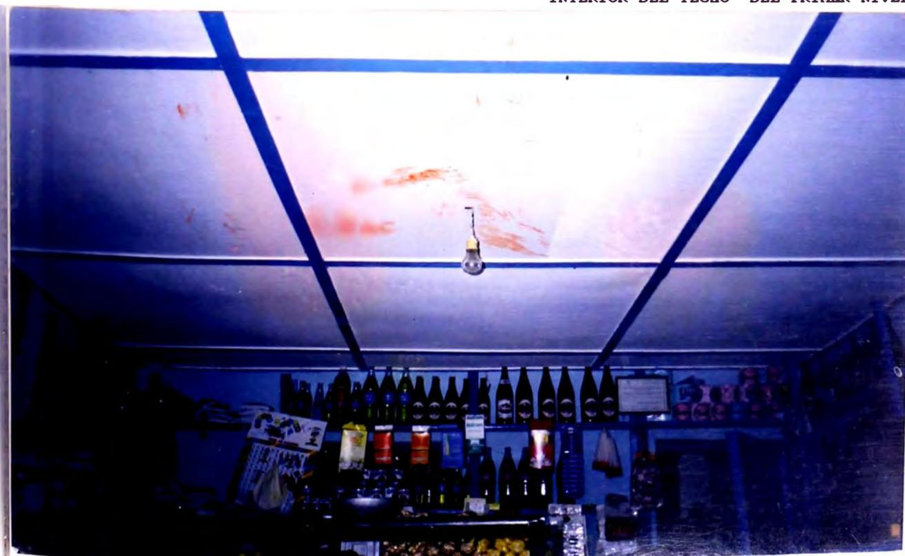
**FOTO N° 51:** EL MATERIAL EMPLEADO PARA EL ACABADO ES TRIPLEPLY, ESTOS ESTAN SUJETADOS AL ENTABLAJO DEL TECHO MEDIANTE MADERAS DE APROX. 1 CM. DE ESPESOR ESPACIADOS A CADA 0.80 M. EN AMBAS DIRECCIONES.
