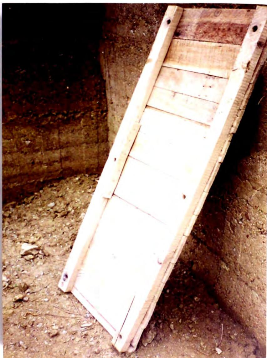
**FOTO N° 25: PARTE DEL ENCOFRADO PARA MOLDEAR EL TAPIAL.**
