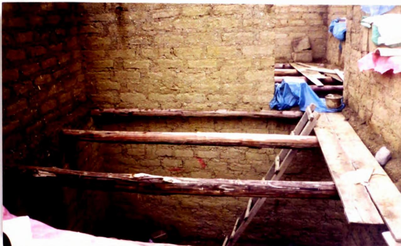
**FOTO N° 15:** PROCESO CONSTRUCTIVO DEL 2do PISO, COLOCACION DE VIGAS PRINCIPALES DE EUCALIPTO DE 4" DE DIAM. CUYA SEPARACION ENTRE ELIAS ES DE 1 MT Y EL ENTABLADO VAN SIENDO COLOCADAS EN FORMA PERPENDICULAR A LAS VIGAS.
