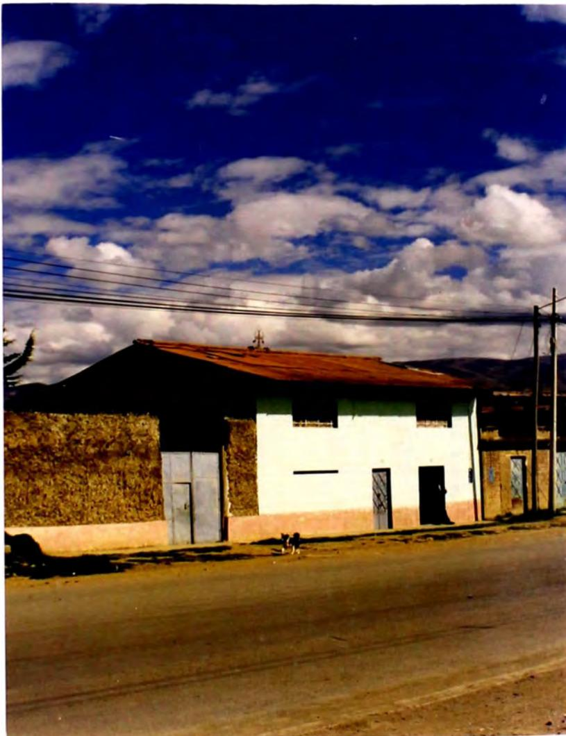
FOTO N° 14: TECHO TIPICO DE 2 AGUAS CON CALAMINA, VISTA DESDE EL EXTERIOR DE LA VIVIENDA
