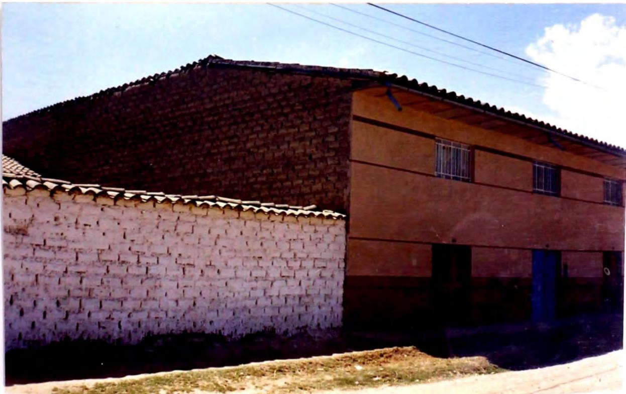
**FOTO N°17:** ENLUCIDO CON YESO Y PINTADO EN UNA VIVIENDA DE DOS PISOS EN UN AREA DE 54 M2
