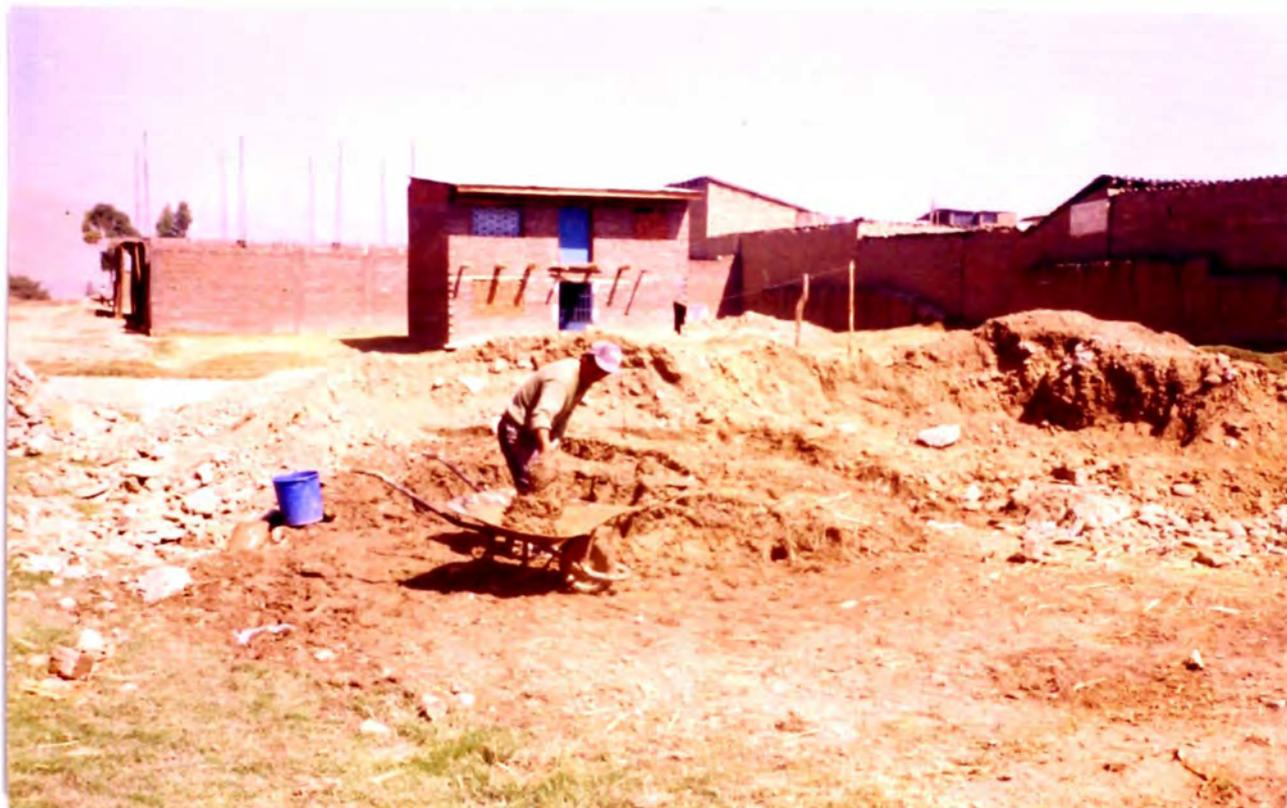
FOTO No 6: MEZCLADO Y TRASLADO DEL SUELO PARA SU MOLDEO LUEGO DE DORMIRLO 1 A 2 DIAS
