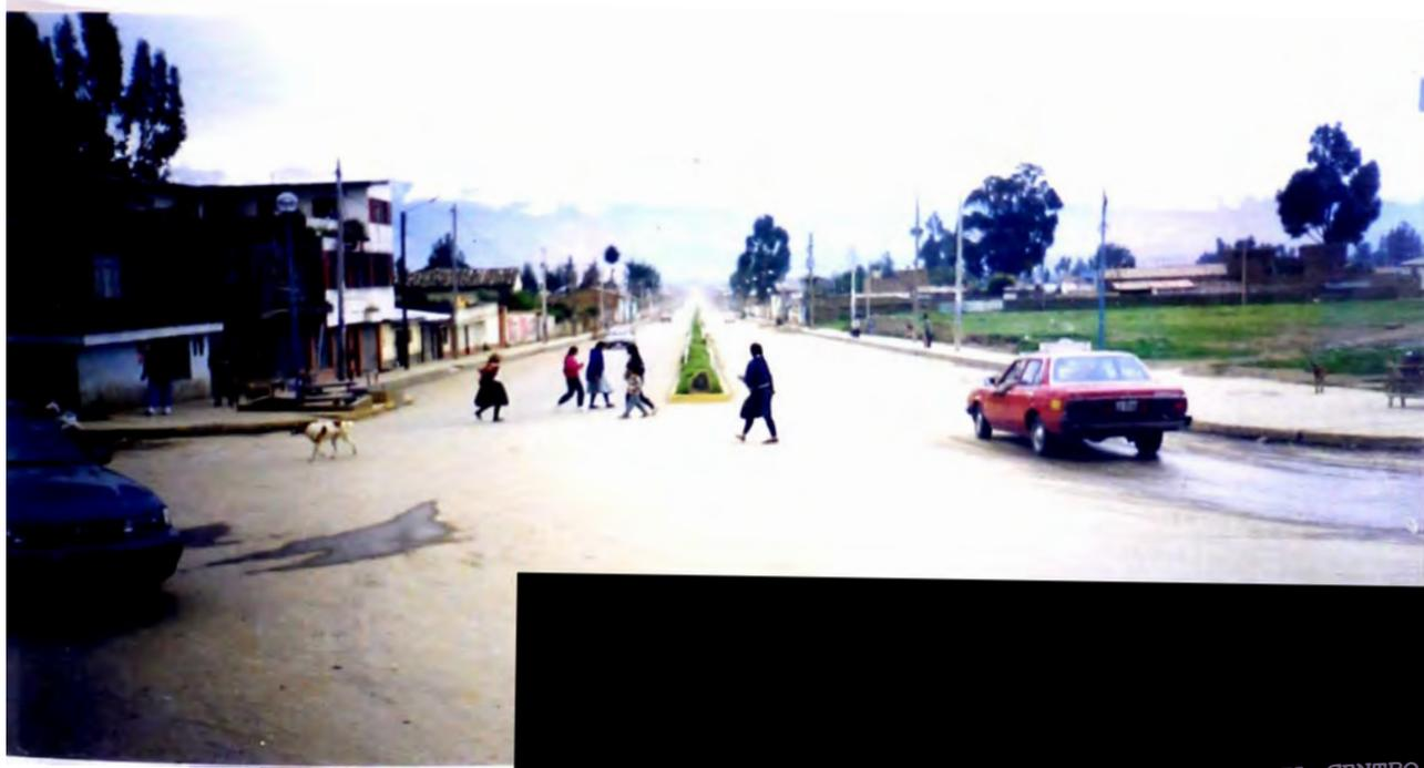
**FOTO N°55:** CUENTA CON 2 VIAS ASFALTADAS CADA UNO DE APROXIMADAMENTE 3.00 m. EN EL CENTRO DE LOS CUALES TIENE UNA BERMA CENTRAL DE 1.20 m. Y EN LOS EXTREMOS LAS VEREDAS DE 1.80 m. ADEMAS CUENTA CON SISTEMAS DE DRENAJE EN LOS EXTREMOS, AUNQUE SU MANTENIMIENTO NO ES MUY BUENO. EL TRANSITO DE VEHICULOS ES REGULAR.
