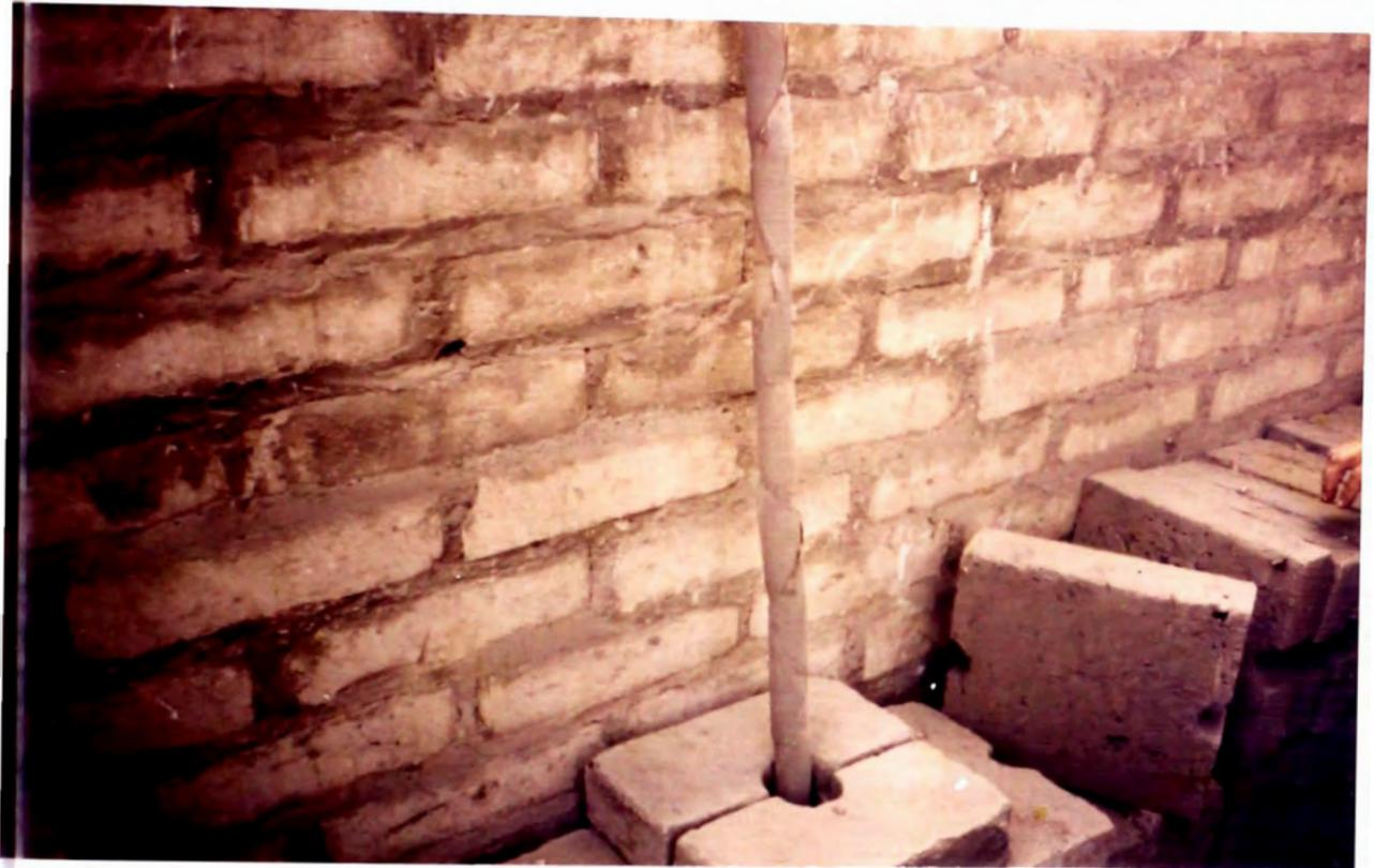
**FOTO N° 90:** SE MUESTRA COMO DEBE ESTAR UBICADO LA CAÑA DE REFUERZO DENTRO DE LOS BLOQUES DE ADOBE, MÁS NO IMPLICA UN MURO MEJORADO EN CONSTRUCCION.
