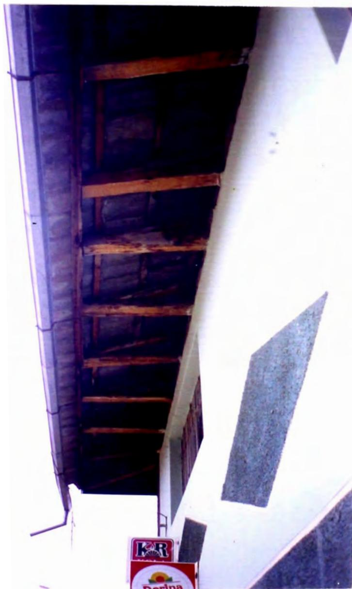
**FOTO N°52:** SE OBSERVA LA CANALETA DE SECCION RECTANGULAR QUE DRENA LAS AGUAS DE LLUVIA RECOLECTADAS POR EL TECHO. LOS APOYOS DEL ALERO TIENEN UN DIAMETRO APROX. DE 4". EL ALERO SOBRESALE APROXIMADAMENTE 0.60 M.
